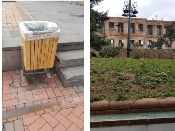
Şekil 5.31. Esmâ Sultan Yalısı ve Çevresinde Bulunan Donatı Elemanları
