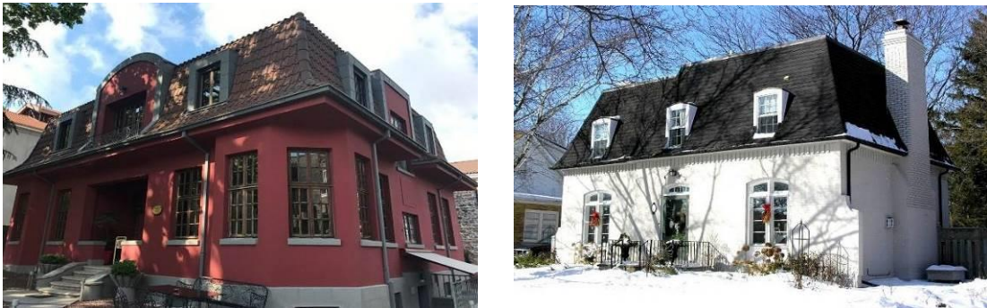
Şekil.28. Mansard Çatı Örnekleri [47]
