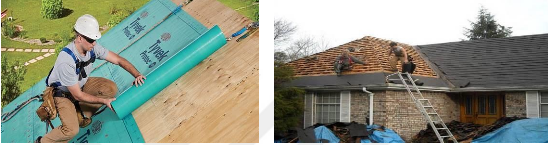
Şekil.61. Su Yalıtımının Uygulanması [66]
