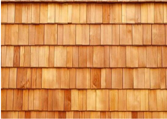
Şekil.43. Parçalı Ahşap Kaplama Mlz. [58] Şekil.44. Çıta Üzerine Uygulama [58]
