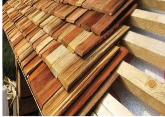
Şekil.43. Parçalı Ahşap Kaplama Mlz. [58] Şekil.44. Çıta Üzerine Uygulama [58]
