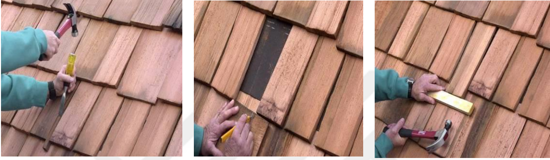
Şekil.69. Malzemenin Sökülerek Yenisiyle Değiştirilmesi [74]
