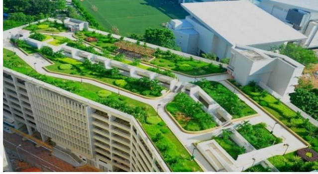
Şekil.33. Üzerinde Gezilebilen Bitkilendirilmiş Yeşil Çatı [33]
