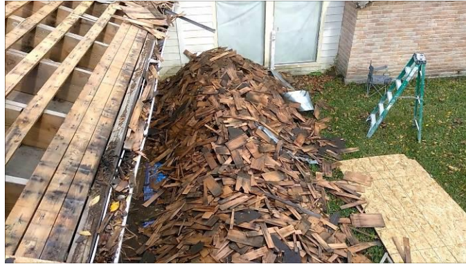
Şekil.70. Sökülen Kaplama Malzemelerin Geri Dönüşüme Hazırlanması [75]
