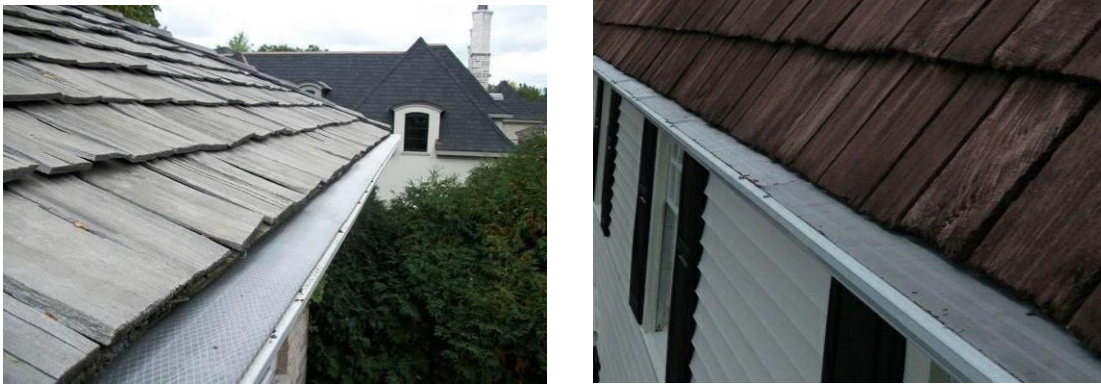
Şekil.65. Saçak ve Yağmur Oluğu Uygulamaları [69]
