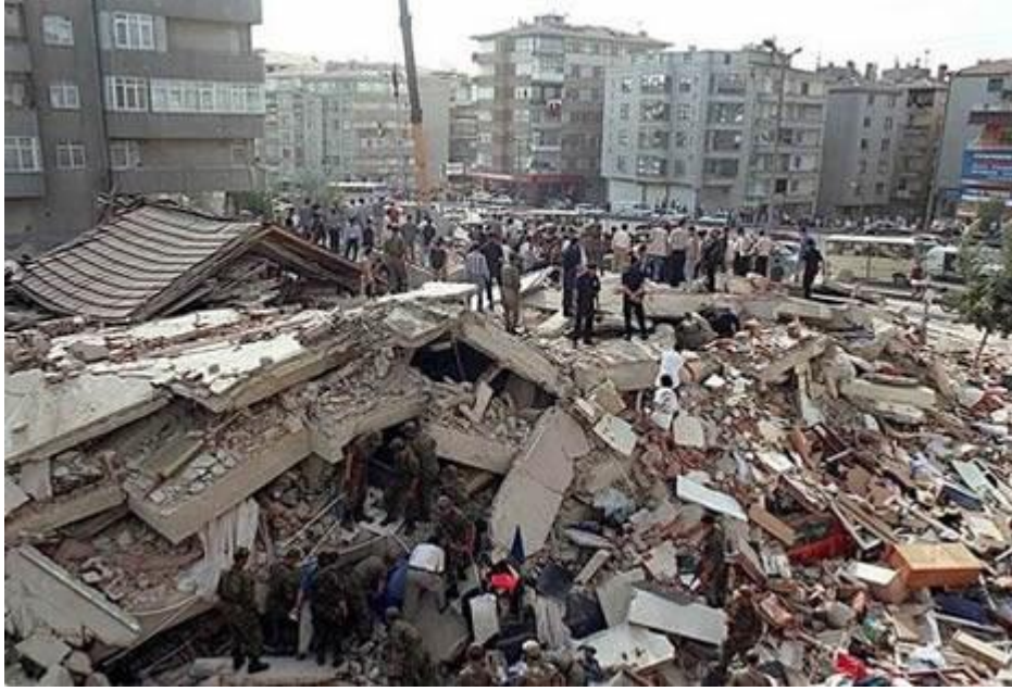
Şekil 5. 17 Ağustos Depremi Yıkılmış Bina Örneği
