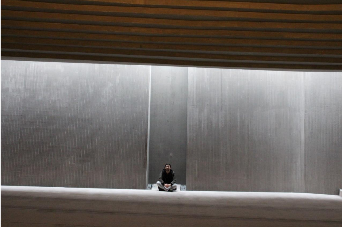
Şekil 4.11 : Sancaklar camii duvar tavan ilişkisi ve doğal ışık tasarımı
