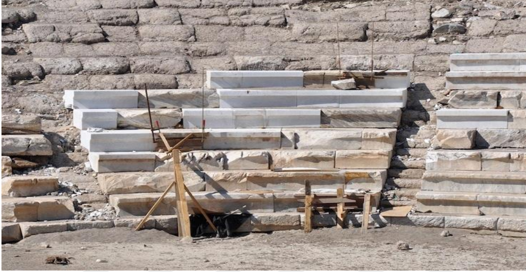
Şekil 3.2 Aspendos Antik Tiyatrosu Restorasyon Çalışması (url 6)
