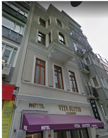
Şekil 5.16 Restorasyon Sonrası Cephe Görünümü
