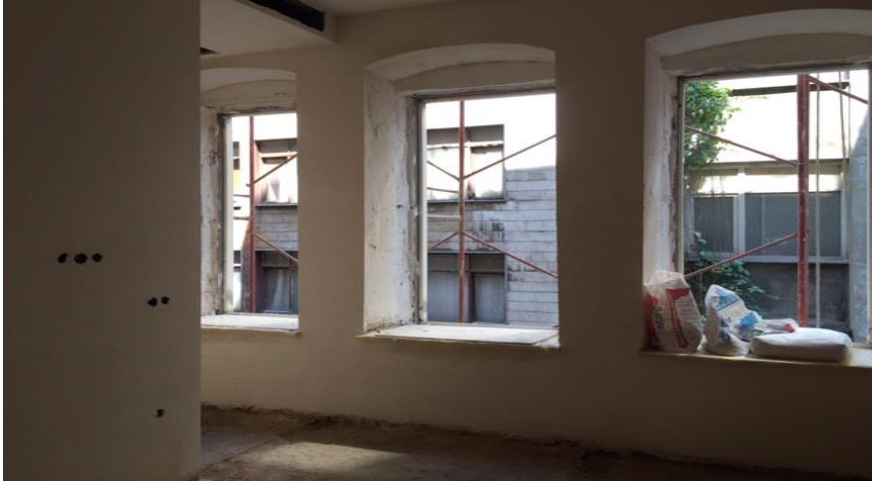
Şekil 5.6 Restorasyon Öncesi Odadan Görünüm
