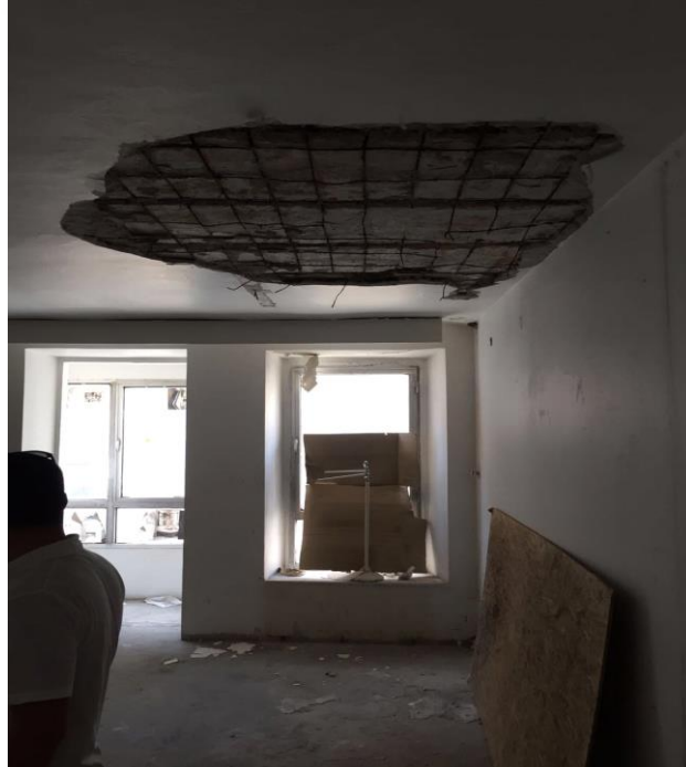
Şekil 5.1 Tavanda Meydana Gelen Bozulmalar
