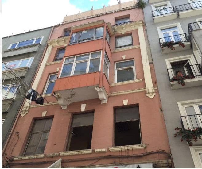
Şekil 5.7 Yapının restorasyon öncesi cephe görünümü
