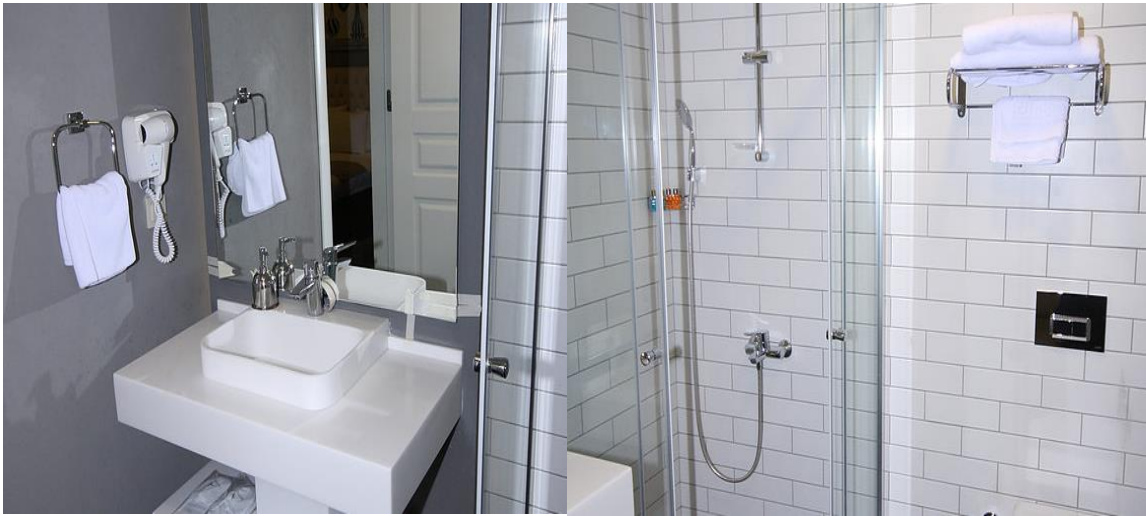
Şekil 5.18 Restorasyon Sonrası Banyo Görünümleri
