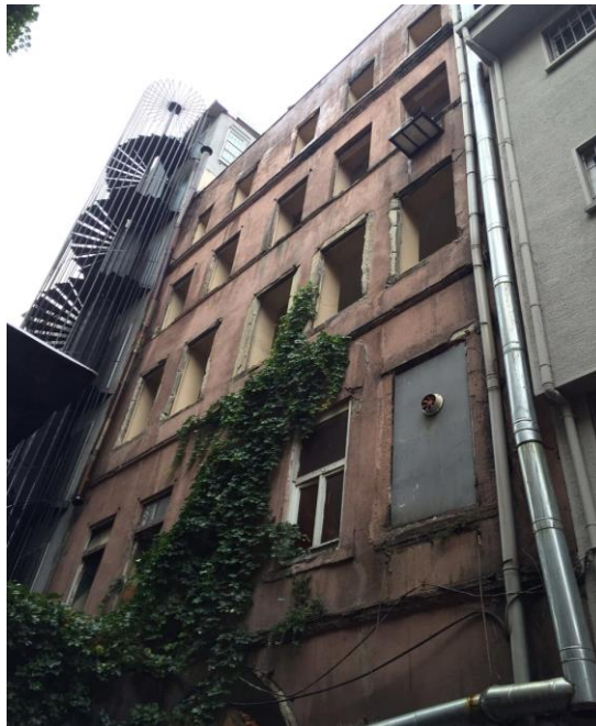
Şekil 5.3 Restorasyon Öncesi Arka Cephe Görünümü
