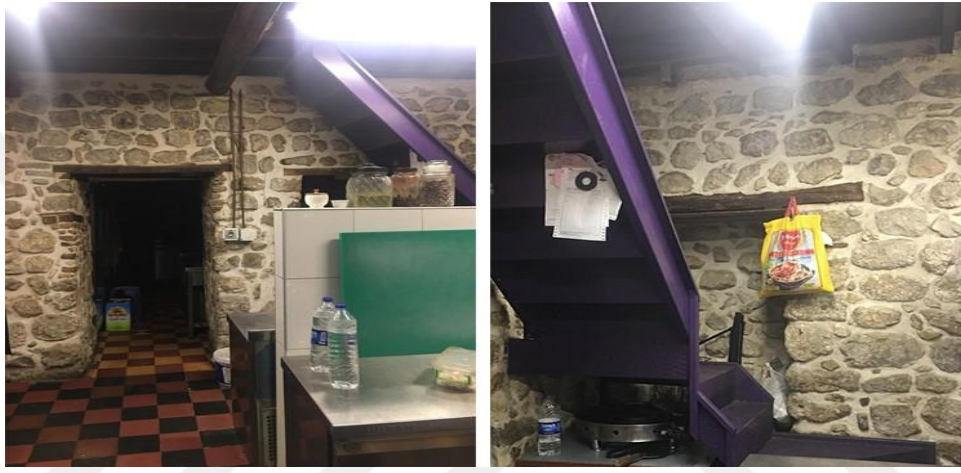
Şekil 92. Mutfak mekanında çağdaş ek olarak yapılmış merdiven
