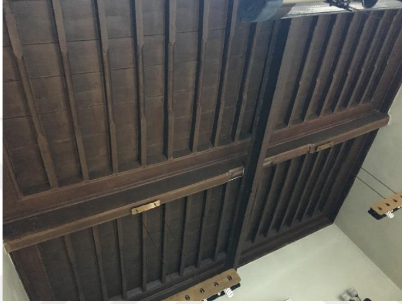
Şekil 30. Ahşap kirişleme sistemiyle yapılan tavan örneği
