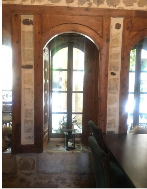
Şekil 74. B kodlu mekanın taka arası görünüşü
