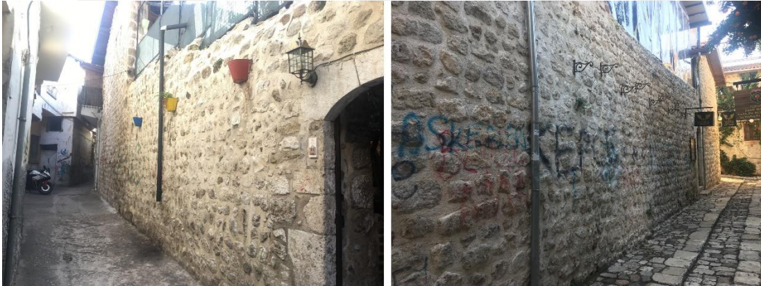
Şekil 24. Sağır avlu duvarının dış cepheden görünüşü
