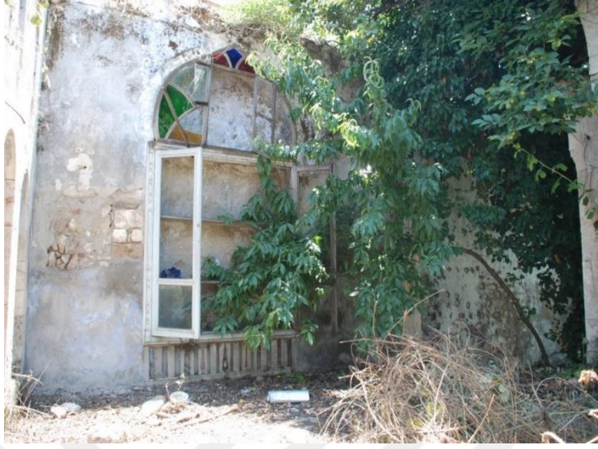
Şekil 77. Restorasyon öncesi sekide bulunan mahmel
