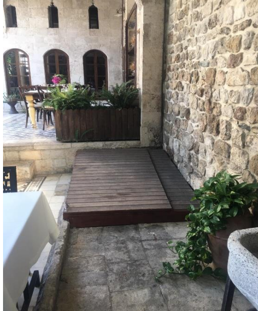
Şekil 80. Restorasyon sonrası üstü kapatılan mahzene giriş merdiveni
