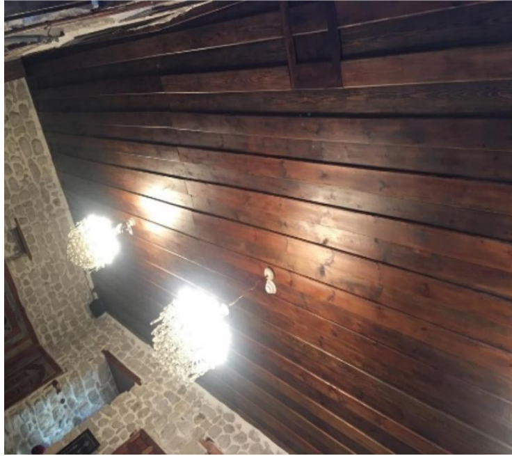
Şekil 69. A kodlu mekanda bulunan ahşap asma tavan
