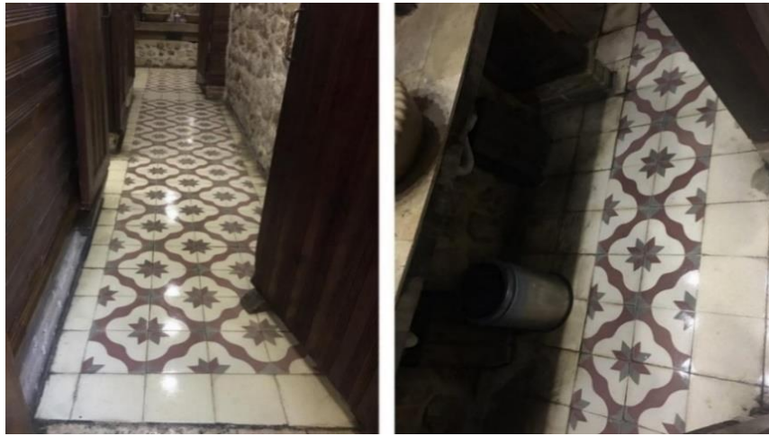
Şekil 83. Tuvalet mekanının fayans döşemesi
