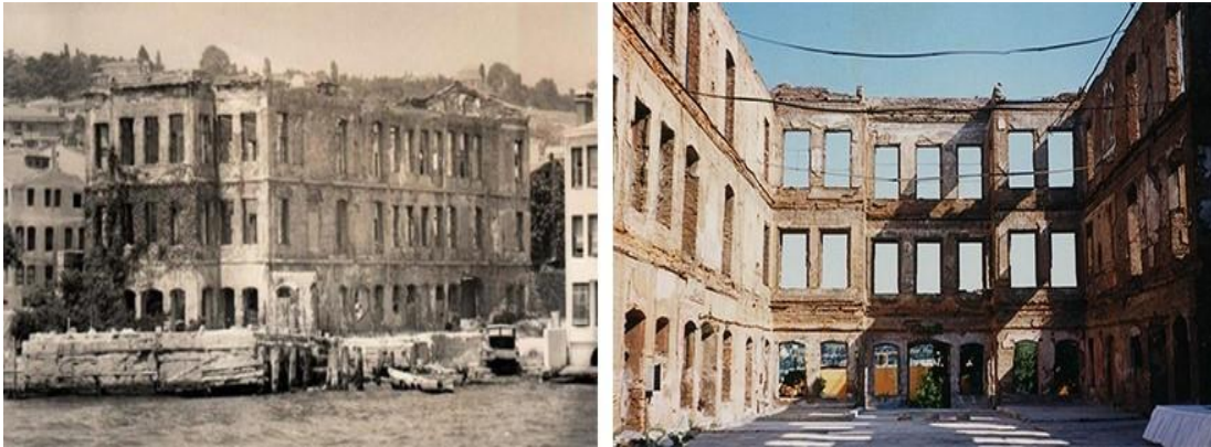
Şekil 2. Restorasyon öncesi Esmâ Sultan Yalısı
