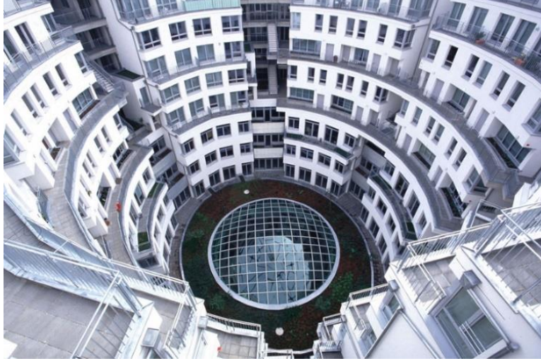
Şekil 10. Yeniden işlevlendirme sonrası Viyana Gazometrelerinden birinin görünüşü
