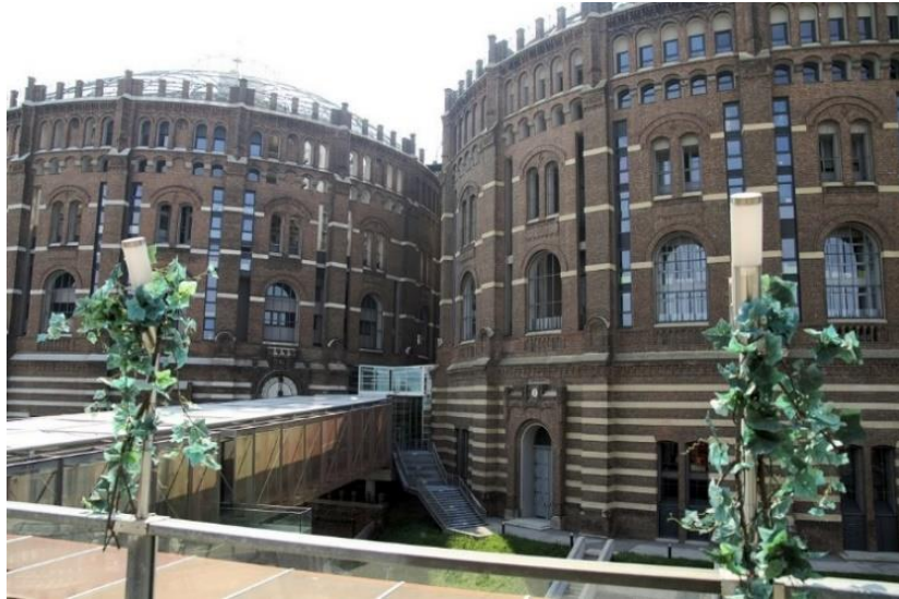
Şekil 9. Viyana Gazmometrelerinin yeniden işlevlendirme sonrası dış cephe görünüşü
