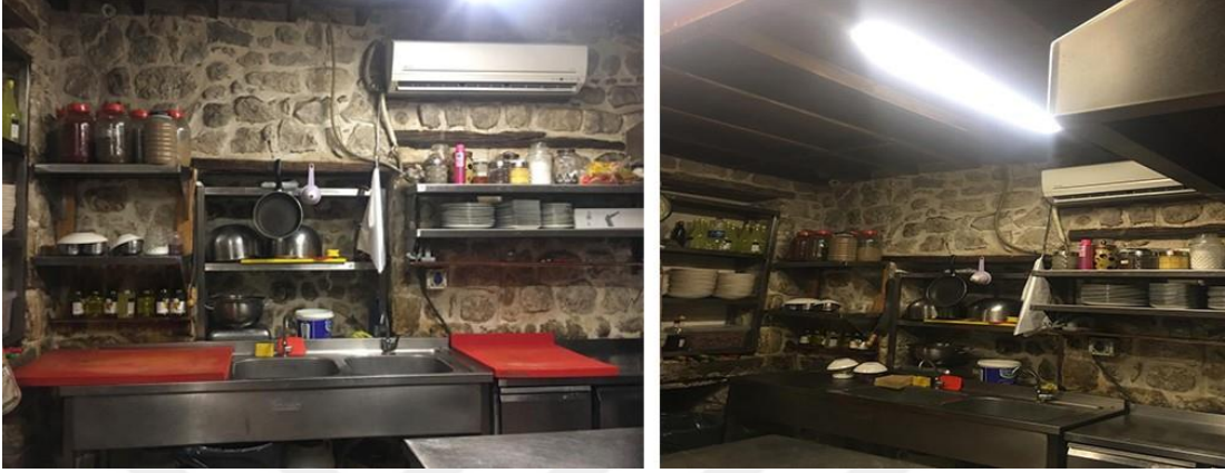
Şekil 90. Mutfak mekanı görünüşü
