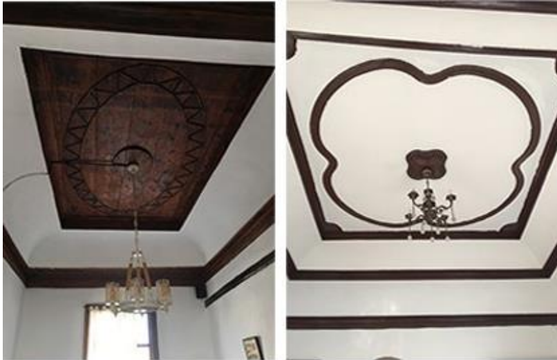
Şekil 31. Ahşap ve betonun kullanıldığı derin oyma tekniğiyle yapılmış tavan örnekleri
