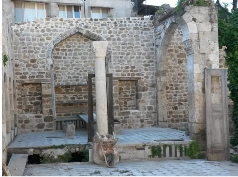
Şekil 78. Sekide yapılan restorasyon uygulamalarıyla ortaya çıkarılan mahmeller
