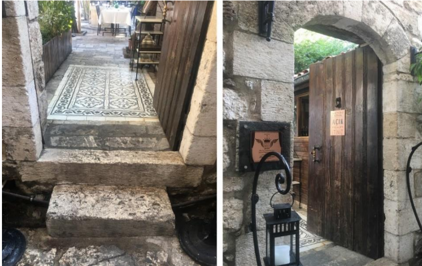
Şekil 62. Taşlıktan avluya giriş
