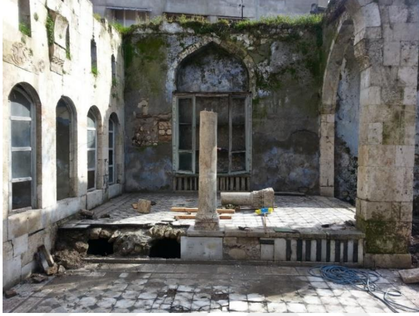
Şekil 81. Restorasyon öncesi seki görünüşü
