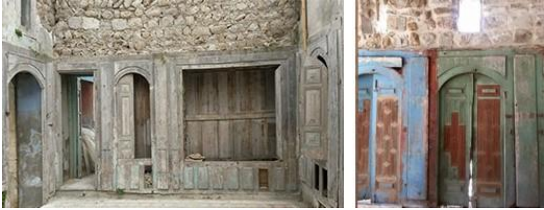
Şekil 71. Restorasyon öncesi mekânın görünüşü
