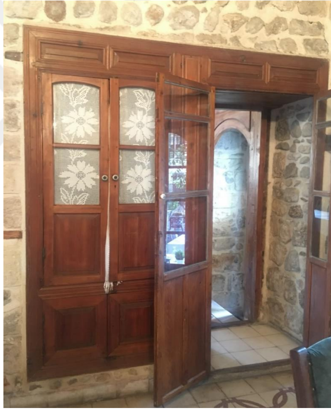
Şekil 67. A kodlu mekanın güneydoğu cephesindeki duvar
