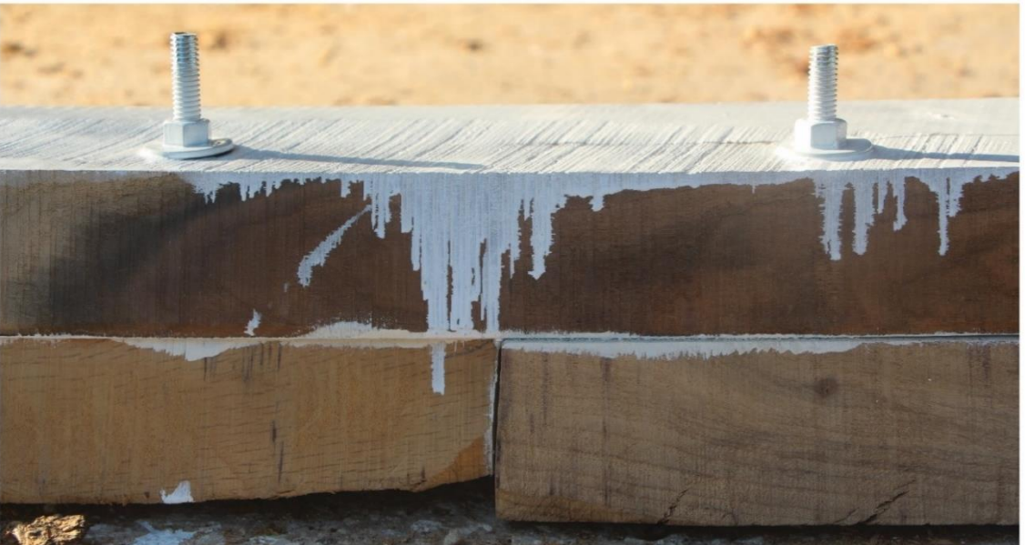
Fotoğraf 29: Posta birleşim detayı, alın altına öpüşme (kalafatsız) Yazarın arşivinden alınmıştır
