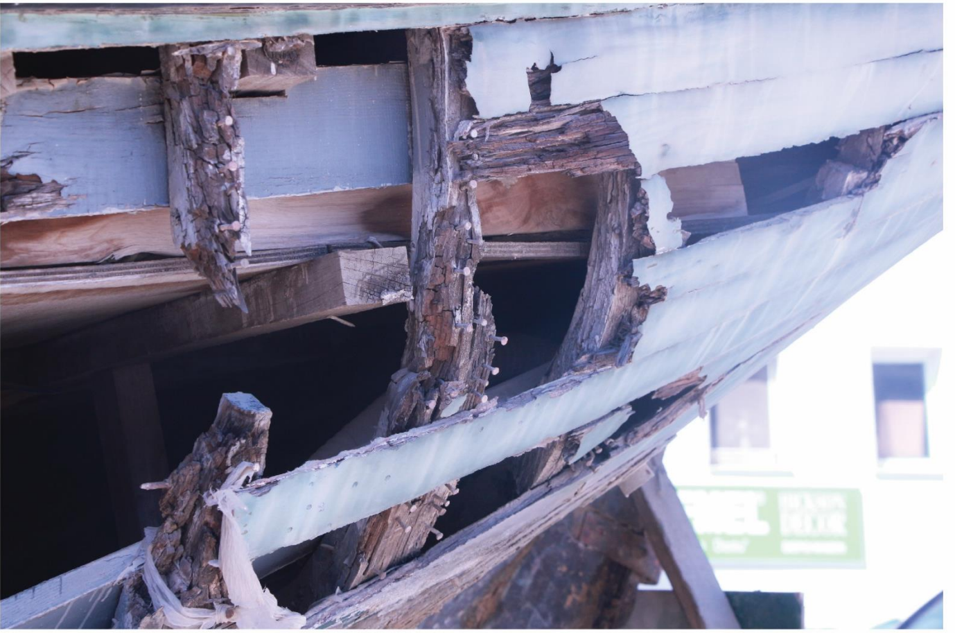
Fotoğraf 49: Konvansiyonel üretim örneđi, parçalanmış yan yüzey Yazarın arşivinden alınmıştır
