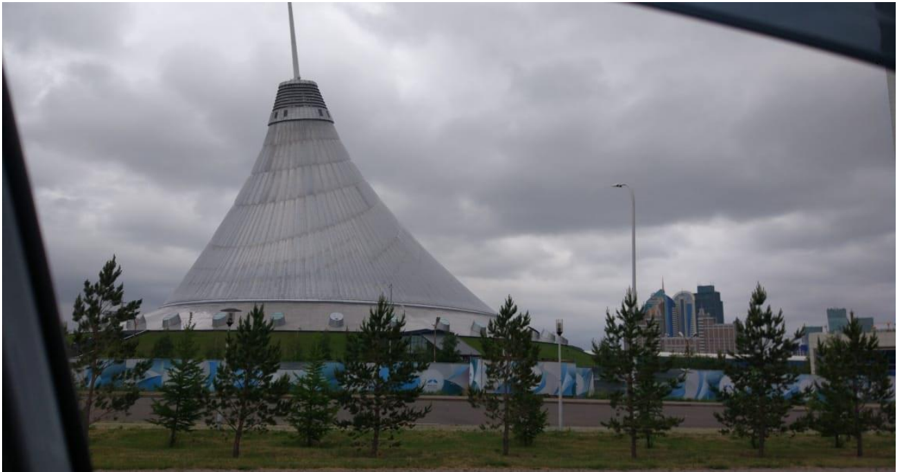
Fotoğraf 80: Han Çadırı, güneybatı cephesi Yazarın arşivinden alınmıştır
