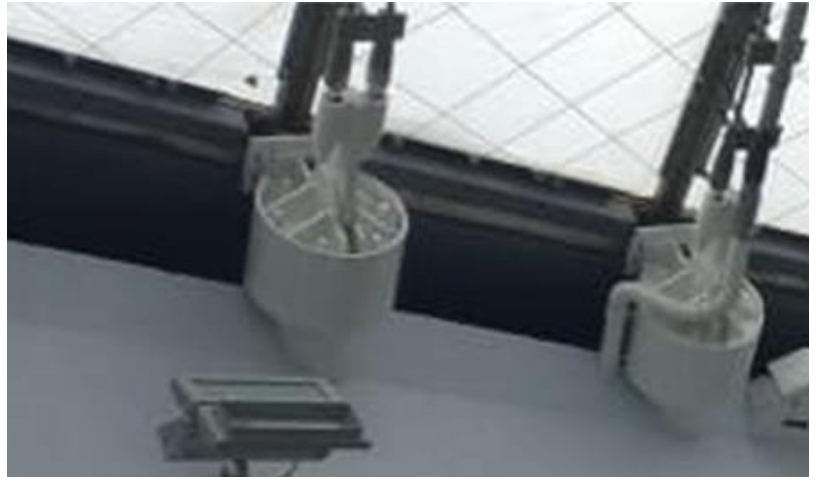
Fotoğraf 68: Çelik halat germe noktaları, detay görünüm Yazarın arşivinden alınmıştır
