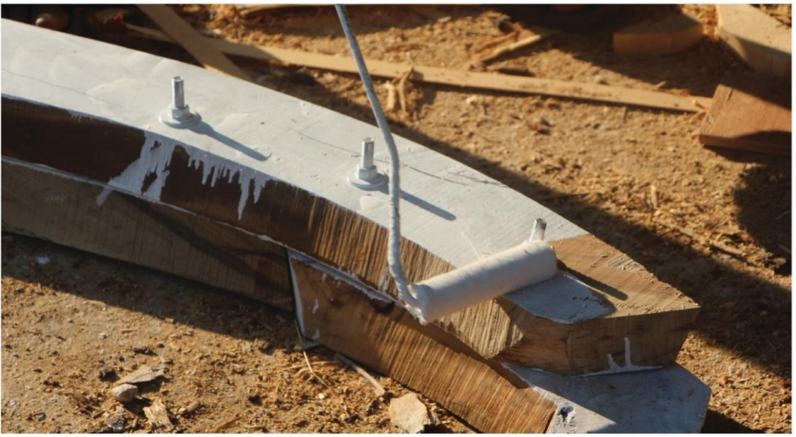
Fotoğraf 27: Posta Birleşim detayı, boyanma anı Yazarın arşivinden alınmıştır
