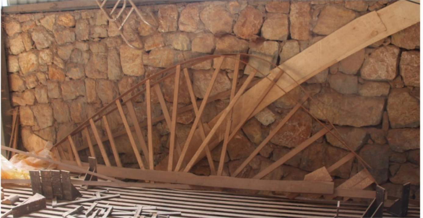
Fotoğraf 36: Yan yzey iin hazırlanmıř kalıplar Yazarın arřivinden alınmıřtır
