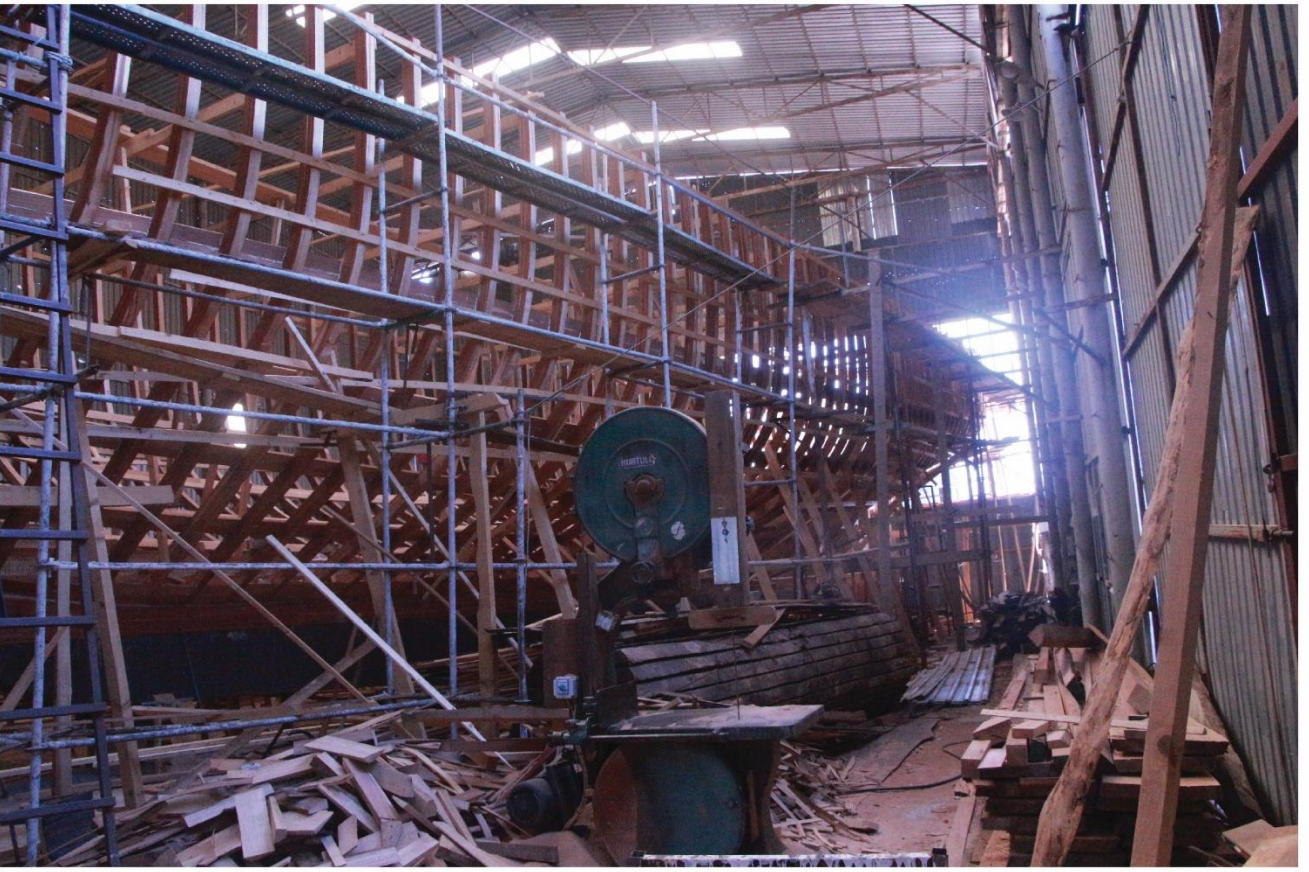
Fotoğraf 55: Atölyeden bir kesit, taşıyıcı (geçici) strüktür ve tekne omurgası Yazarın arşivinden alınmıştır
