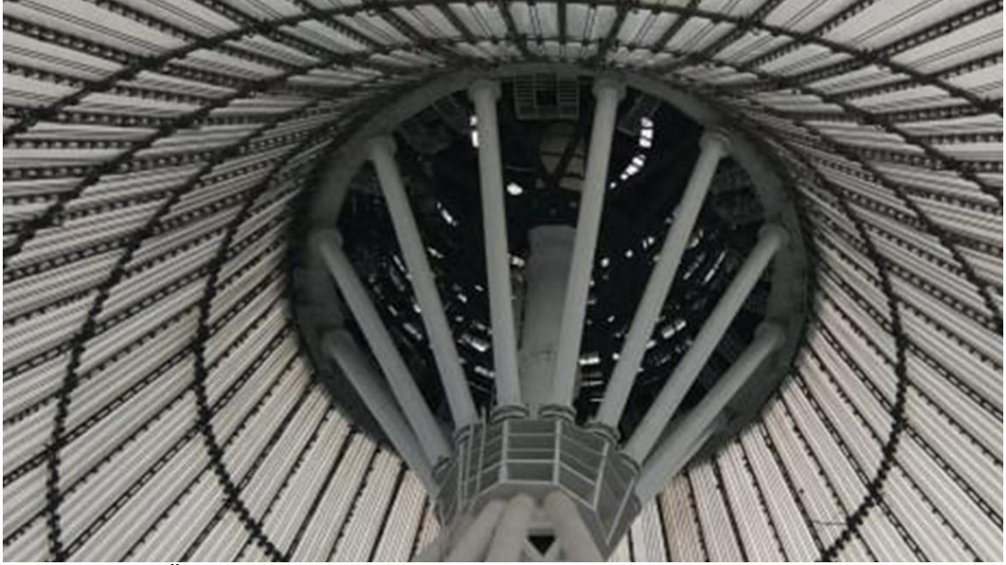
Fotoğraf 66: Üç ayaklı kule tepesi – dış cephe birleşimi Yazarın arşivinden alınmıştır
