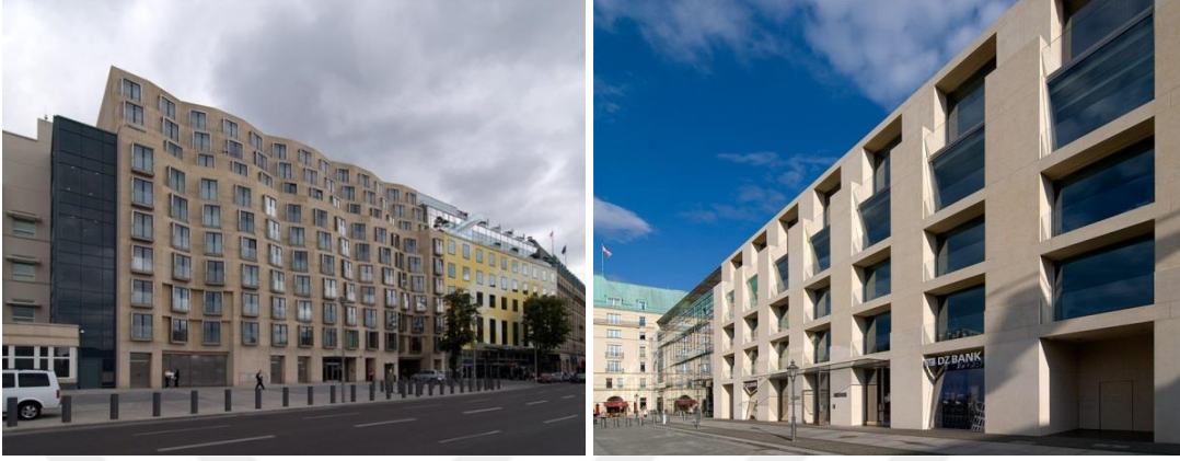
Şekil 33: Pariser Platz Cephesi (sağ) Behrenstrasse Cephesi (sol) (Url 25)
