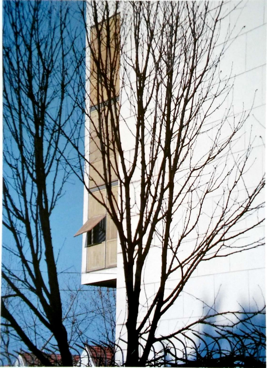
Fotoğraf 8. Anadolu Kulübü Otel Binası, Büyükkada İstanbul 1951-1957 (Tanyeli, Yücel, 2007: 67)
