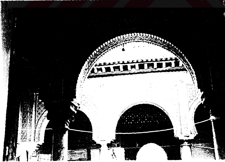
Resim = 315. Revakların kemer alınlıklarındaki alçı kaplamalar.
