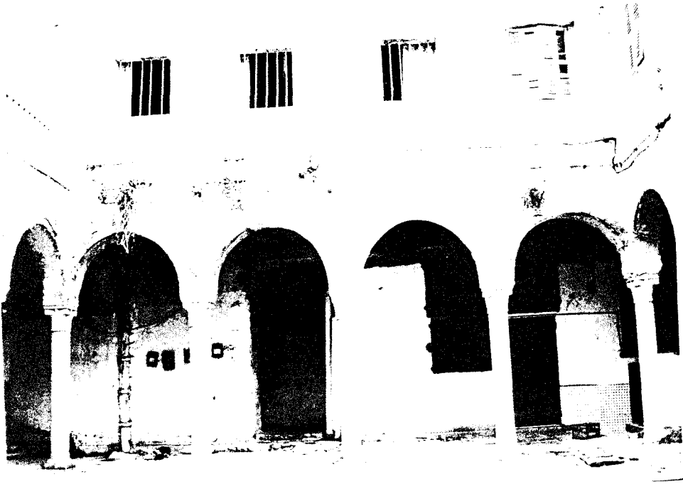
Resim = 430. Avlu revakı
