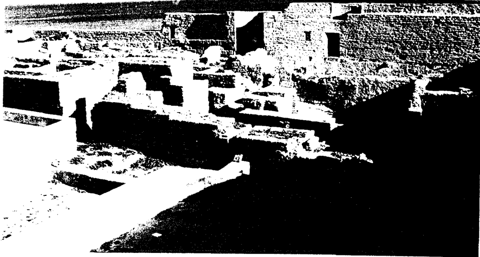
Resim = 351. Burcun içindeki yıkık duvarlar
