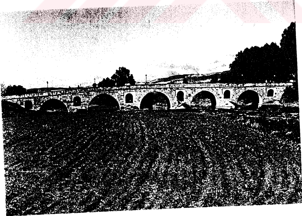
Resim = 431. Mecez'El-Bâb Köprüsü
