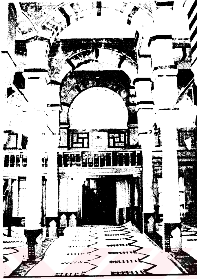
Resim = 110. Harimden sütun ve kemerlerle oluşturulan örtü sistemi.
