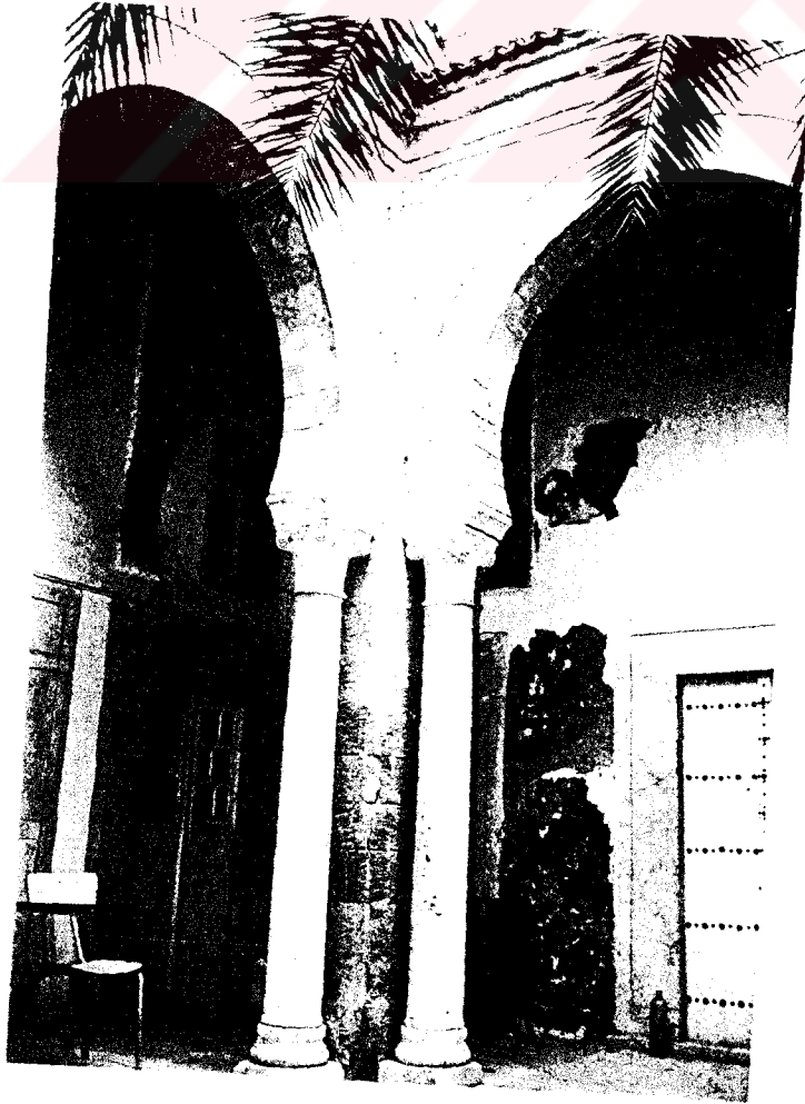
Resim = 209. Revakların köşelerindeki paye ve sütunlar
