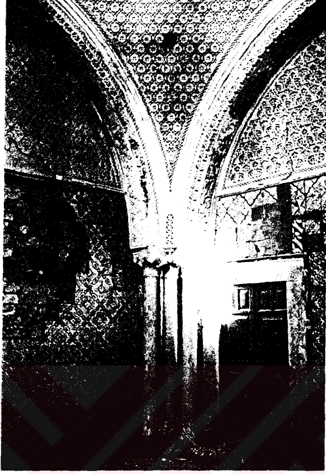
Resim = 288. Tevhidhanenin kubbesini taşıyan sütun ve kemerler
