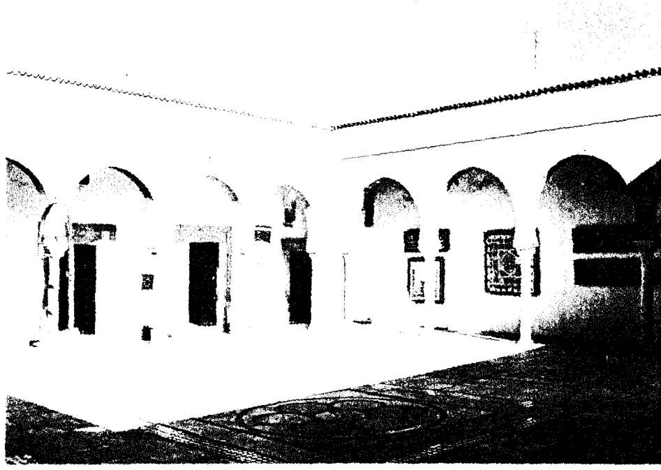
Resim = 486. Avlu revakı
