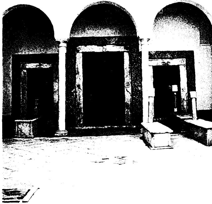
Resim = 337. Avlu revakı
