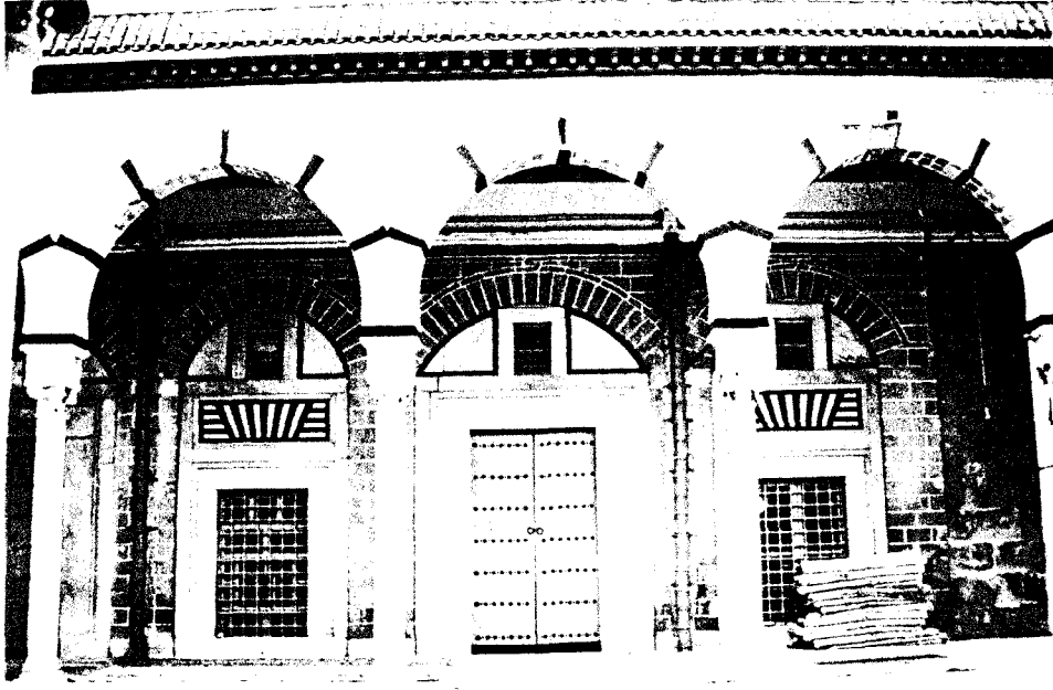
Resim = 108. Harimin dış cephelerindeki mermer kaplama.
