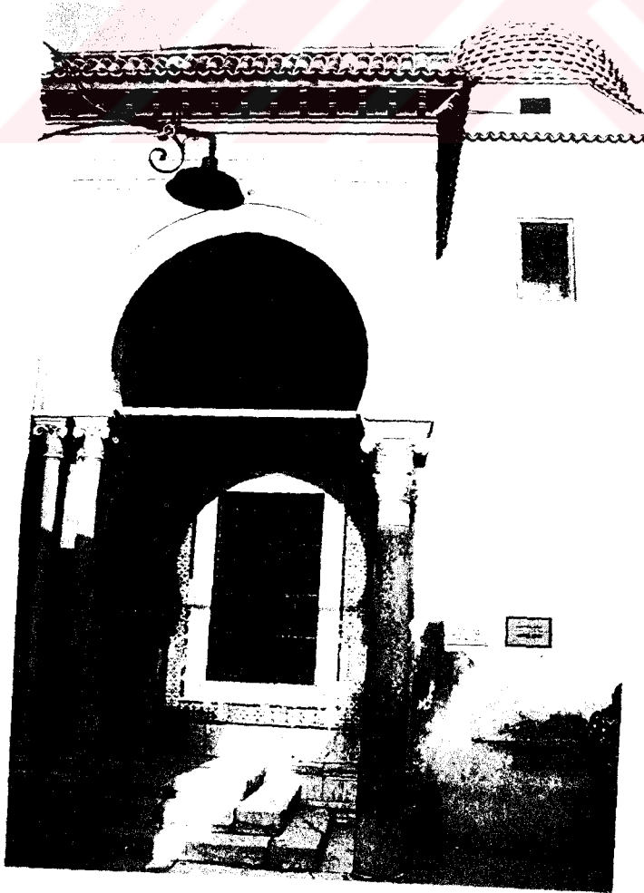
Resim = 223. Kapının önündeki revak ve mihrab önü kubbesinin dıştan görünüşü
