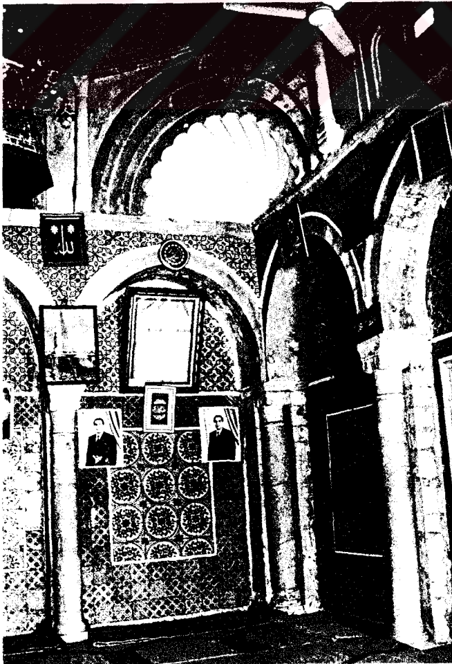
Resim = 267. Duvarları kaplayan çiniler ve kubbe geçişi
