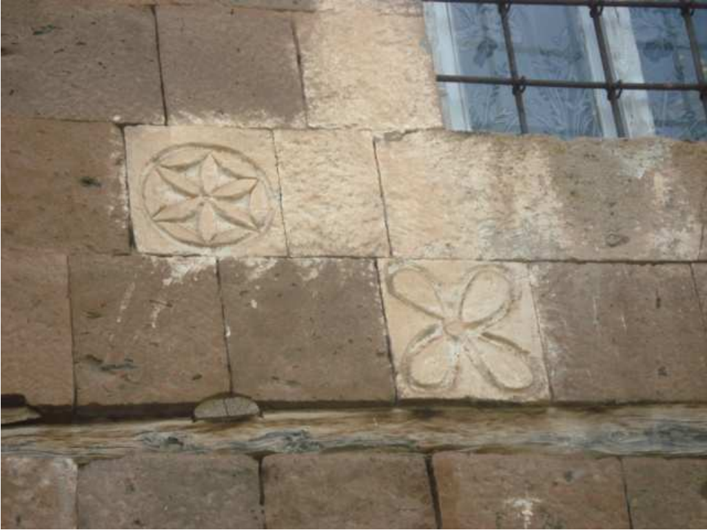
Resim 10. Dış Cephe Süslemesi
