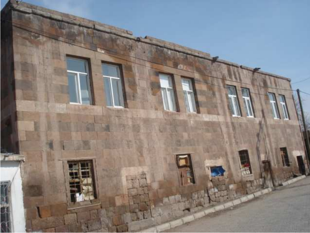
Resim 32. Evin Güneyden Görünüşü
