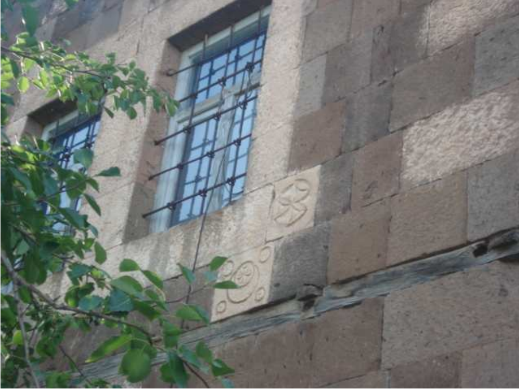
Resim 15. Dış Cephe Süslemesi
