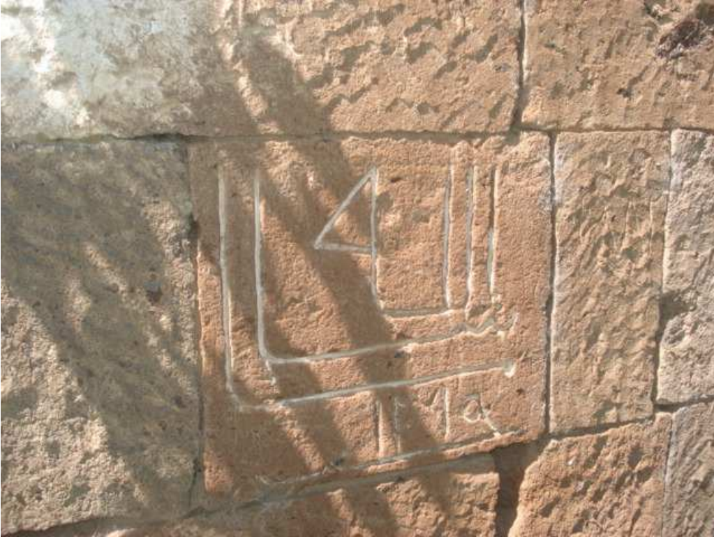
Resim 12. Dış Cephe Süslemesi
