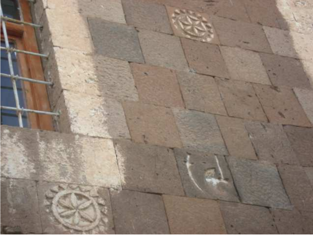
Resim 11. Dış Cephe Süslemesi
