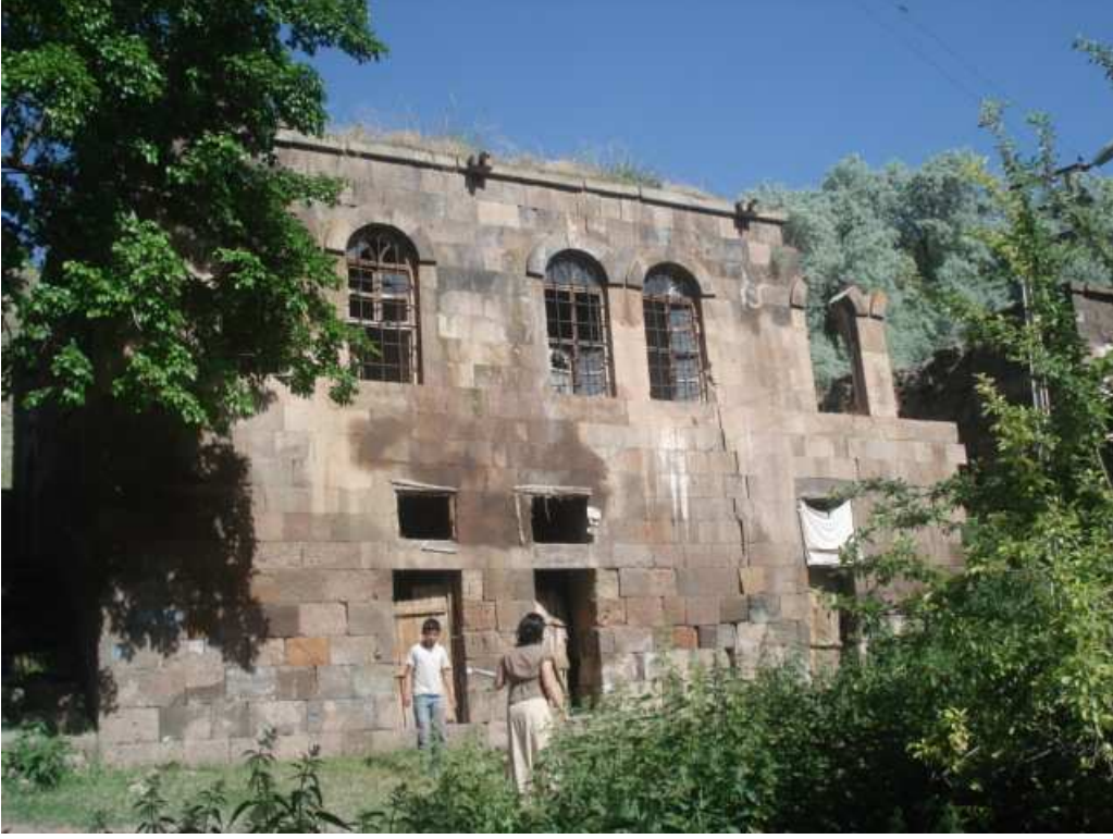
Resim 35. Evin Güneyden Görünüşü
