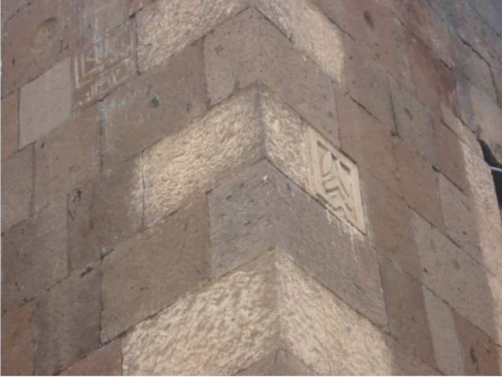
Resim 16. Dış Cephe Süslemesi
