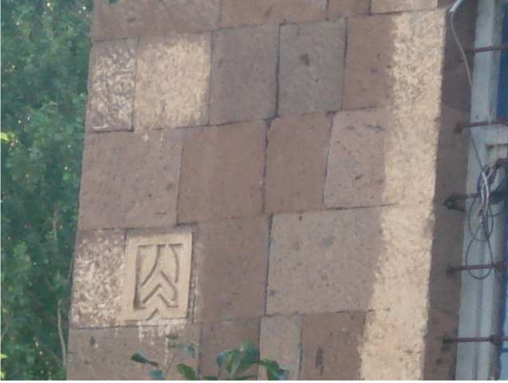
Resim 13. Dış Cephe Süslemesi
