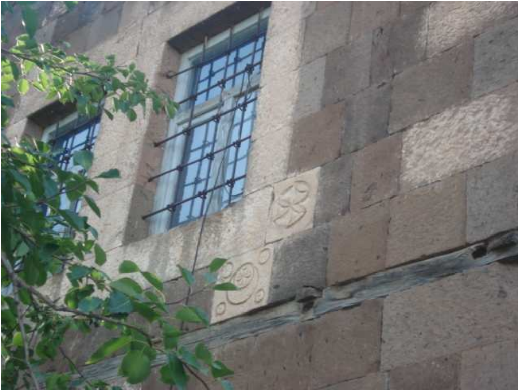
Resim 14. Dış Cephe Süslemesi
