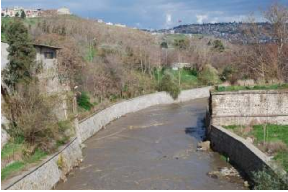
Resim 197. İzmir Kervan Köprüsü'nün Günümüzdeki Durumu
