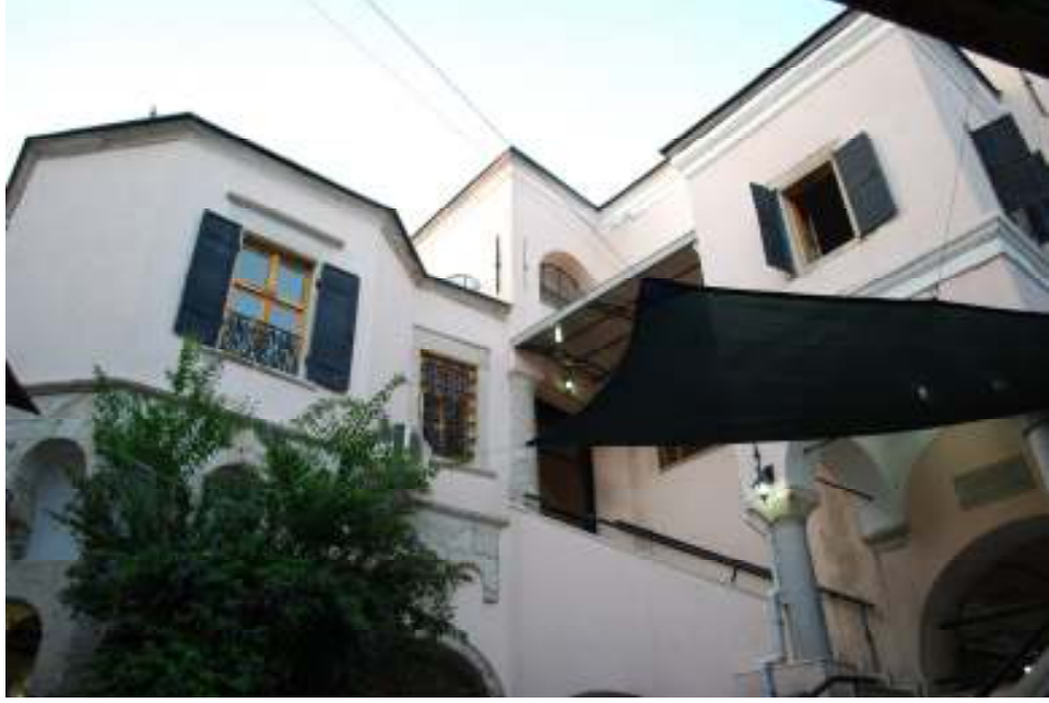
Resim 175. İzmir Şadırvan Camii, Giriş Cephesi
