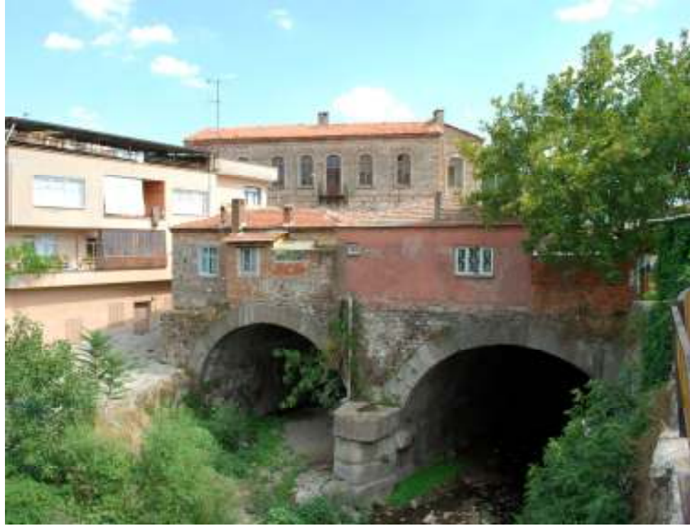
Resim 200. Bodrumüstü Musluk Köprüsü'nün Yanında Yer Alan Tünel
