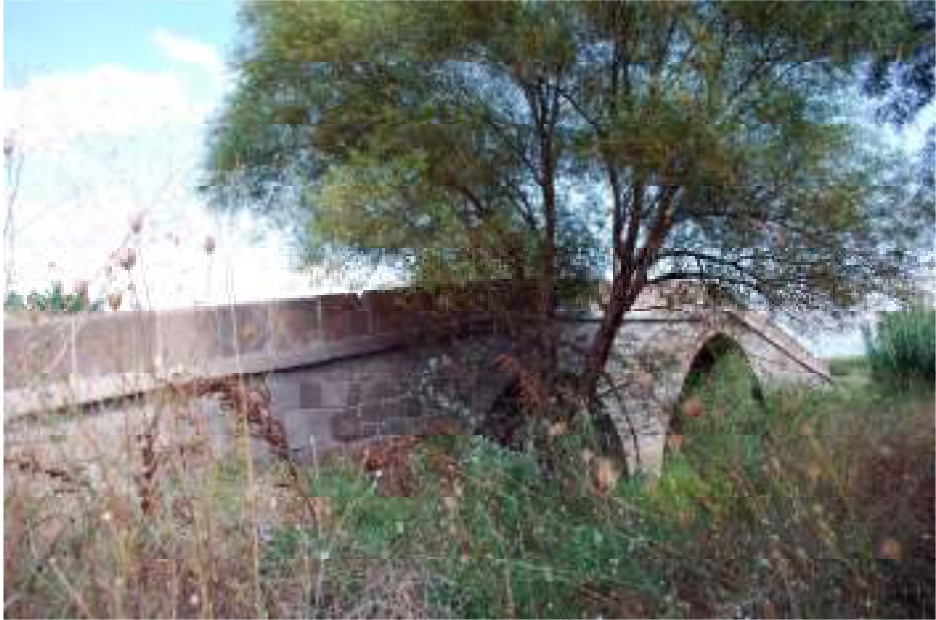
Resim 198. İzmir, Bergama, Koyun Köprüsü
