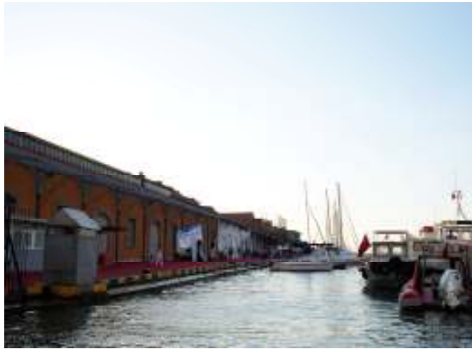
Resim 226. Konak Pier, Gümrük Depoları
