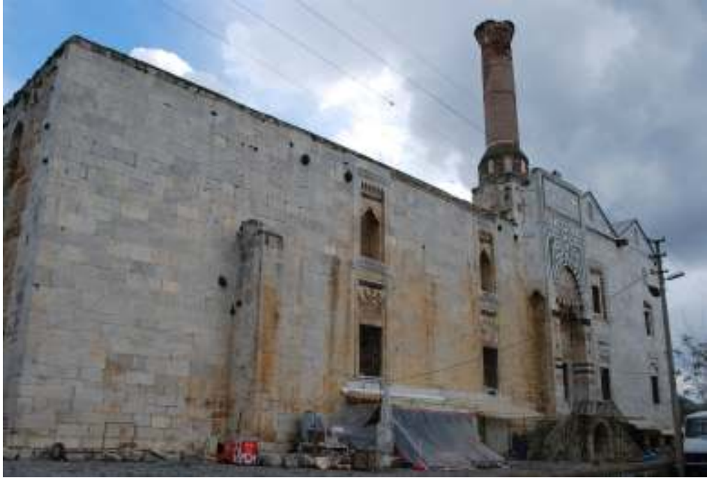
Resim 178. Selçuk İsa Bey Camii, Batı Cephesi
