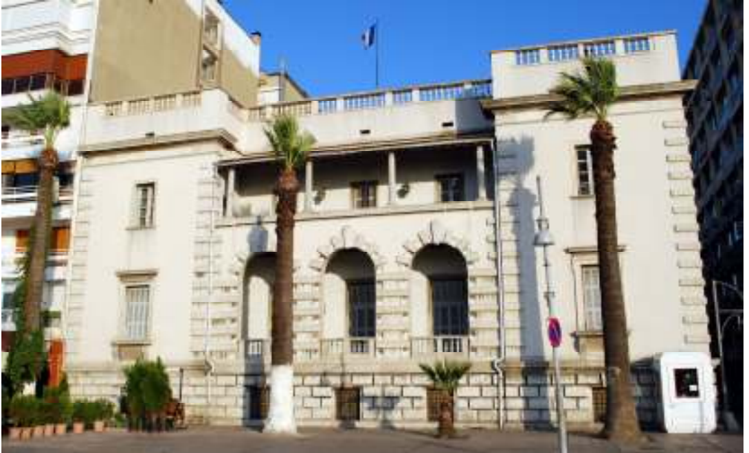
Resim 206. İzmir’de Günümüzde Kullanılan Fransız Konsolosluğu Binası
