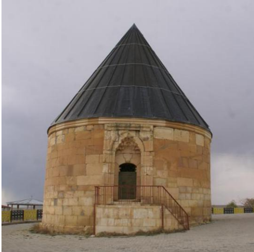
Fotoğraf No: 2 Şehit Osman I No'lu Türbesi
