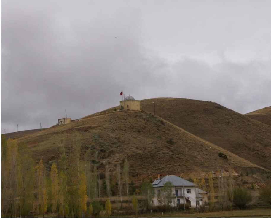
Fotoğraf No: 34 Akşar Köyü Oslu Baba Türbesi Uzaktan Genel Görünüm
