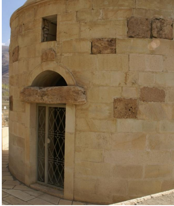
Fotoğraf No: 15 Yıldırım Ali Baba Türbesi Giriş Kapısı Ve Onarımda Kullanılan Orijinal Taşlar
