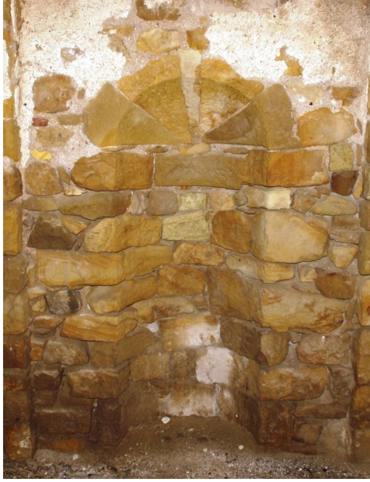
Fotoğraf No: 20 ayır Yolu Kutlu Bey Trbesi Mihrap Grnm
