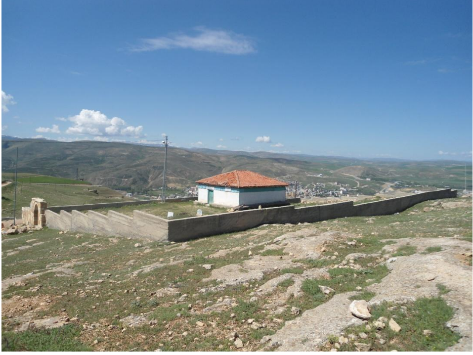
Fotoğraf No: 42 Erenli Köyü Abdülvehhab Gazi Türbesi Dıştan Genel Görünüm
