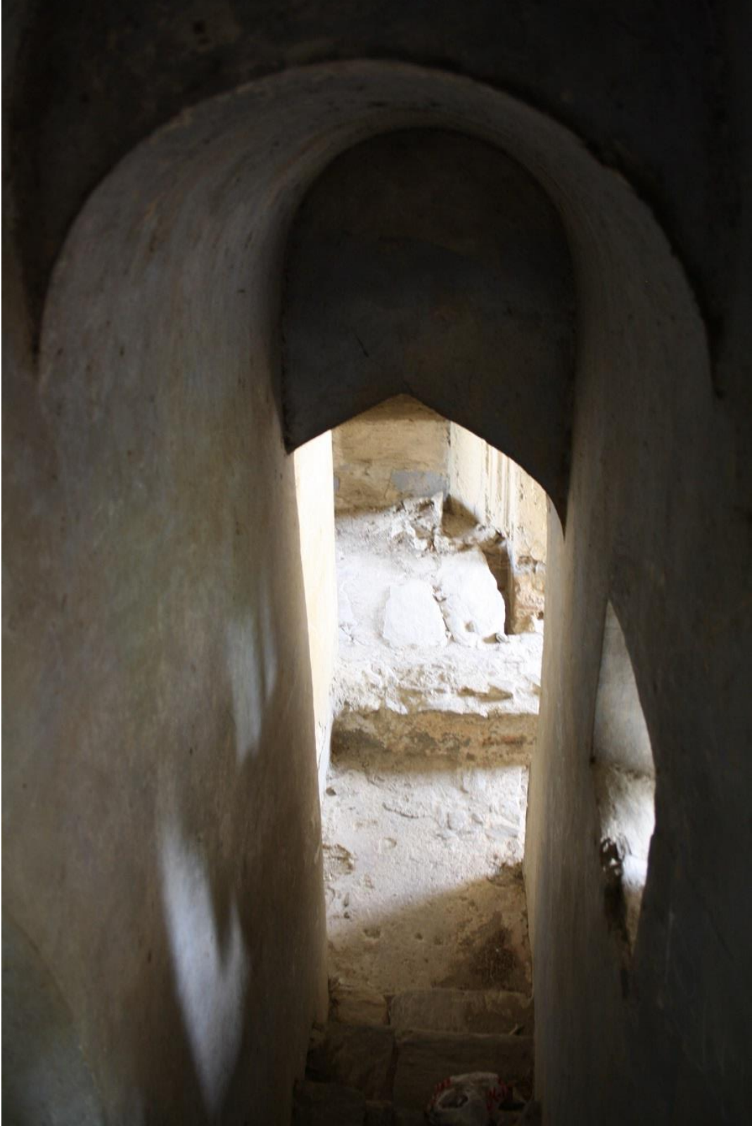
Fotoğraf-197: Koçarlı İbrahim Ağa Kulesi merdiven tonozları
