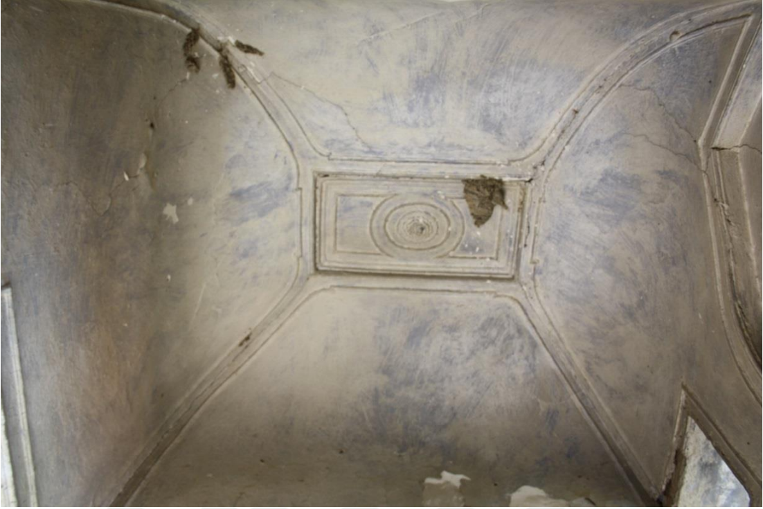
Fotoğraf-194: Zemin kat giriş alanı çapraz tonoz örtüsü
