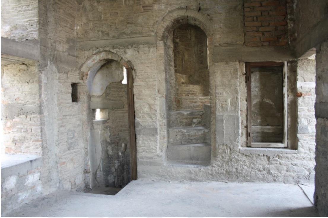
Fotoğraf-216: Koçarlı İbrahim Ağa Kulesi batı duvarı (alt ve üst kata çıkış kapı ve merdivenleri)
