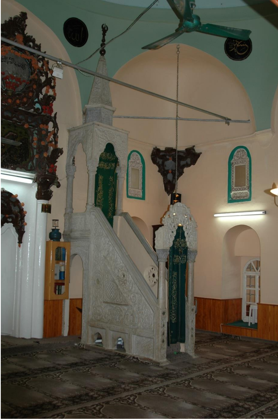
Fotoğraf-109: Koçarlı Mustafa Ağa Cami onarım öncesi harim duvarları (Ufuk Altıntaş'tan)
