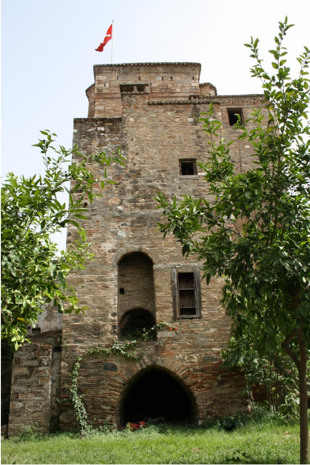
Fotoğraf- 193: Koçarlı İbrahim Ağa Kulesinin kuzey cephesi
