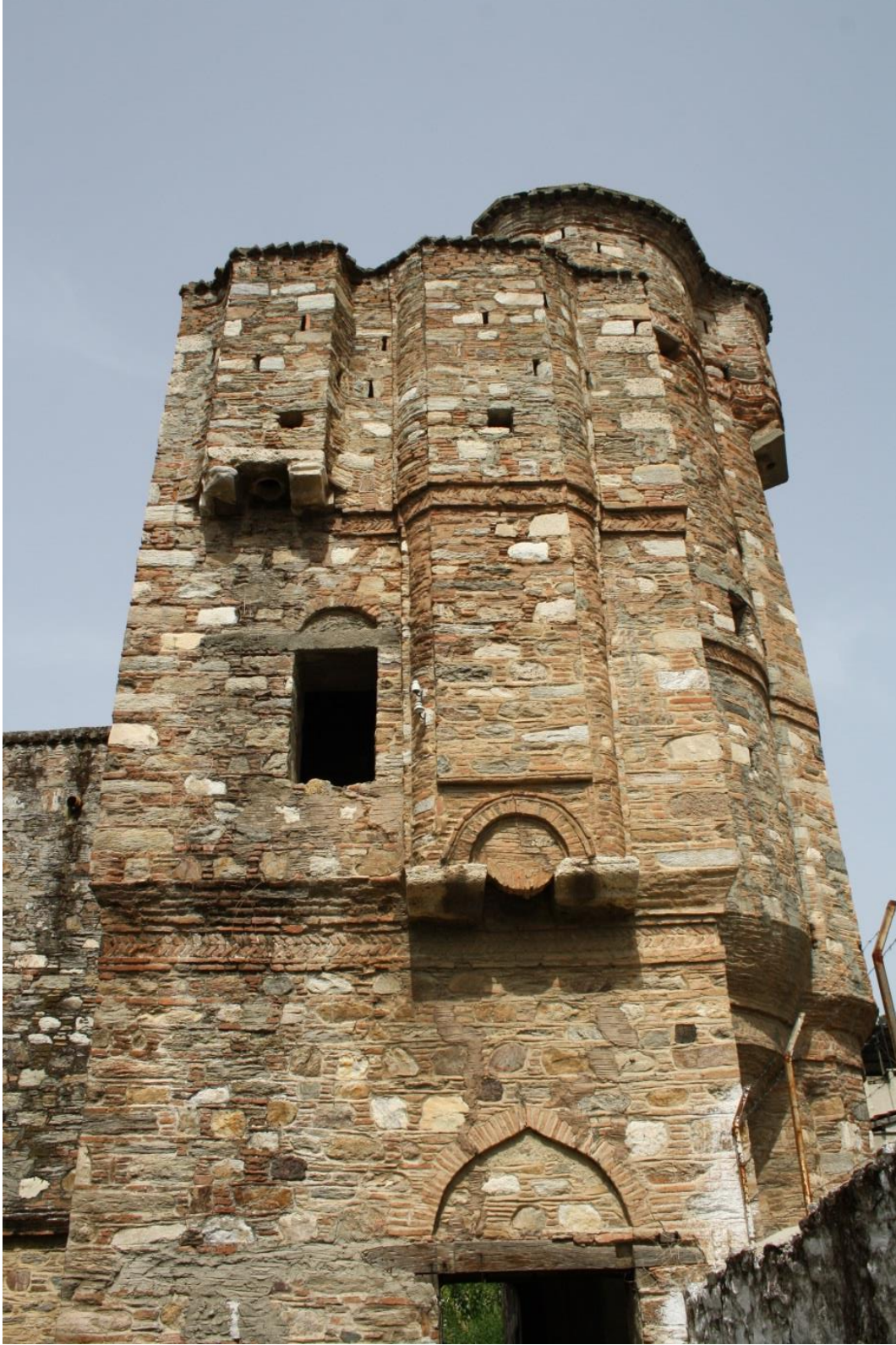
Fotoğraf-202: Koçarlı İbrahim Ağa Kulesinin batı cephesi ve 2. Ve 3. katta bulunan senkendaz
