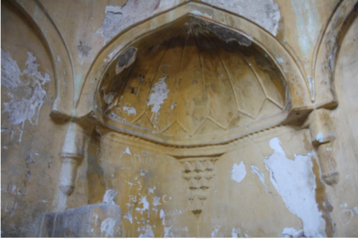
Fotoğraf-229: Cemal Bey Hamamı sıcaklık kısmı tromplar ve süsleme detayları
