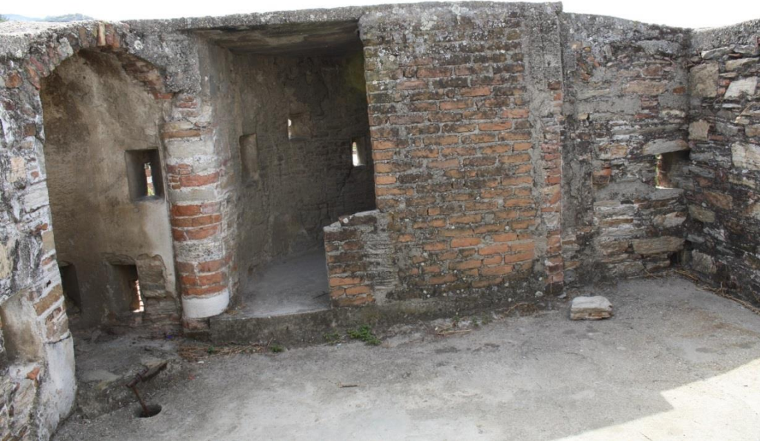
Fotoğraf-201: Koçarlı İbrahim Ağa Kulesi 4. kat batı duvarı ve giriş kapısı
