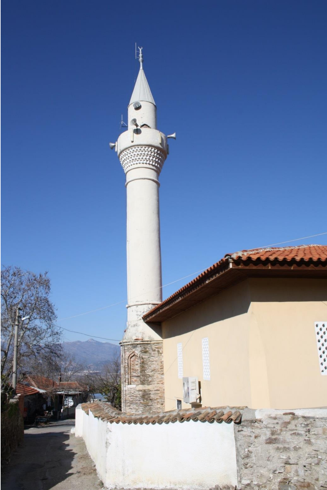
Fotoğraf-98: Karahayit Zeynep Kadın Cami minaresi ve batı cephe görünüşü
