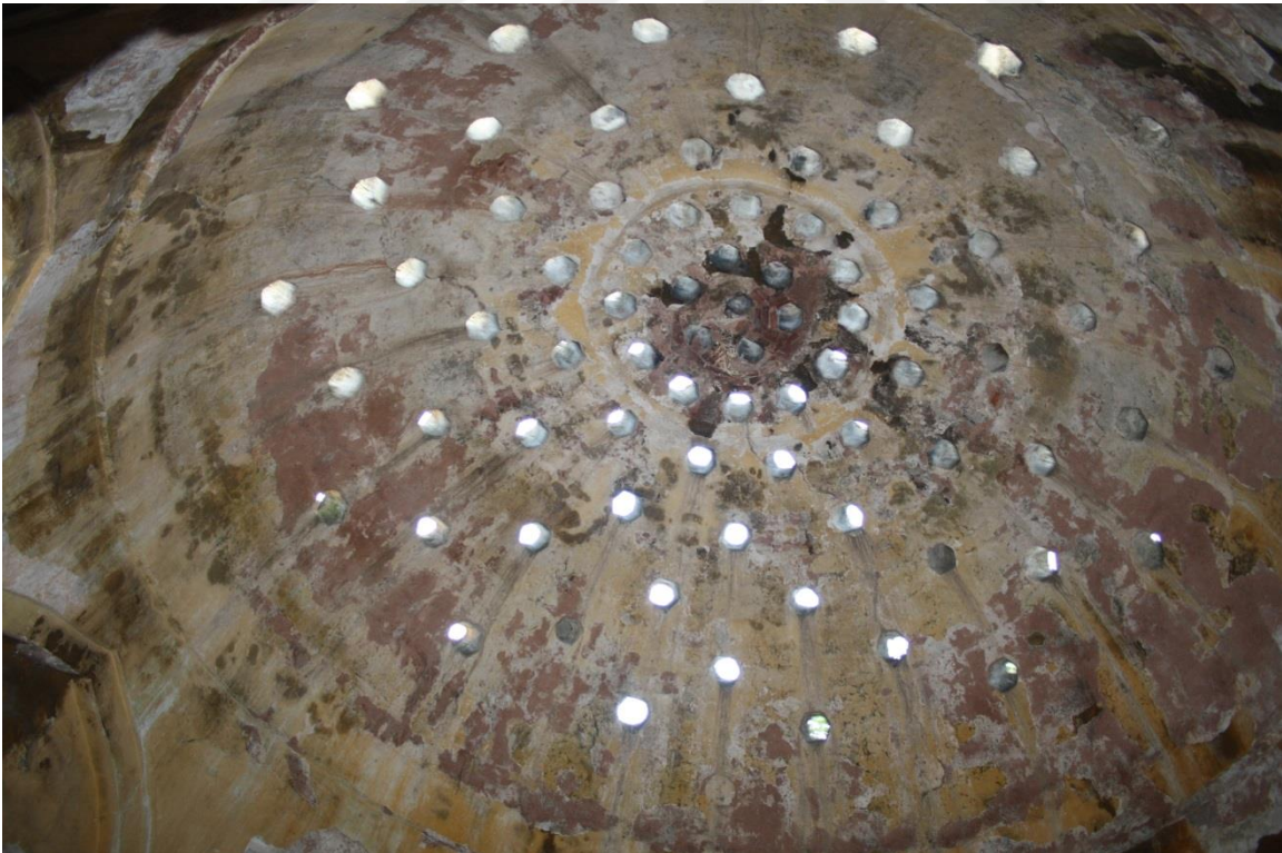
Fotoğraf-230: Cemal Bey Hamamı sıcaklık kısmı kubbe örtüsü
