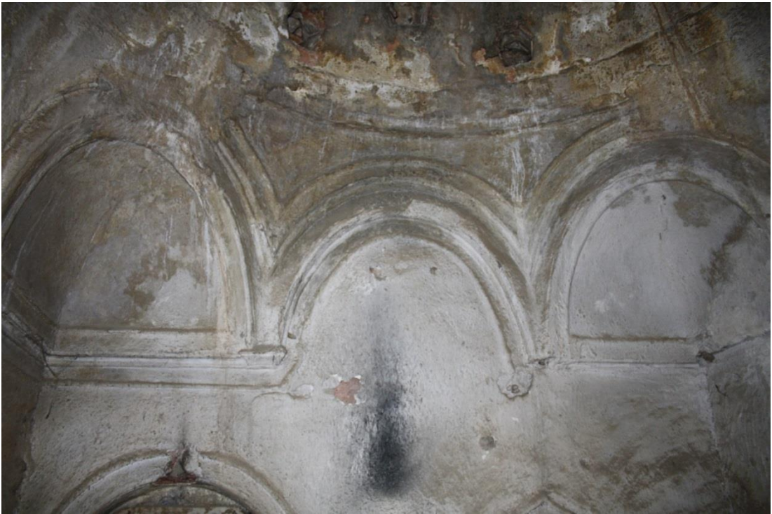
Fotoğraf-199: Koçarlı İbrahim Ağa Kulesi hamamı kubbe geçişleri
