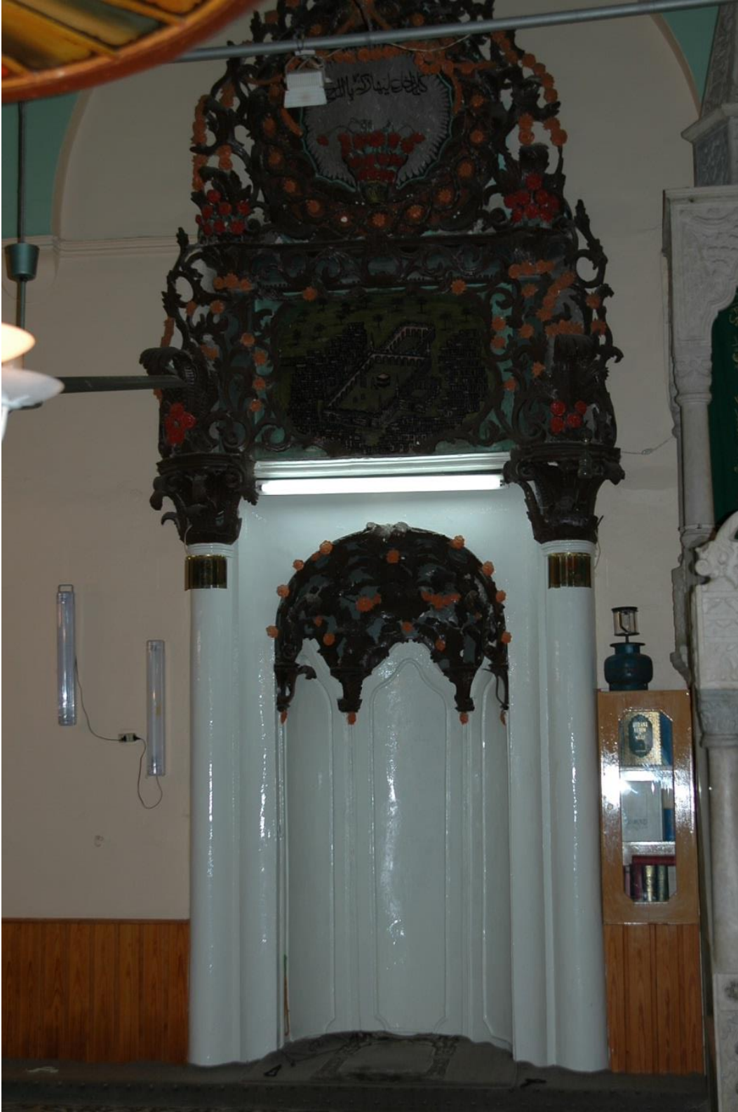
Fotoğraf-108: Koçarlı Mustafa Ağa Camii onarım öncesi mihrabın görünümü (Ufuk Altıntaş'tan)
