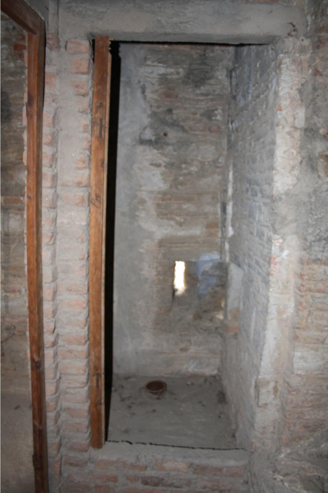
Fotoğraf-206: Koçarlı İbrahim Ağa Kulesinin 2. kat'a eklenen tuvalet
