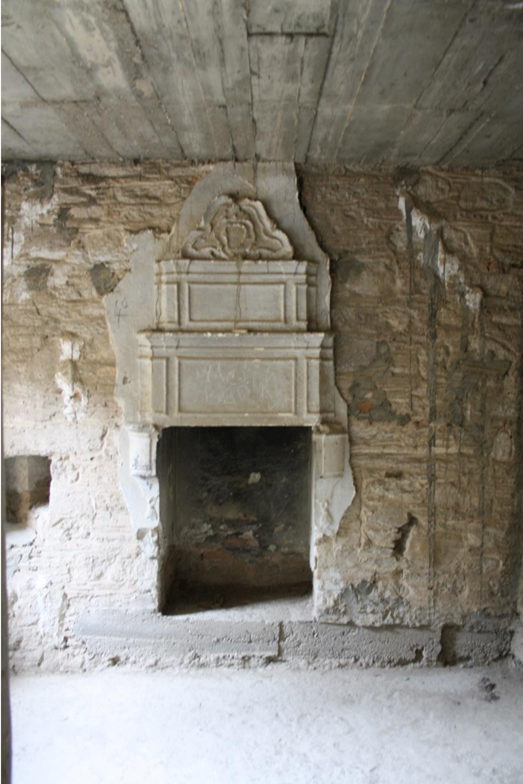
Fotoğraf-205: Koçarlı İbrahim Ağa Kulesi kışlık odası ocak nişi ve beton tavanı
