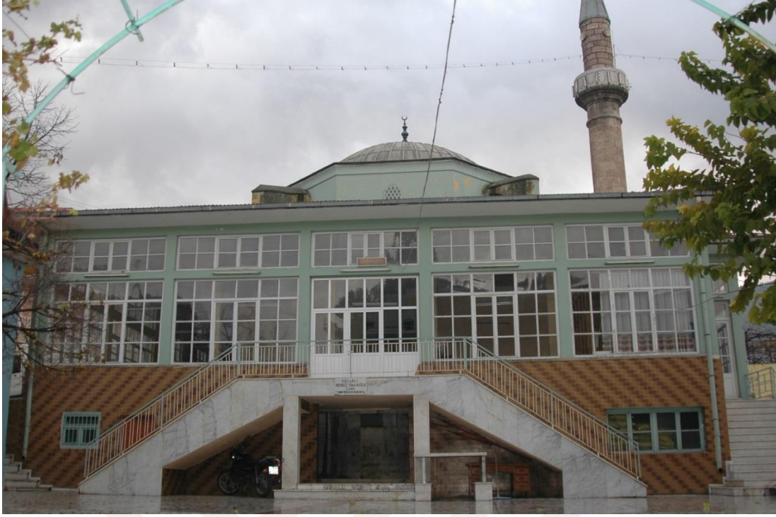
Fotoğraf-105: Koçarlı Mustafa Ağa Cami onarım öncesi görünümü (Ufuk Altıntaş'tan)
