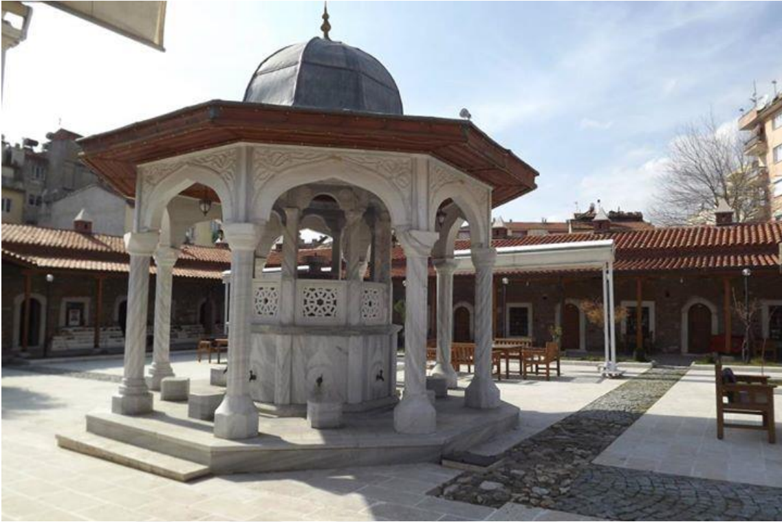
Fotoğraf-247: Aydın Nasuh Paşa Cami Şadırvanı ( httpswww.facebook.com/nasuhpasakulliyesi 'den)
