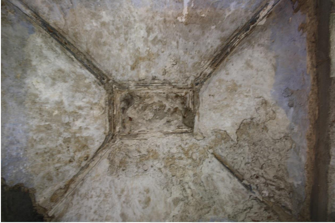
Fotoğraf-214: Koçarlı İbrahim Ağa Kulesi 3. kat kışlık oda çapraz tonoz örtü görünümü
