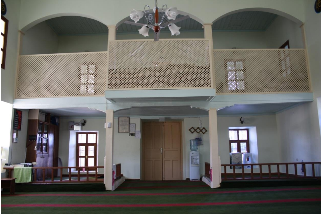
Fotoğraf-100: Karahayit Zeynep Kadın kuzey duvarı görünüşü
