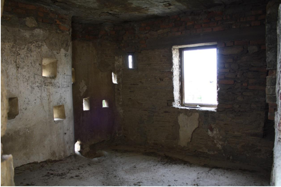
Fotoğraf-218: Koçarlı İbrahim Ağa Kulesi 3. kat kuzey duvarı
