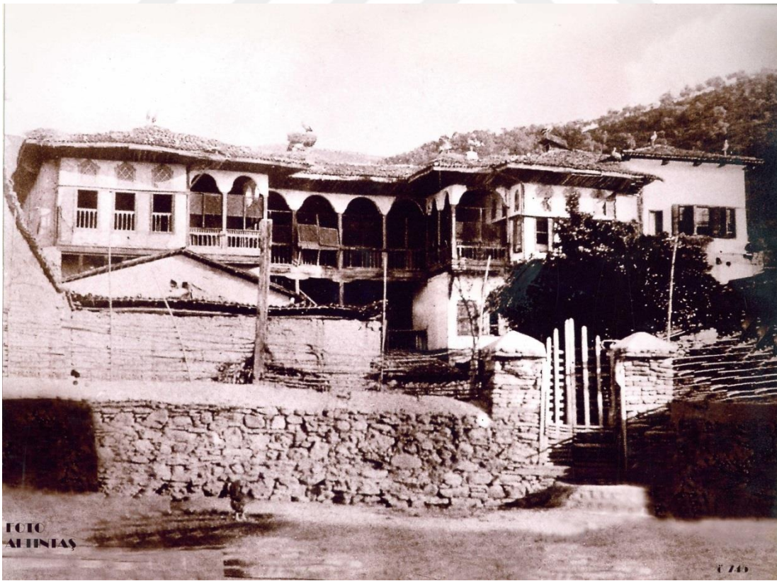
Fotoğraf-236: Koçarlı İbrahim Ağa Konağı (Koçarlı Belediyesi'nden)
