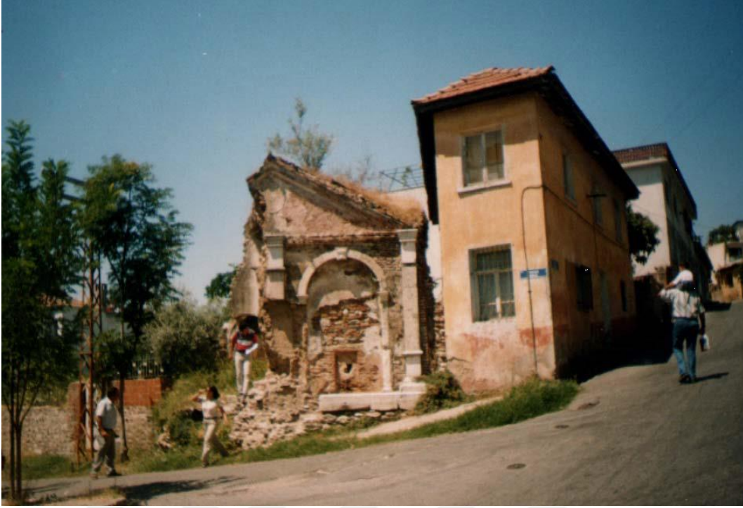
Fotoğraf-163: Ümmügülsüm (Ümmühan) Hanım Çeşme ve Sebil restorasyon öncesi (M. YILMAZ'dan)
