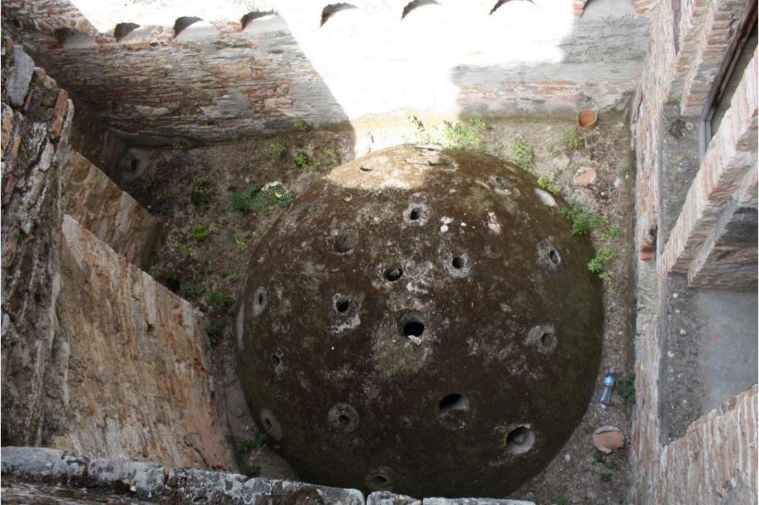
Fotoğraf-195: Koçarlı İbrahim Ağa Kulesi hamam kubbesi
