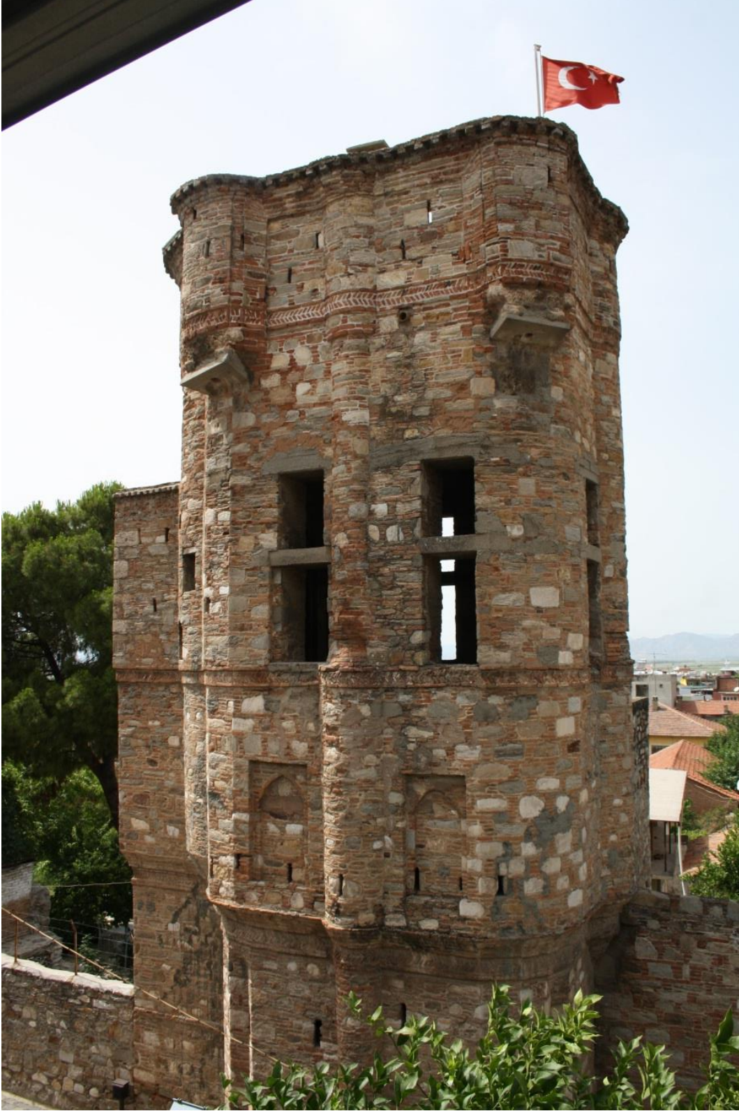
Fotoğraf- 201: Koçarlı İbrahim Ağa Kulesi güney cephesi
