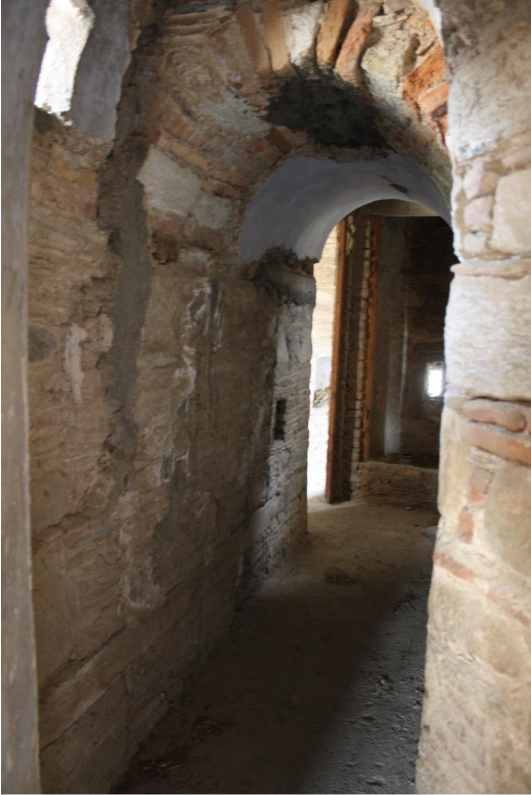
Fotoğraf-204: Koçarlı İbrahim Ağa Kulesi 2. kat dehlizli kolidor
