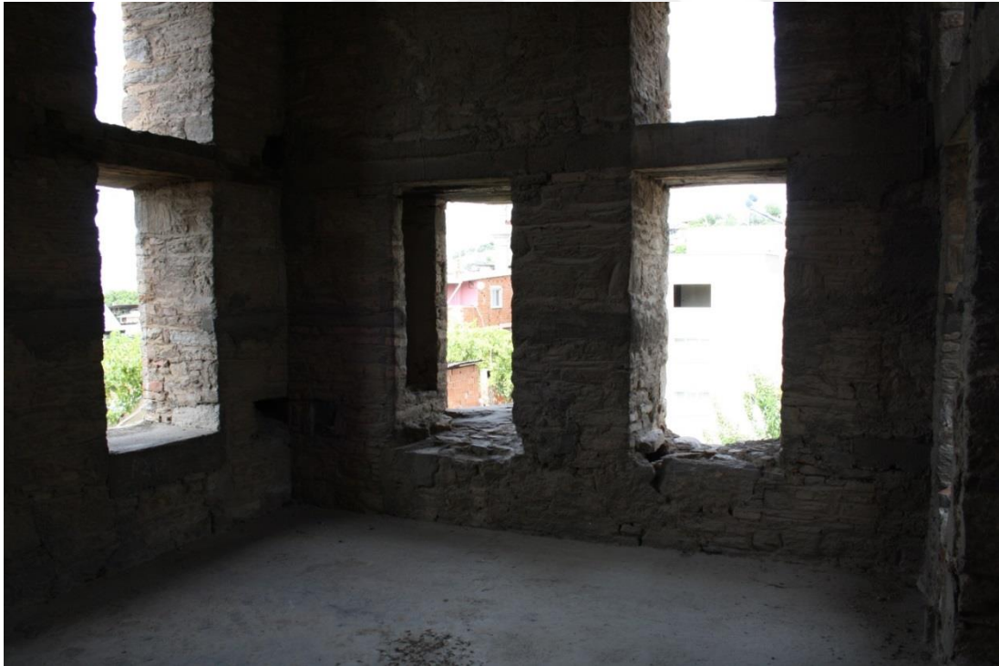
Fotoğraf-215: Koçarlı İbrahim Ağa Kulesi güney ve doğu duvarı
