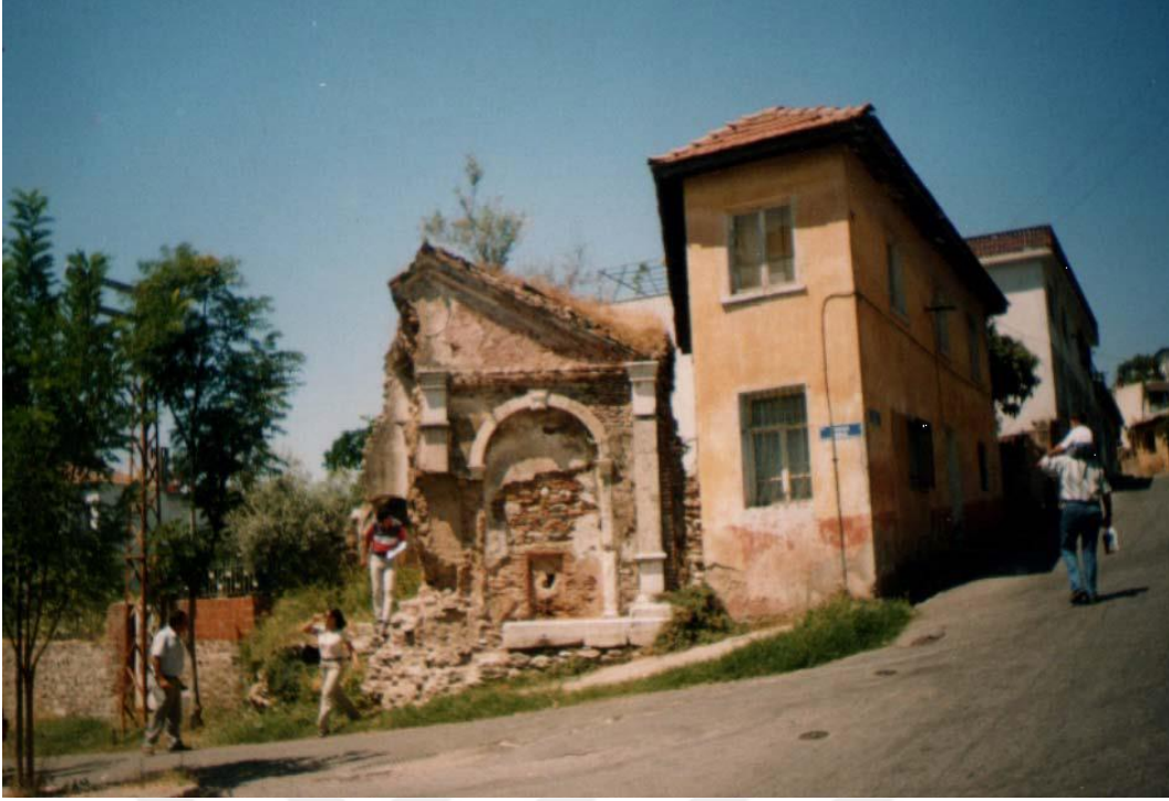
Fotoğraf-154: Ümmügülsüm (Ümmühan) Hanım Çeşme ve Sebil restorasyon öncesi (M. YILMAZ'dan)
