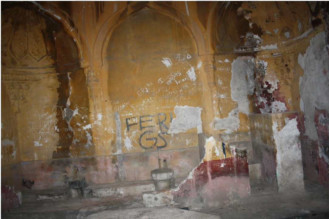
Fotoğraf-226: Cemal Bey Hamamı sıcaklık kısmı batı duvarı
