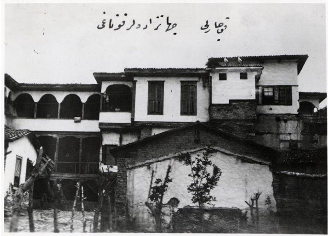
Fotoğraf-235: Koçarlı İbrahim Ağa Konağı özgün yapı 1930'lı yıllar (Sedat ZENGİN'den)
