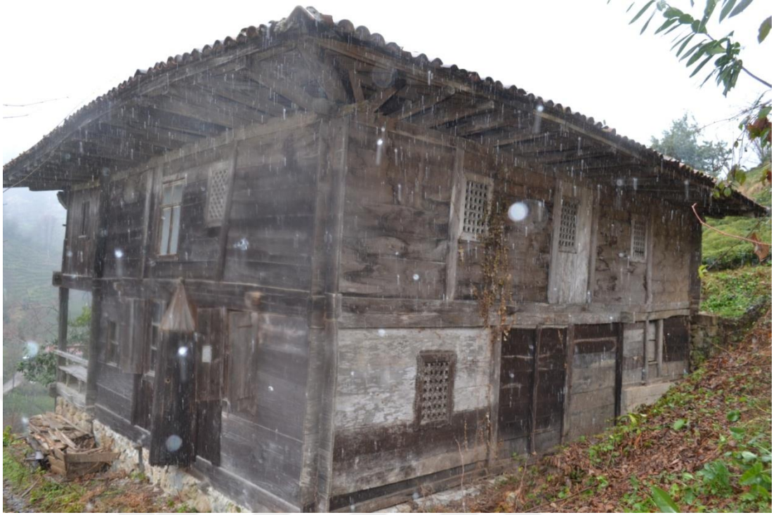
Fotoğraf 179: Dereyurt Köyü Merkez Eski Camii Güneydoğudan Genel Görünümü
