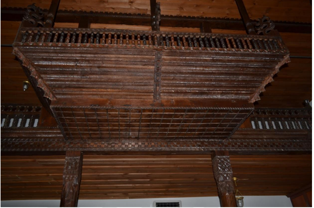
Fotoğraf 105: Taşçılar Köyü Merkez Camii Müezzin Köşkü
