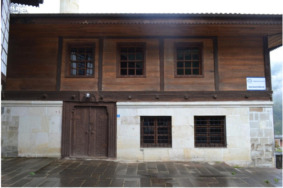
Fotoğraf 97: Taşçılar Köyü Merkez Camii Batı Cepheden Genel Bir Bakış
