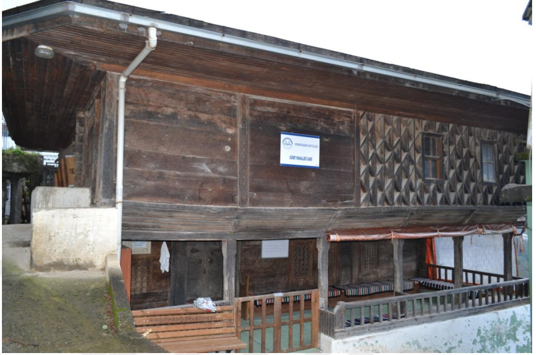
Fotoğraf 119: Güneykundu Mahallesi Camii Giriş Cephesi
