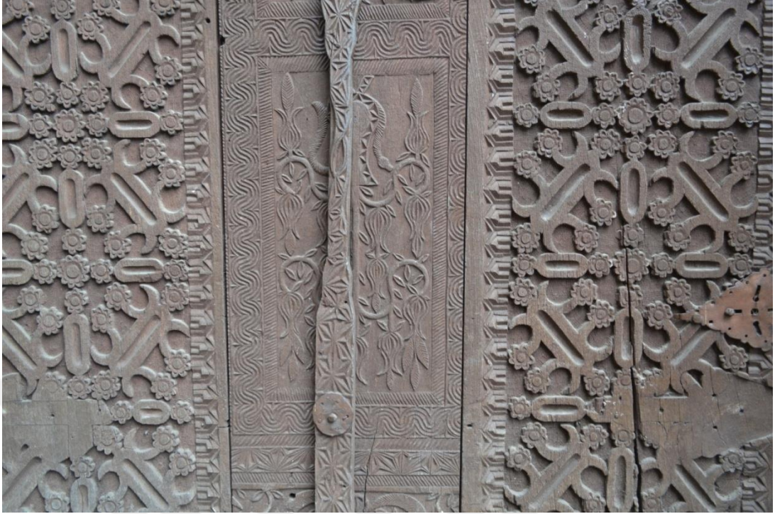
Fotoğraf 99: Taşçılar Köyü Merkez Camii Giriş Kapısı Yüzeyindeki Süslemelerden Detay
