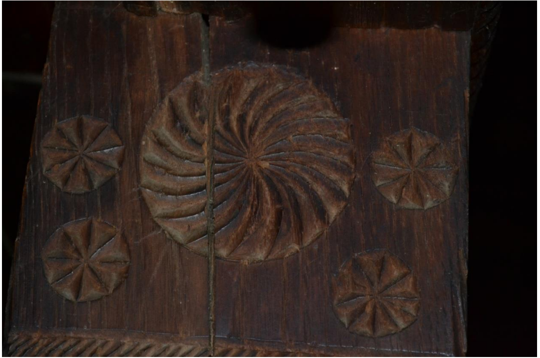
Fotoğraf 128: Güneykondü Mahallesi Camii Mahfil Kısmı Ahşap Direklerinden Detay
