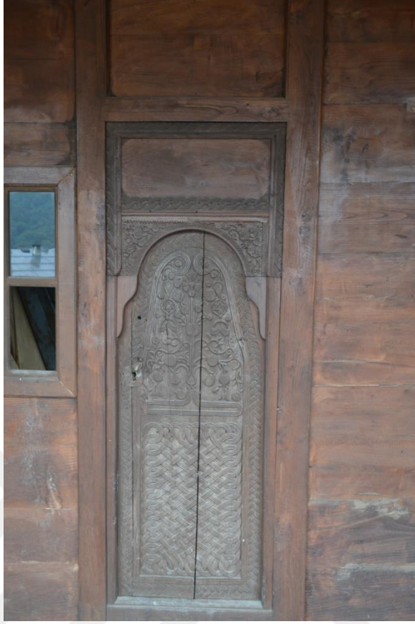
Fotoğraf 101: Taşçılar Köyü Merkez Camii Medresesi Kapısı
