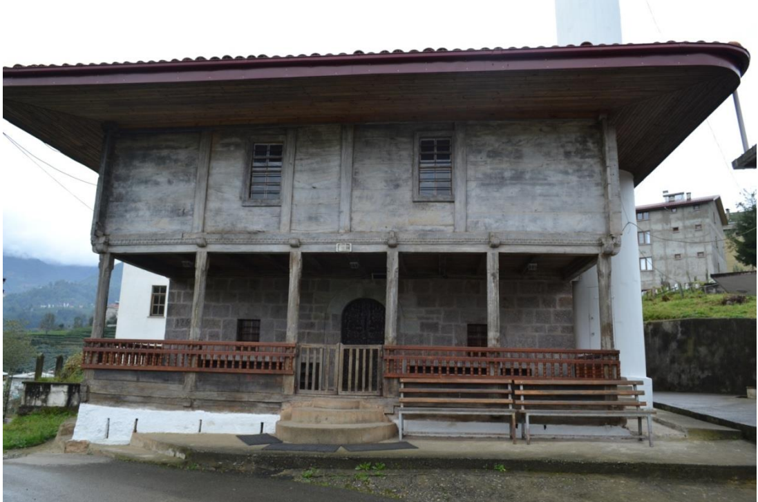
Fotoğraf 202:Mithat Paşa Camii Kuzey Cephe Genel Görünümü
