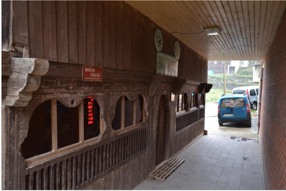
Fotoğraf 2: Uzungöl Beldesi Filak Camii Kuzey Kanattaki Son Cemaat Bölümü Genel Görünümü
