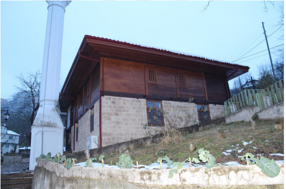
Fotoğraf 160: Günebakan Köyü Camii Güneydoğudan Genel Görünümü
