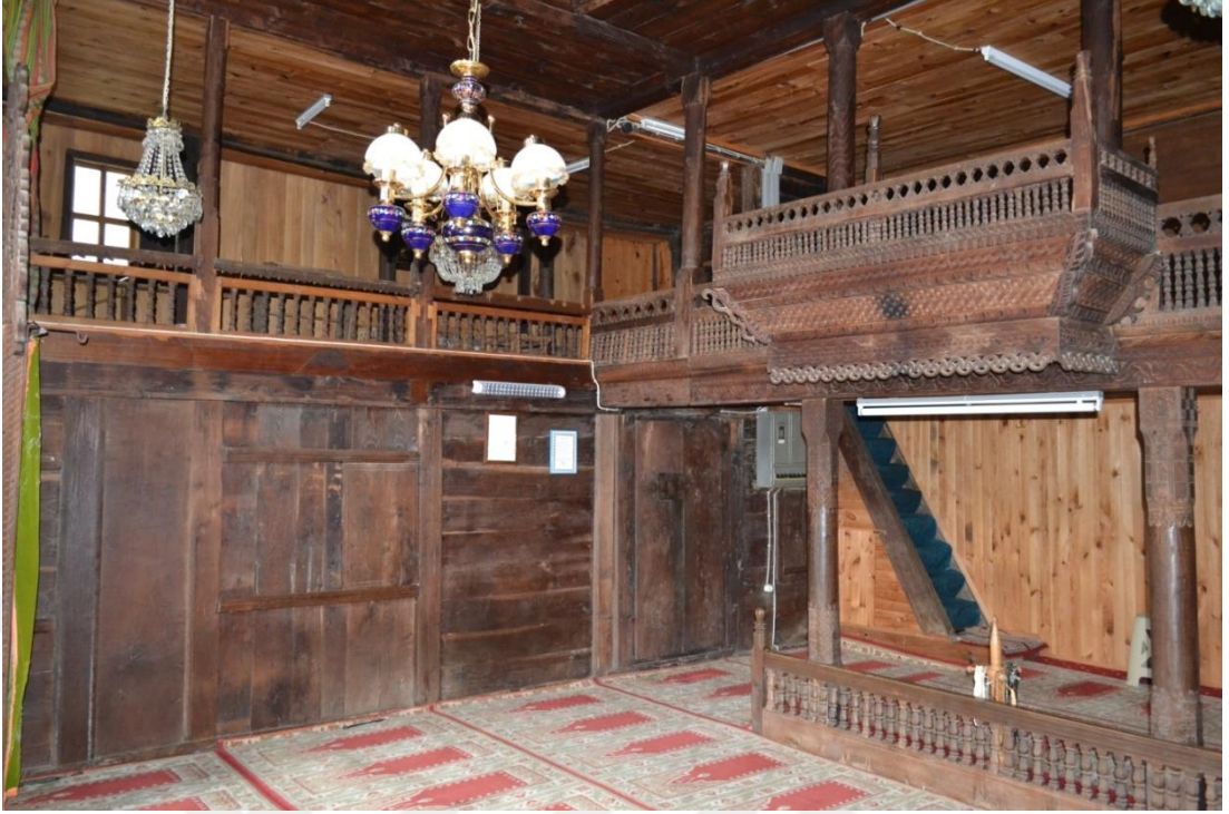
Fotoğraf 129: Güneykundu Mahallesi Camii Mahfil Kısım Genel Görünümü
