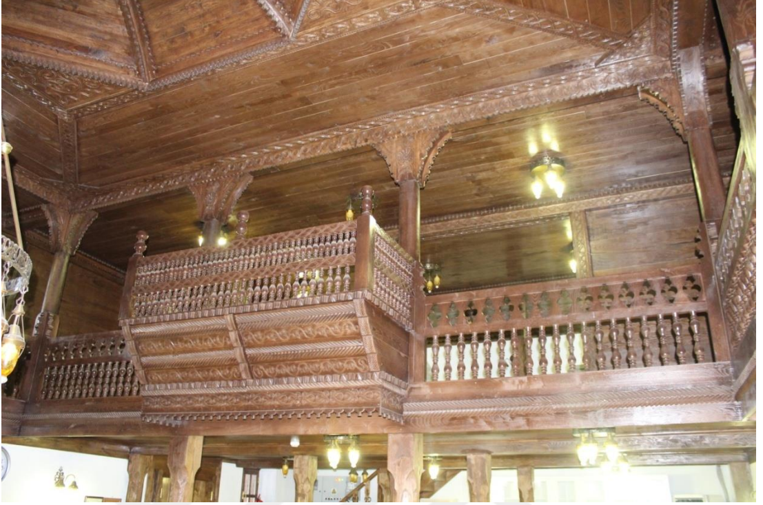
Fotoğraf 21: Taşören Beldesi Camii Mahfil Kısım Genel Görünümü
