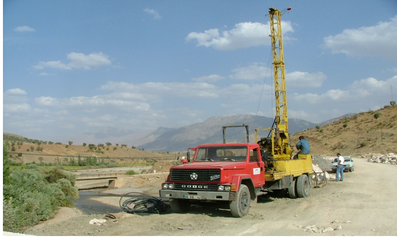
Şekil 4.10. SK 0+570 kuyu açma çalışmaları, bakış yönü kuzeydoğu.
