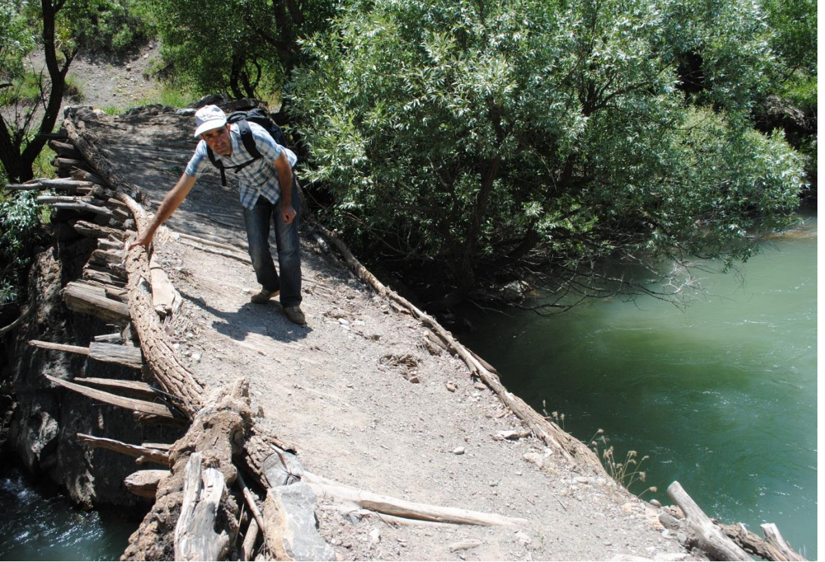
9.Dereiçi mezasının köprüsü
