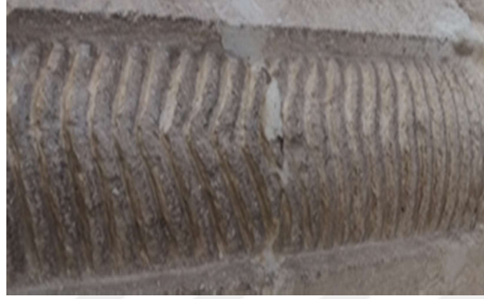
Şekil 3.15 Hüsrev Paşa Camisi birinci kabartma
