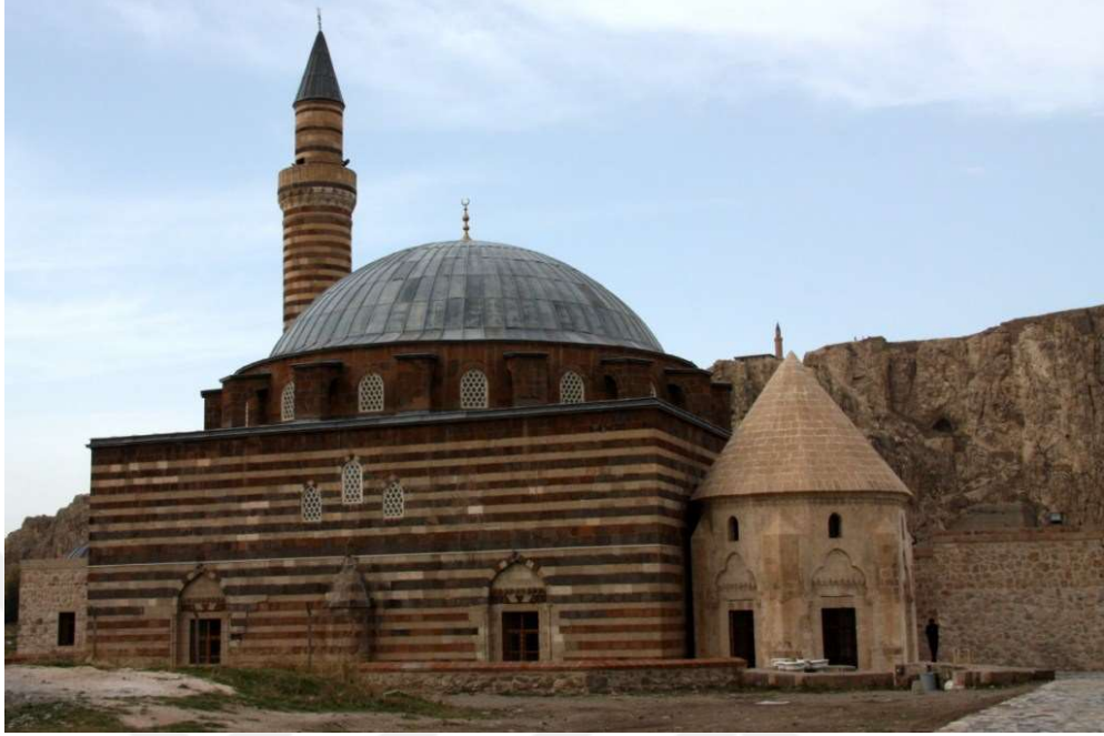
Şekil 3.3 Hüsrev Paşa Cami uzaktan görünüş
