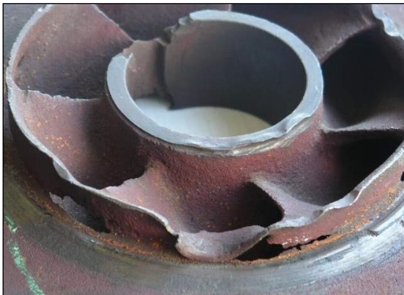
Şekil 1.5. Erozyon korozyonuna uğramış su pervanesi (URL-5 2015)
