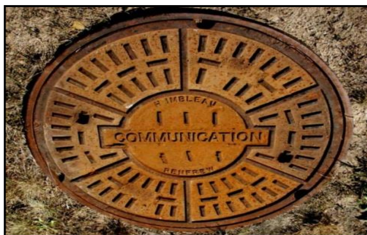
ekil 1.1. Homojen korozyona u ram, logar kapa , (URL-1 2015)
