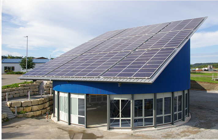
Şekil 22 Kraft firmasının geliştirdiği döner çatı sistemi [23]
