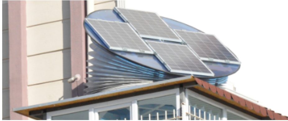
Şekil 34 DÇMA prototipinin TÜGEV üzerinde görülmesi
