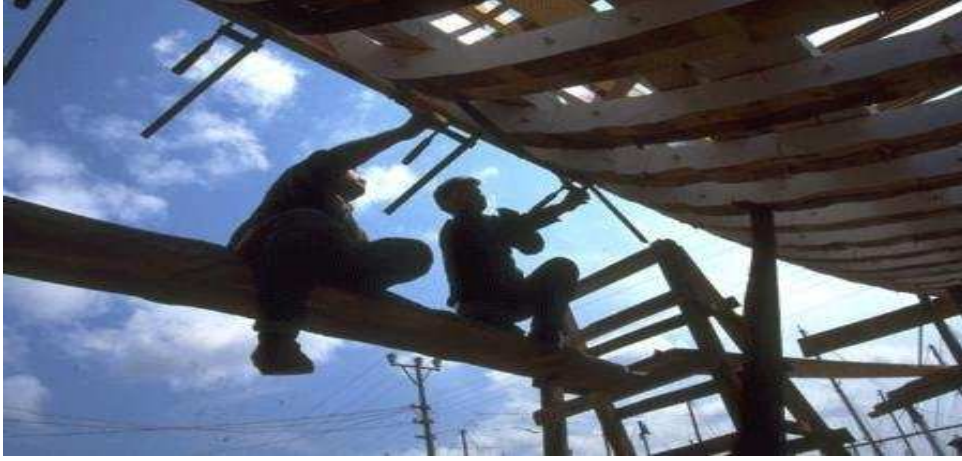
Şekil-11: İskele ve Yapı İnşaatı[52-b]
