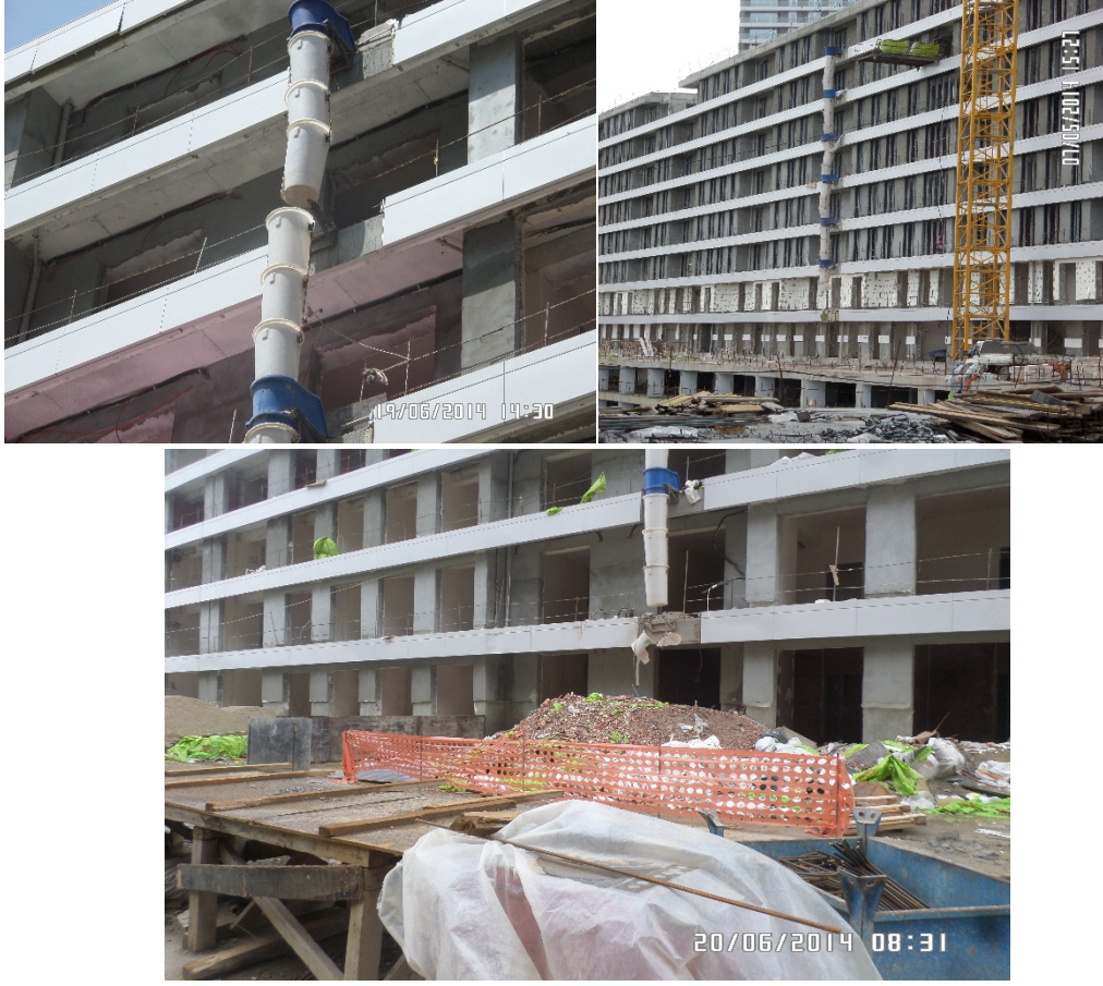
Resim 5: Atıkların uygun şekilde uzaklaştırılması ve güvenlik şeridi ile çevrilmesi
