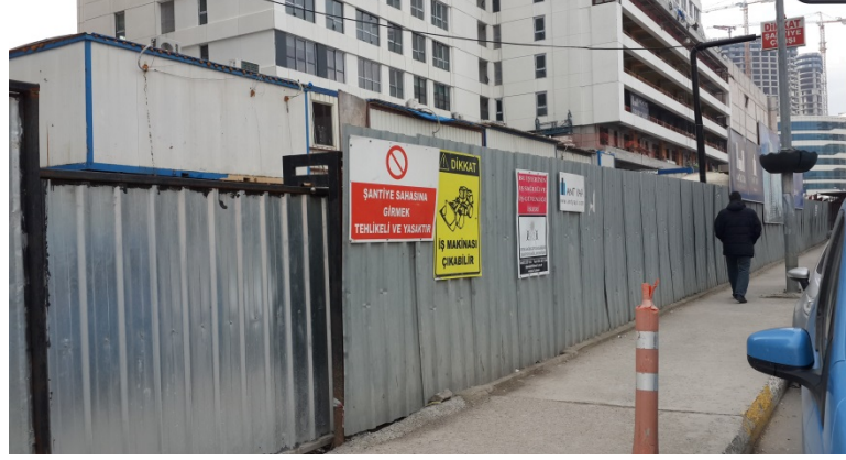
Resim 2: Ümraniye'deki bir karma konut projesinden yapı alanına güvenli giriş için uyarı levhaları
