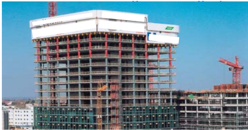
Resim 9: Şantiyede uygulanan rüzgâr panelleri 5
