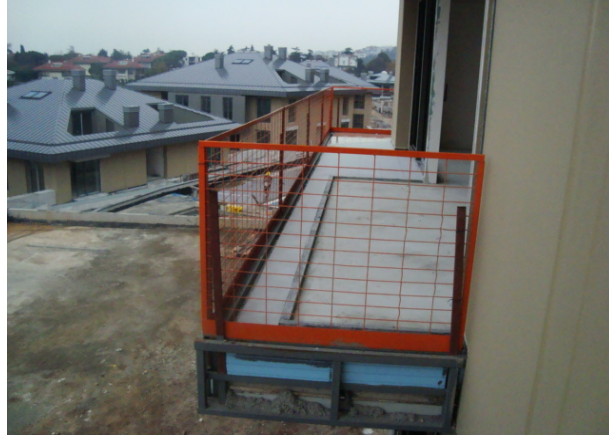
Resim 8: Çamlıca'da 65.000m 2 lik bir şantiyede kullanılan katlanabilir cephe bariyerleri
