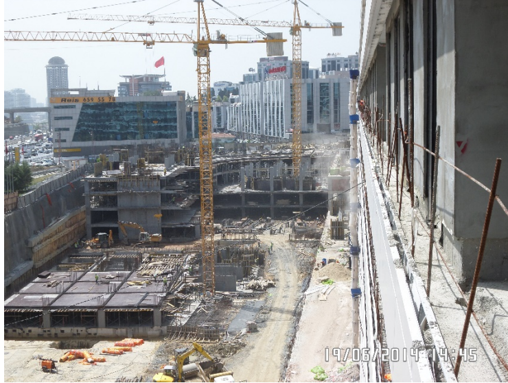
Resim 19: Kule (yapı) vinçleri
