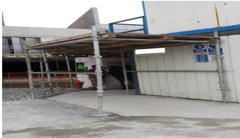
Resim 1: Ümraniyede 80.000m 2 lik karma konut projesinde bina girişlerinde uygulanan koruma çatı örneği
