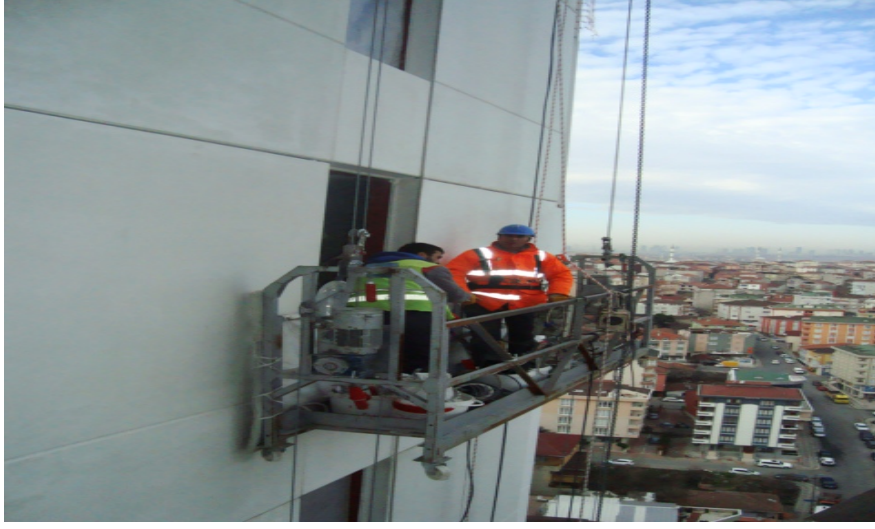
Resim 12: İstanbul-Ümraniye’de bir konut inşaatında kullanılan asma iskele
