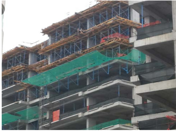
Resim 7: İstanbul Göztepe’de 66 dönüm üzerine kurulu karma bir projeye ait şantiyeden T tipi güvenlik ağı örneği
