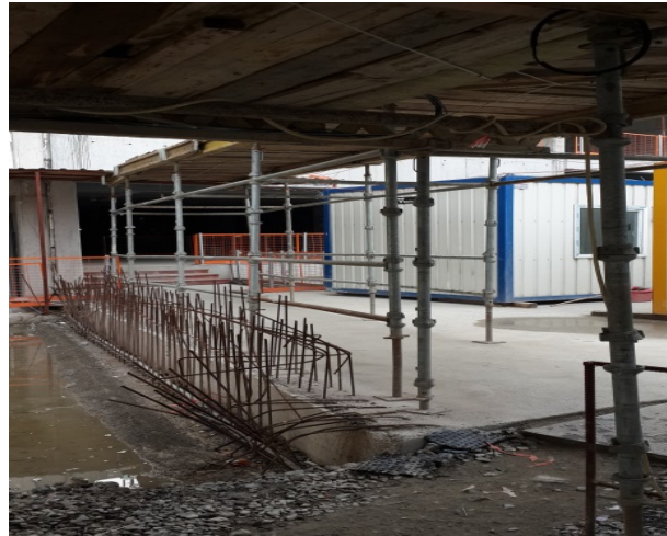
Resim 3: Sahadan binaya uygun geçit örneği
