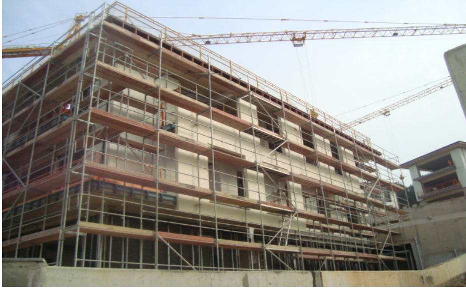
Resim 13: İstanbul Çamlıca’da bir villa konut inşaatında uygun iskele örneği
