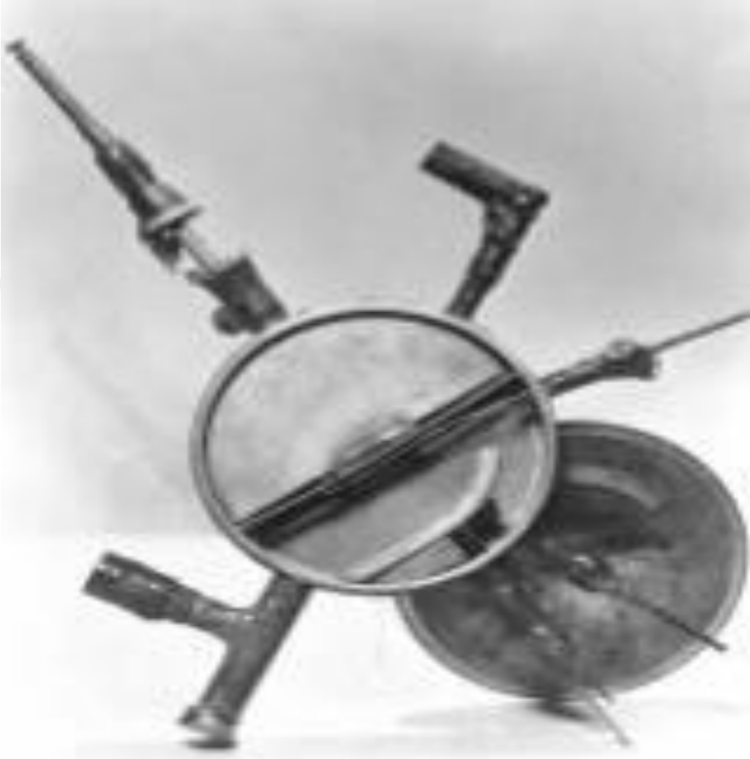
Şekil 2.4. Lavrance tarafından tasarlanan ilk siklotron (Yıldız 2014)
