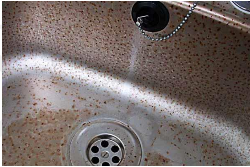
Şekil 1.4. Çukurcuk korozyonuna uğramış bir lavabo (URL-4 2017)
