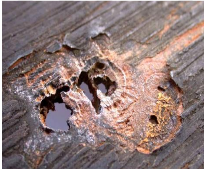
Şekil 1.7. Biyolojik korozyona uğramış su deposu (URL-7 2018)
