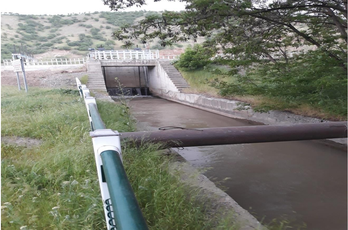
Şekil 3.19. Regülatöre bağlı ana sulama kanalının görüntüsü
