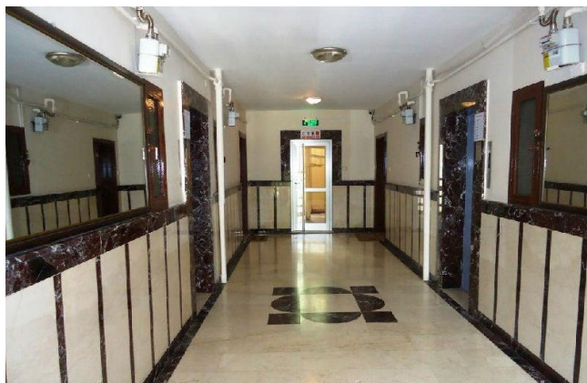
Figure 4.4 Hall view of Etap Konutlari
