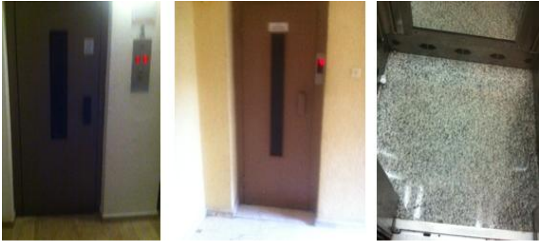
Figure 4.14 Elevators at Etap Konutlari
