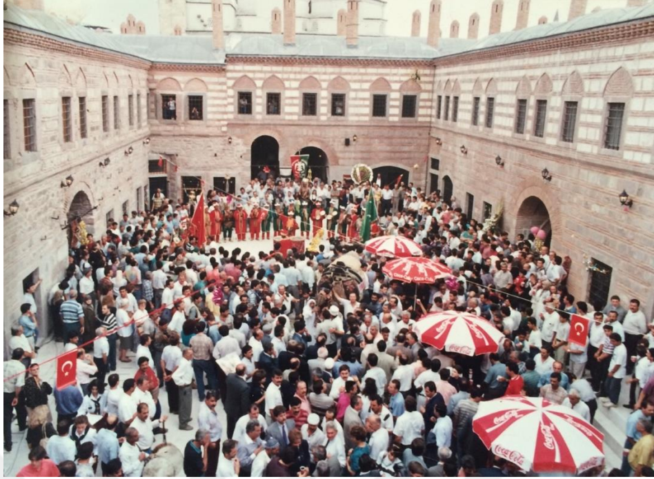
Figure 4.70a. Kızlarağası Inn, inner courtyard (Kızlarağası Inn archive, 1990s)
