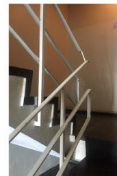
I: Stair detail
