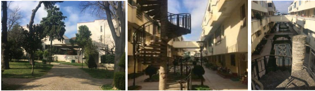
Figure 2.62. Yeşilköy Mass Housing Complex, a. General view, b, c. Inner street and courtyard, Adapted from “Yeşilköy Toplu Konut Sitesi: Çevresi ile Yaşayan Bir Mimari”, İ. Akkuzu, 2019, Betonart , p.32-37.
