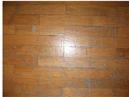
D: Floor parquet
