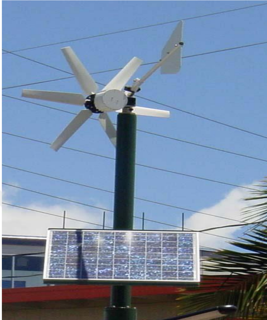
Şekil 2.24. Rüzgar türbini ve PV modülün birlikte kullanıldığı bir hibrit sistem
