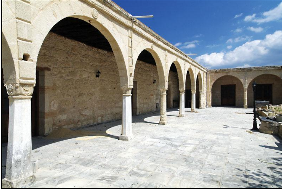
Foto 44: Dipkarpaz Kasabasındaki Geleneksel Mimariyle Kemerli Yapılardan ve Taş Malzemeden Yapılmış Olan Bir Tesisin Restore Edilmiş Hali
