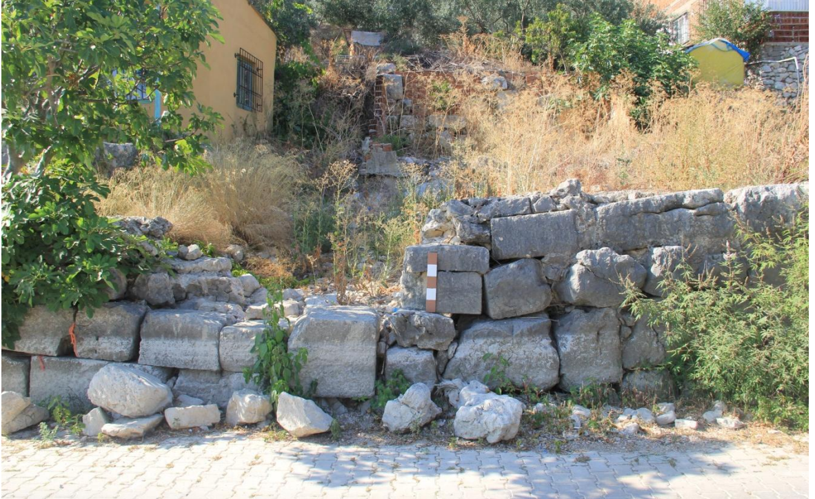
Resim 37: Doğu Sur "9" numaralı duvar
