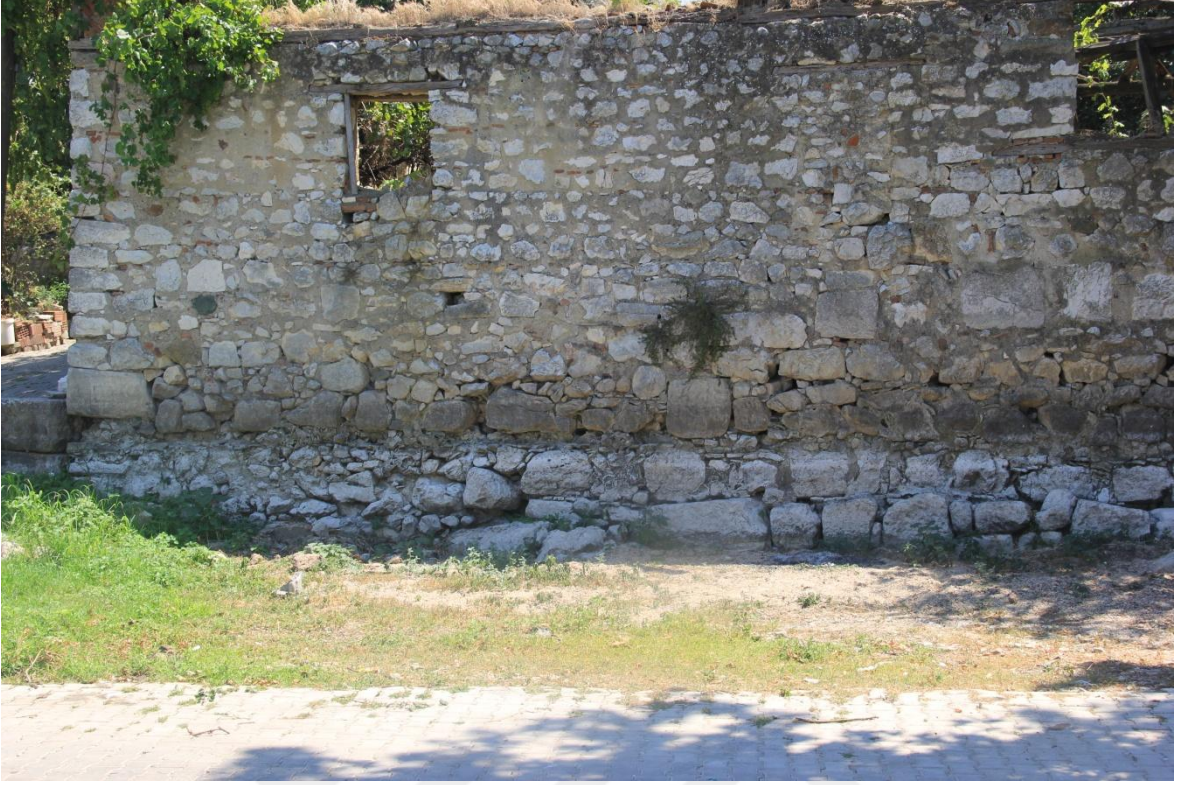
Resim 53: Batı Sur “20” numaralı duvar dođu yan
