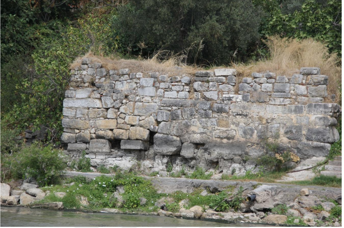
Resim 44: Güney Sur "14" numaralı duvar
