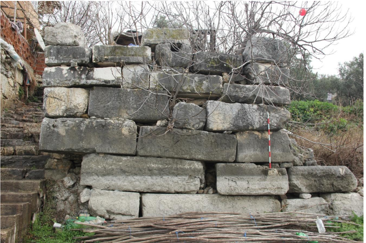
Resim 41: Güney Sur "12" numaralı duvar
