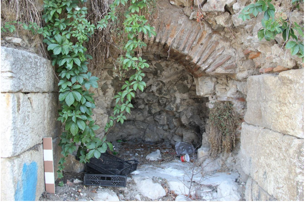
Resim 26: Doğu Sur "2" numaralı duvar Kapı
