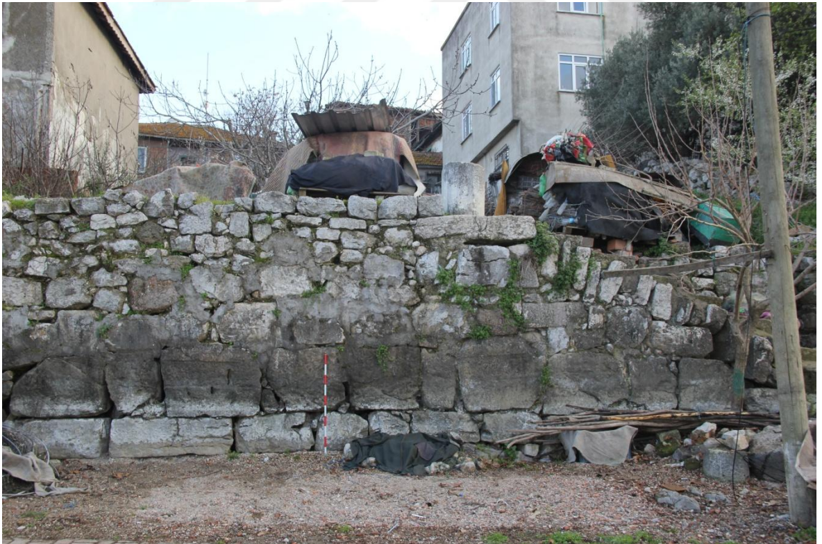
Resim 56: Batı Sur "22" numaralı duvar dođu yan
