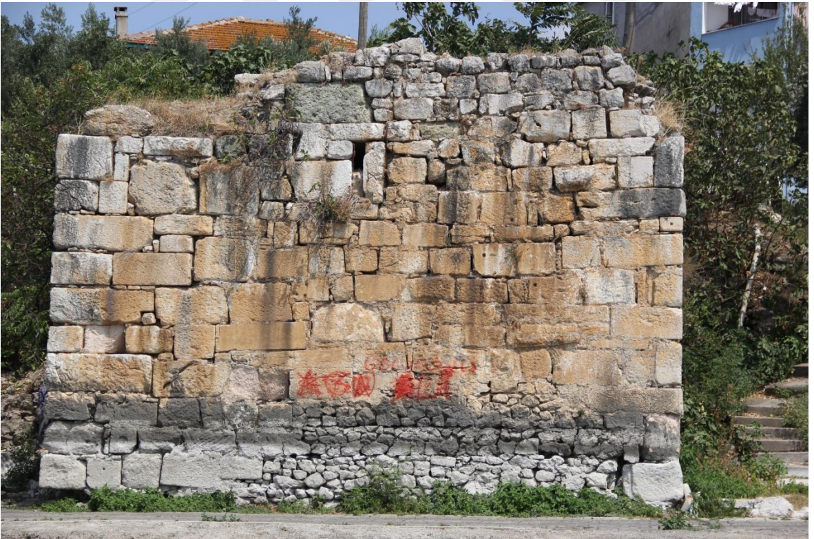
Resim 45: Güney Sur "15" numaralı duvar
