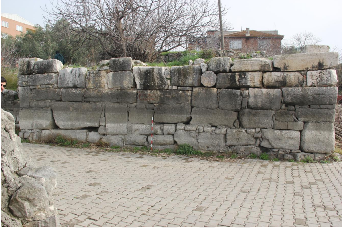
Resim 38: Güneydoğu Köşe Kule (11) kuzey yüz
