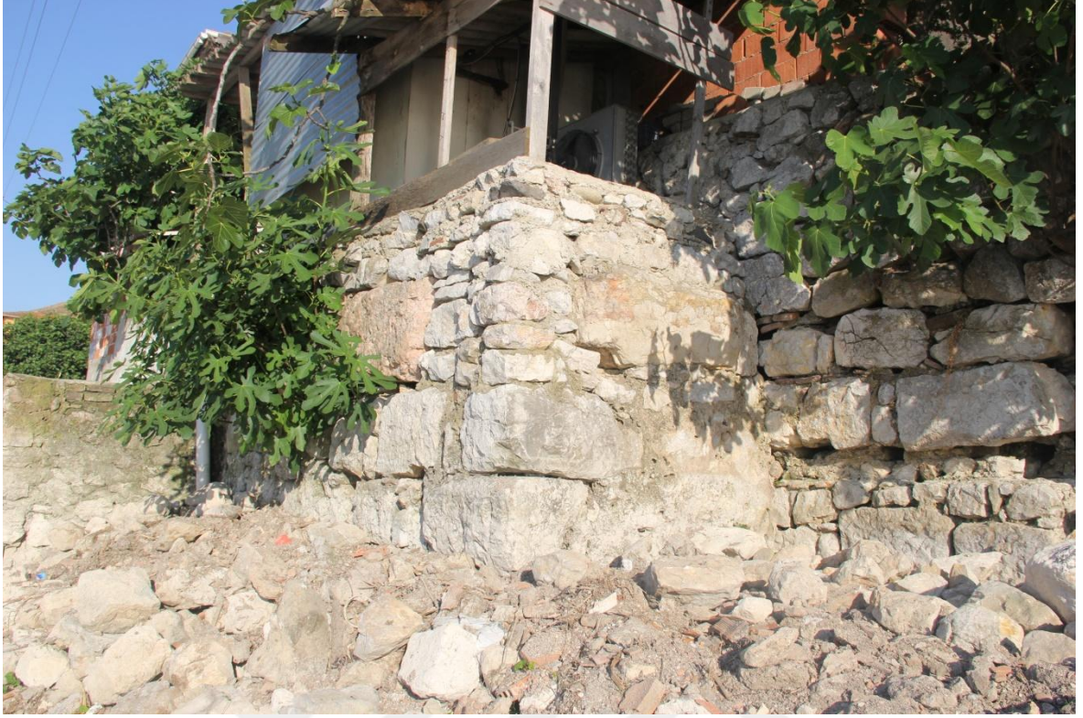
Resim 55: Batı Sur "22" numaralı duvar batı yan
