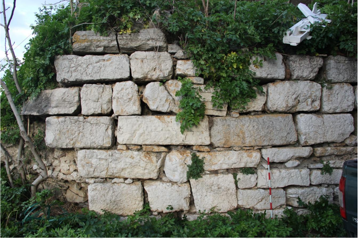
Resim 61: Kuzey Sur “29” numaralı duvar Kule batı yüz
