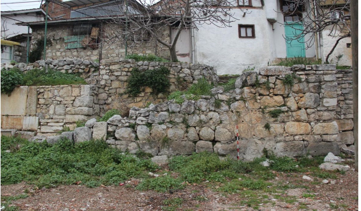
Resim 29: Doğu Sur "3" numaralı duvar merdiven kuzey yüz
