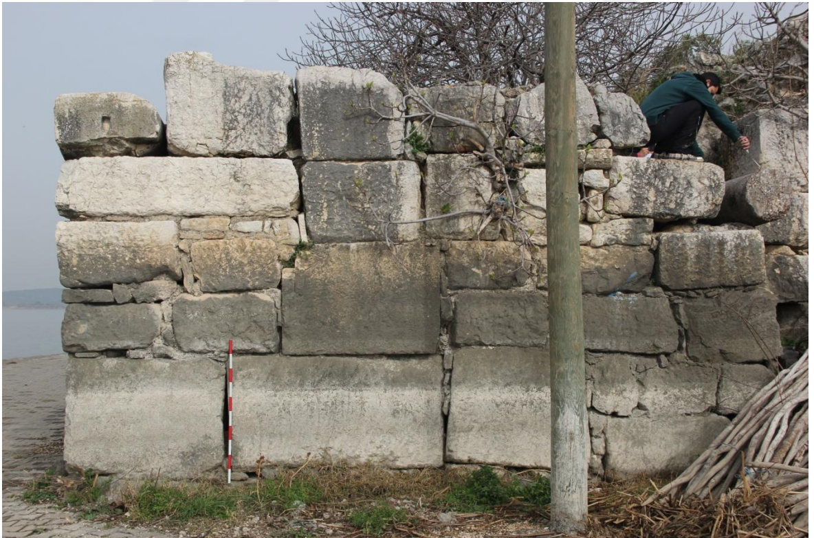
Resim 39: Güneydoğu Köşe Kule (11) batı yüz
