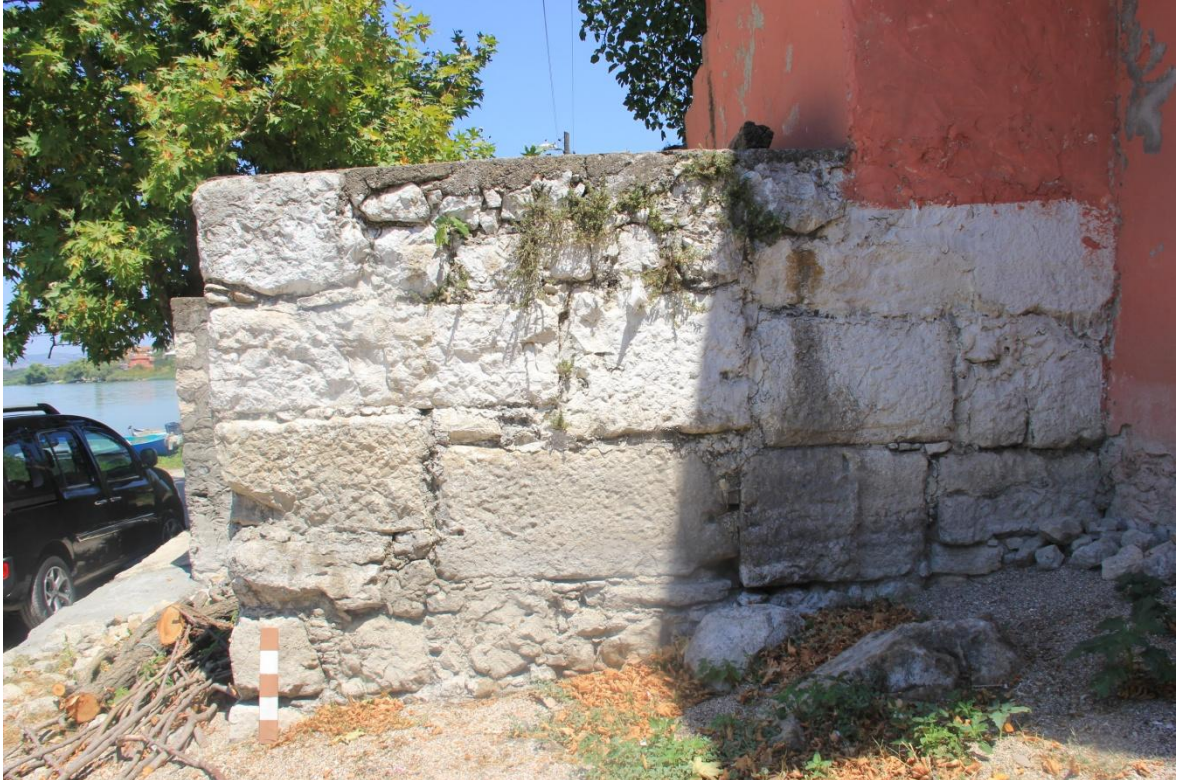
Resim 52: Batı Sur "20" numaralı duvar batı yan
