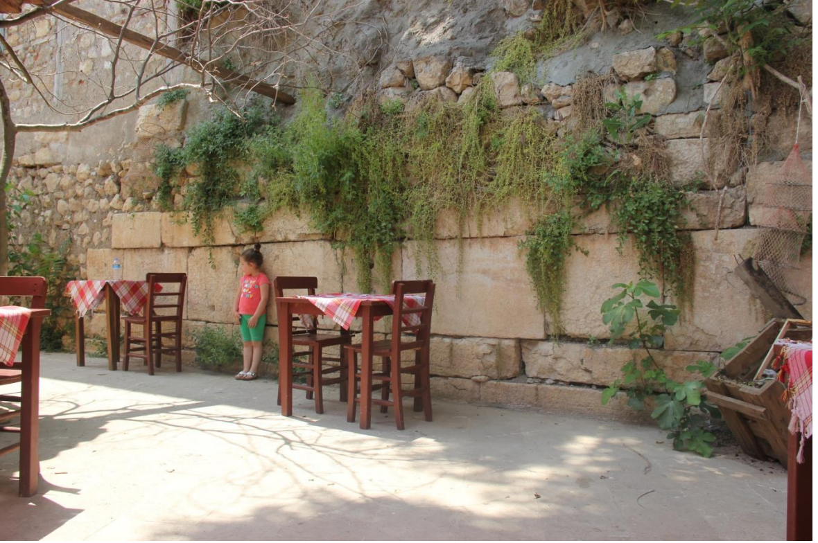
Resim 23: Doğu Sur "1" Numaralı duvar
