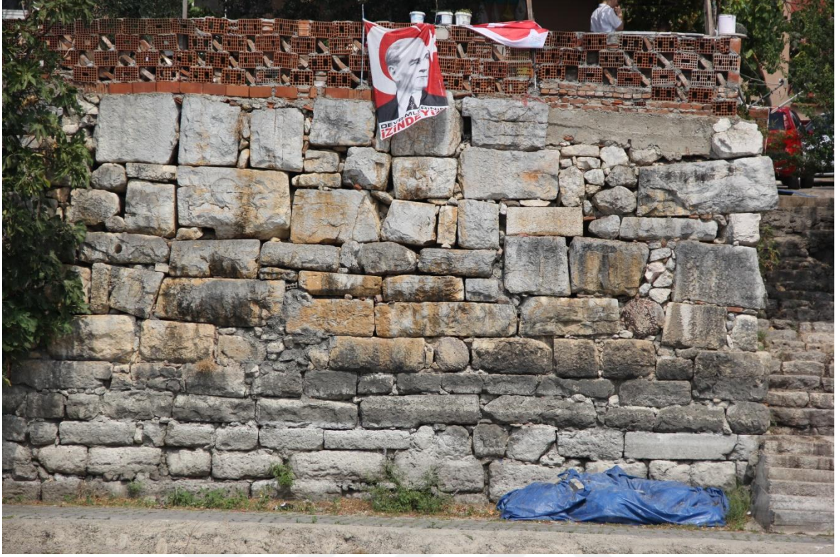
Resim 42: Güney Sur "13" numaralı duvar
