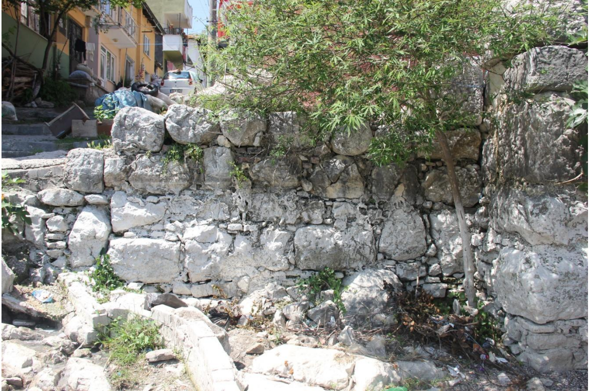
Resim 33: Doğu Sur “6” numaralı duvar doğu uzantı
