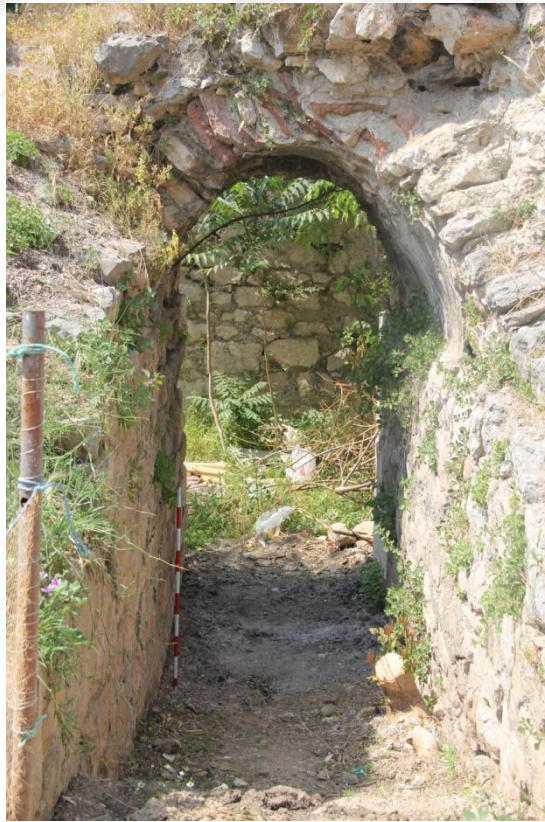
Resim 8: Taş Kapı Beşik Tonozlu Dromos Tipli Kapı
