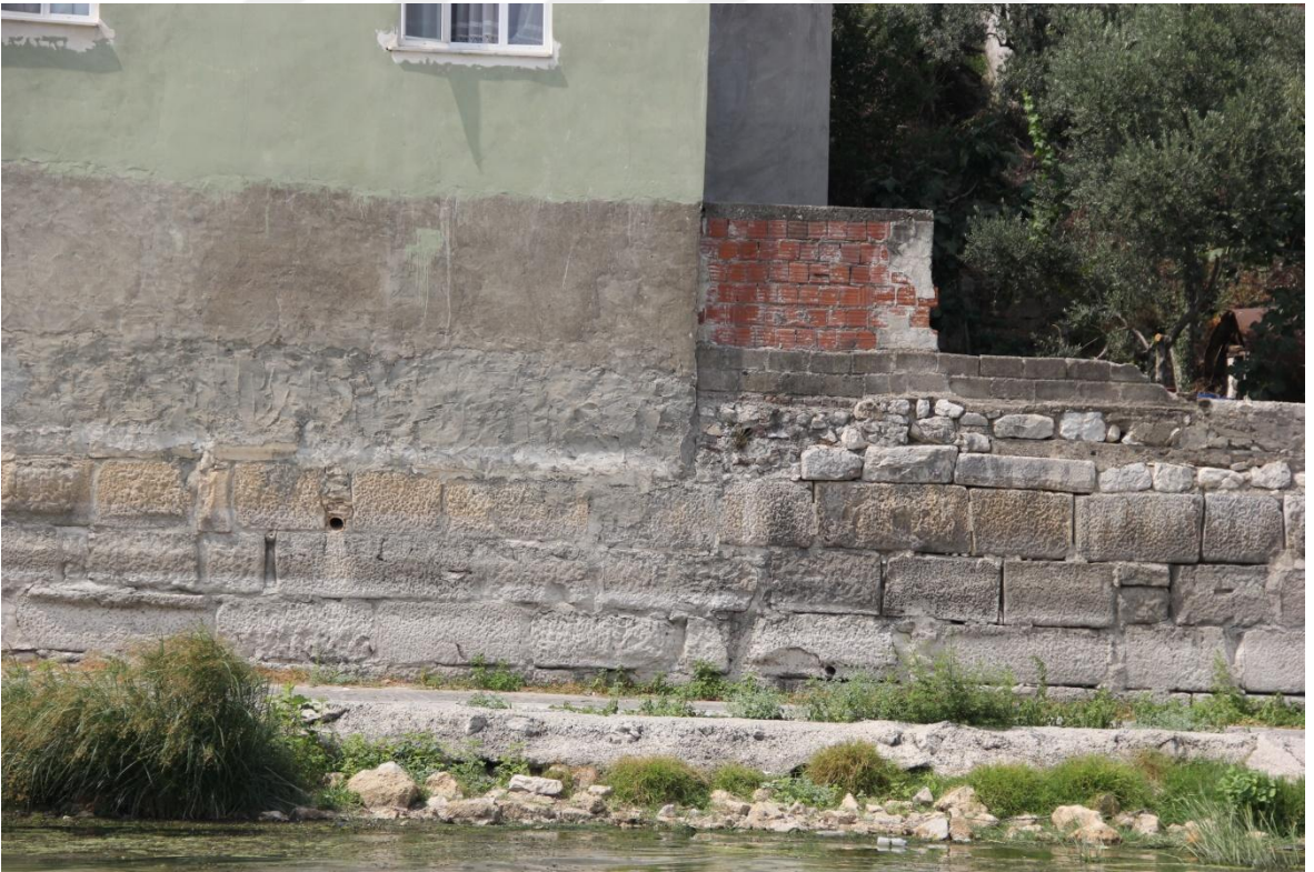
Resim 35: Doğu Sur “8” numaralı duvar
