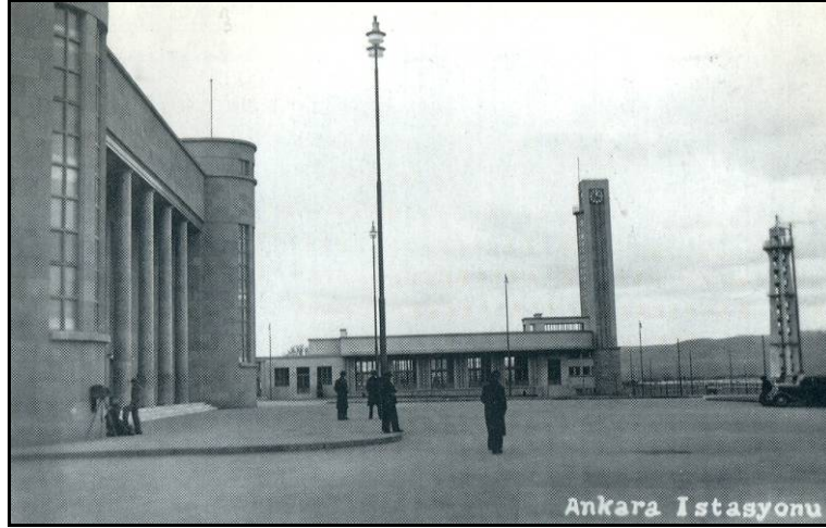
Figure 4.18 - The station complex built on a deserted land (Ankara Posta Kartları ve Belge Fotoğrafları Arşivi Kataloğu, 1994, p. 20)
