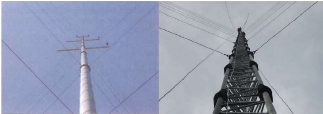
(a) (b) Şekil 2.1. Boru tipi (a) ve kafes tipi (b) ölçüm direkleri.
