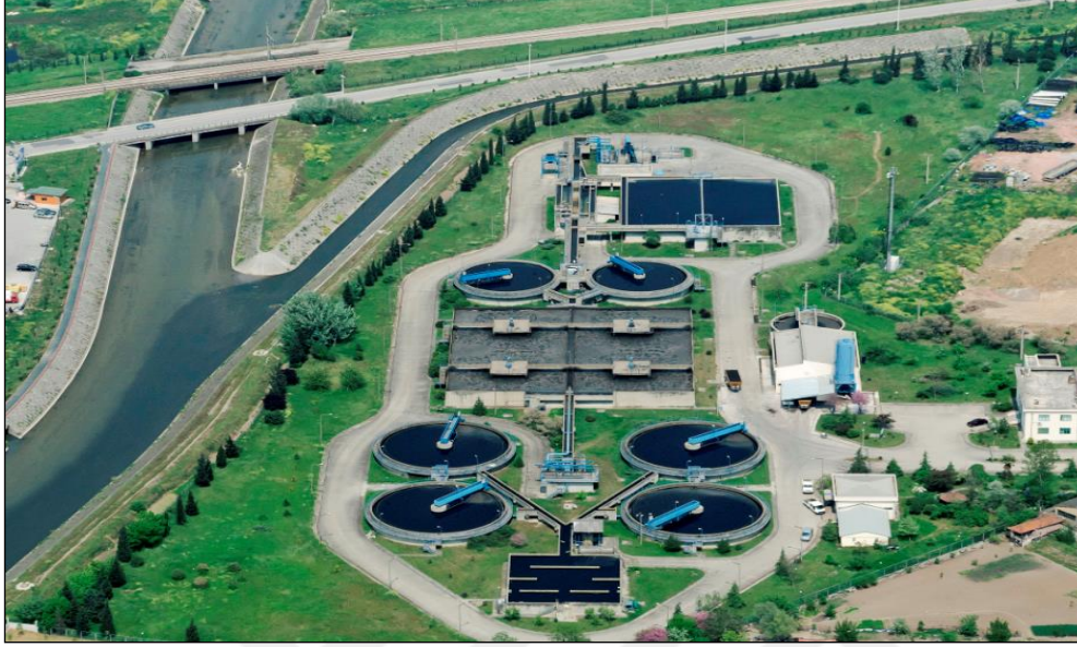
Şekil 4.2: 42 Evler Atıksu Arıtma Tesisi genel görünümü.
