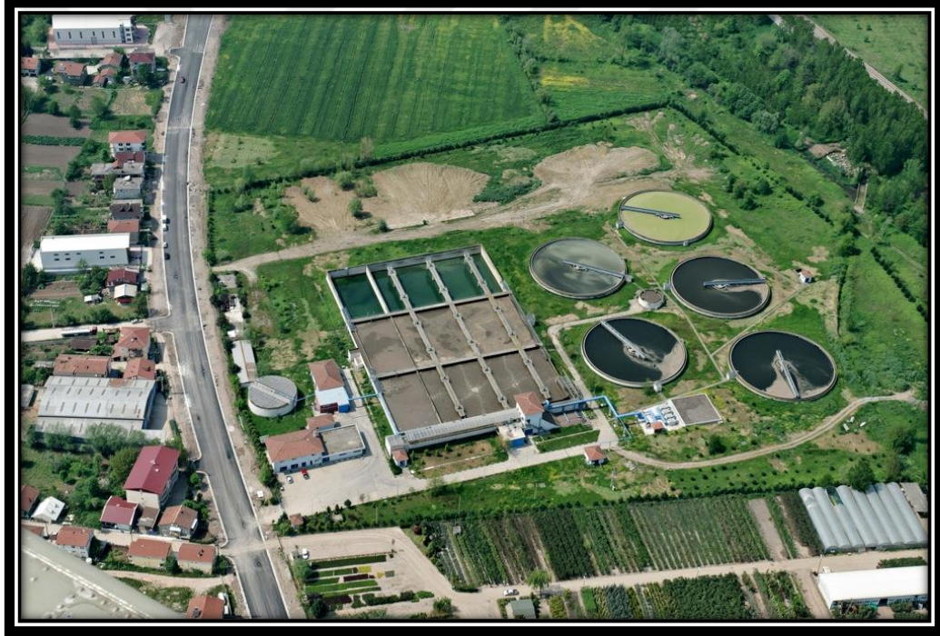
Şekil 4.5: Kullar Atıksu Arıtma Tesisi genel görünümü.
