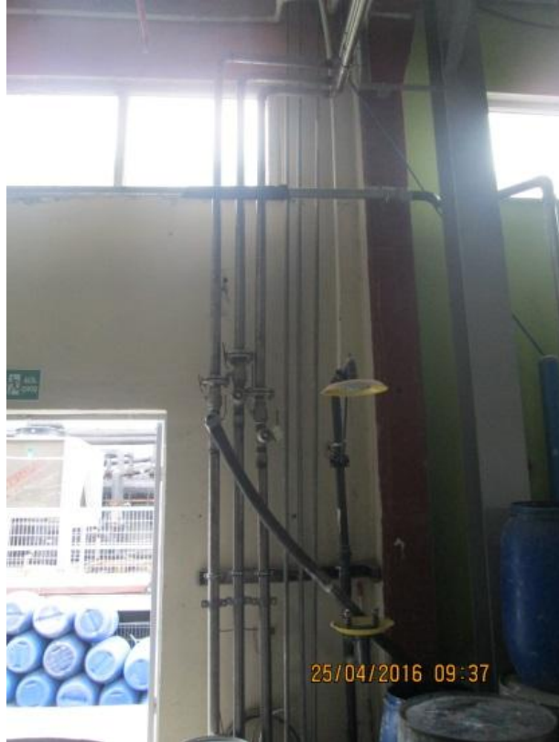
Şekil 7.9 : Zemin kat Butil akrilat, sitren ve vinil asetat sitren elleçleme hattı .
