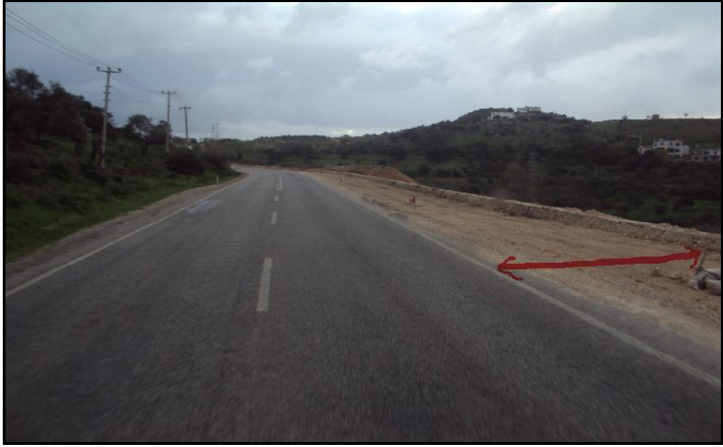
Foto 2.8. Bodrum-Turgutreis Arasında Çift Şeritli Yol Yapım Çalışması.
