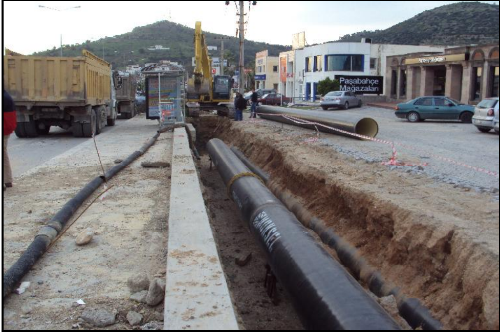
Foto 3.1. Geyik Barajı’ndan Su Getirme Projesi İle Turgutreis’de Su Sorununu Ortadan Kaldırması Planlanan Altyapı Çalışması.
