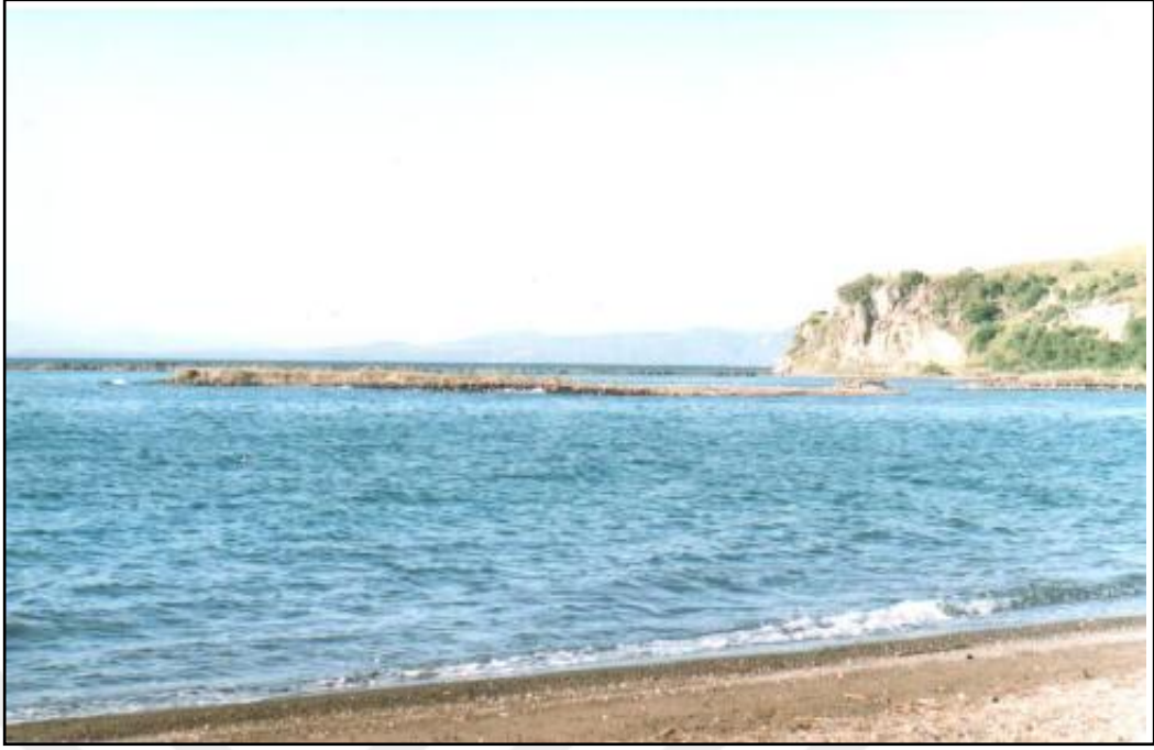
Fotoğraf 33: Güzelhisar Çayı'nın ağız kısmındaki yapay dalgakıran
