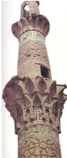
Resim 1; İsfahan Seraban Camii minaresinde tuğla ve sırlı tuğla bezeme. Büyük Selçuklu, İran 1115-30.
