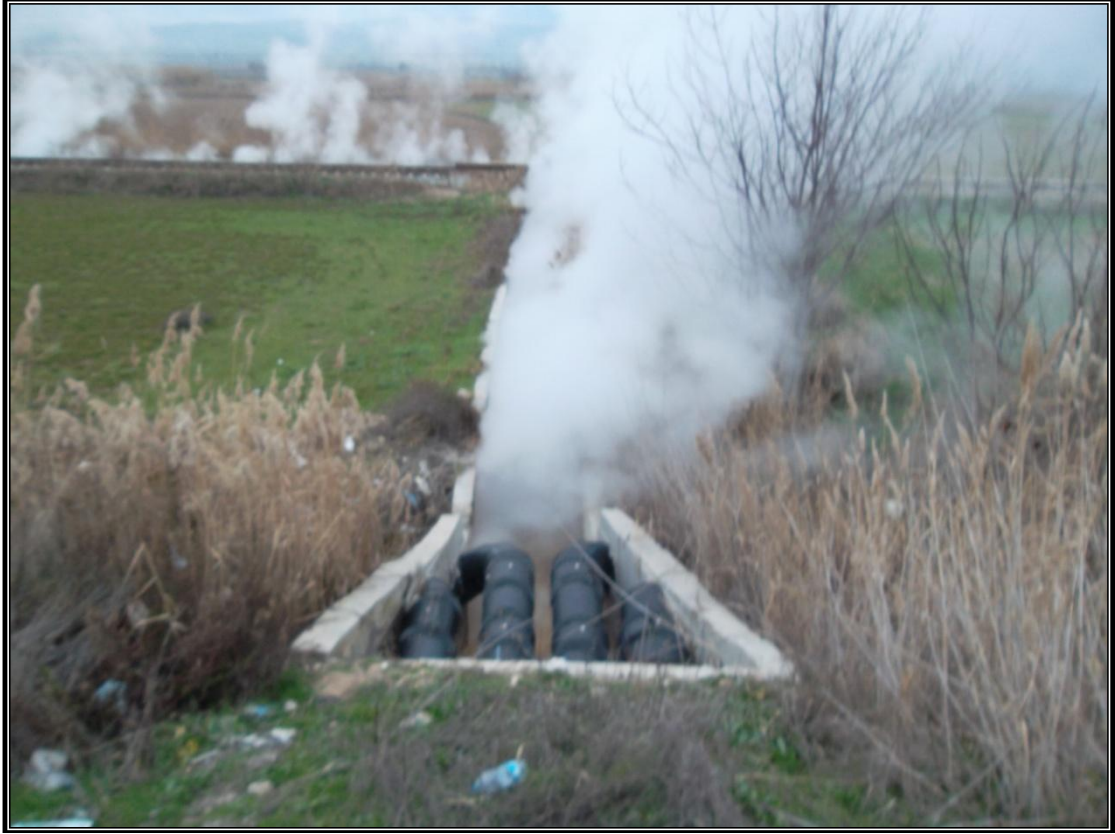
Foto 93. Jeotermal Sular Bazı Dönemlerde Elektrik Üretim Tesislerinde Kullanıldıktan Sonra Kontrolsüzce Derelere Bırakılmaktadır.
