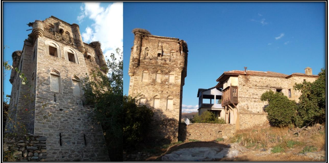
Foto 117. Beyler Konağı ve Kulesi (Diğer adı Gedik Ahmet Paşa Konağı)'nin Görünüşü.
