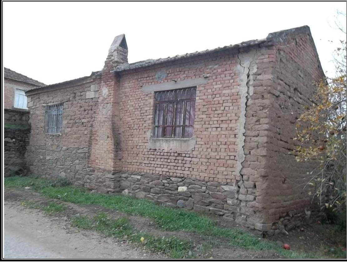
Foto 53. Yazırlı Köyünde Kerpiçten Yapılmış Bir Konut.(Duvarların alt kısmı taş kullanılarak örülmüştür. Evin duvarlarının tamirat gören kısımları tuğla ile örülmüştür)
