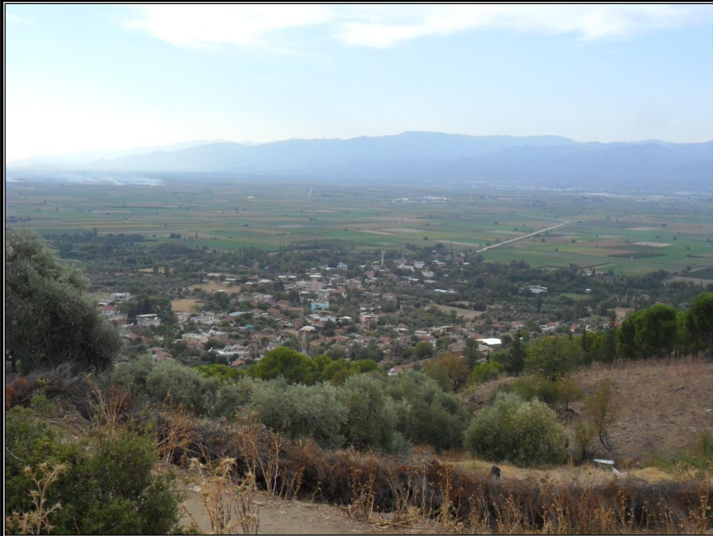
Foto 41. Karıncalı Dağı Eteklerine Kurulu Yazırlı Köyünde Yerleşmenin Çekirdeği Vadi Ağzında İken Yeni Gelişim Sahası, Civar Köyleri Nazilli'ye Bağlayan Yolun Etrafında Gelişmektedir.
