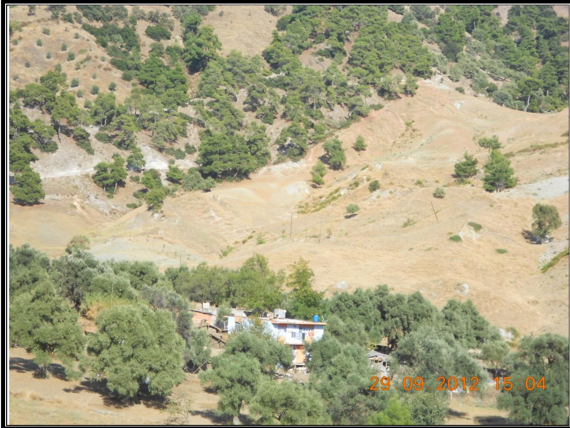
Foto 10. Ktle Hareketlerine rnekler: Knepe Mahallesiinde Elektrik Direklerinde Kaymalar.
