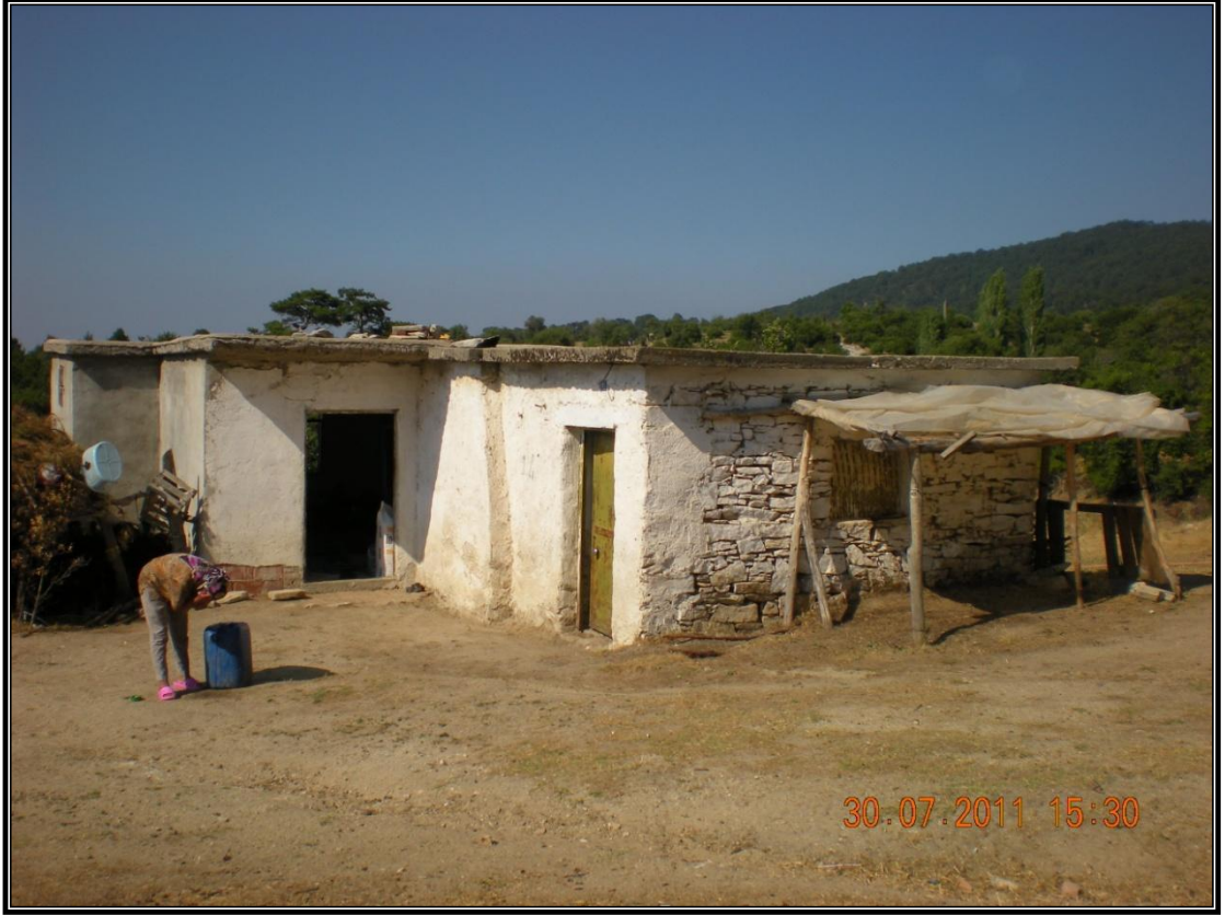
Foto 48. Elmalıklar. (Karıncalı Dağı üzerinde geçmişte elmalık olarak kullanılan eklentiler, günümüzde fonksiyonunu kaybedip, evin bir odası haline gelmiştir. Elmalıkların duvarlarında havalandırma için yapılan kısım hâlâ durmaktadır.)
