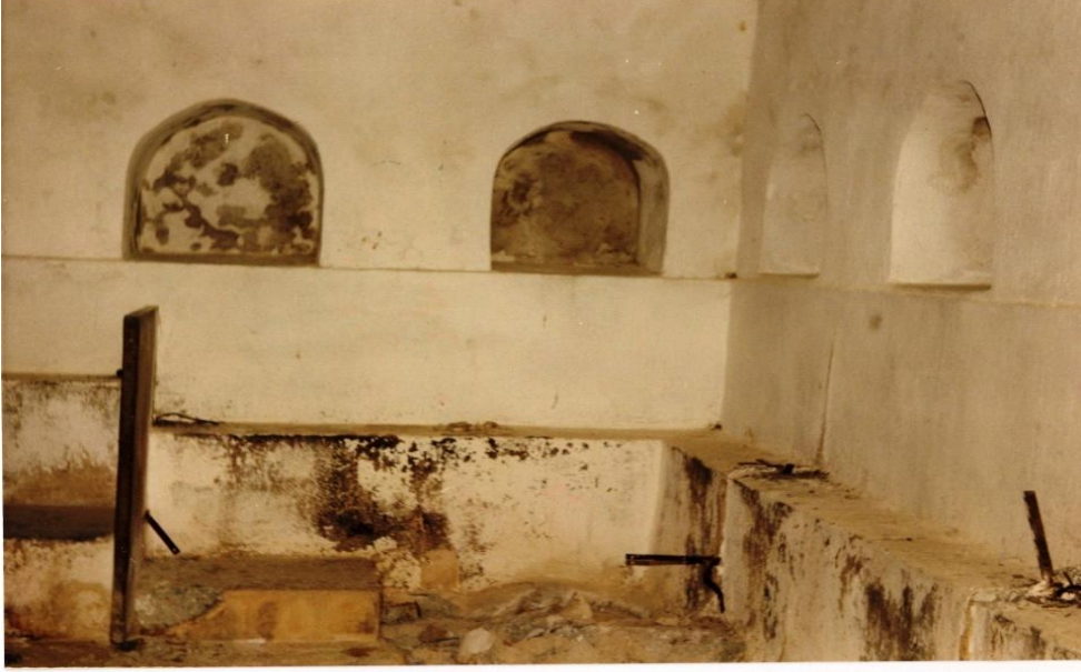
Konya-İlgın Sahip Ata Kaplıcası (Onarım öncesi 1985)
