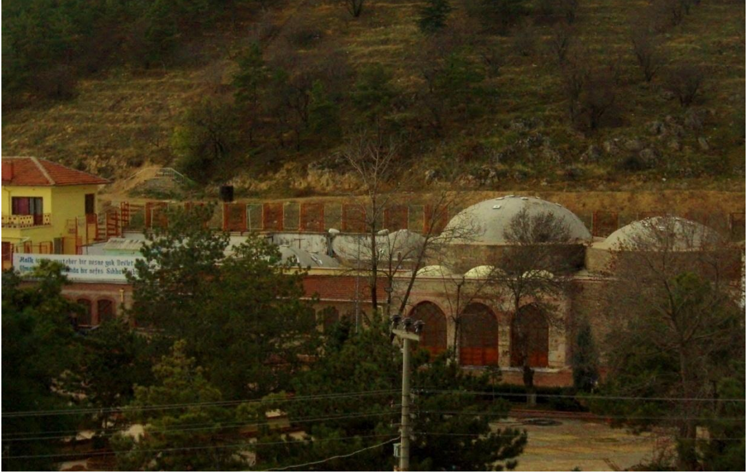
Fotoğraf: 25 Kaplıca Ön Cephesi
