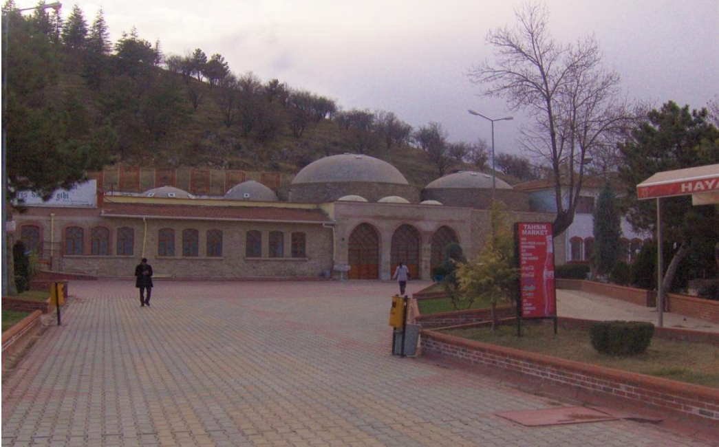
Fotoğraf: 30 İlgin Kaplıcasının Ön Cepheden Görünümü
