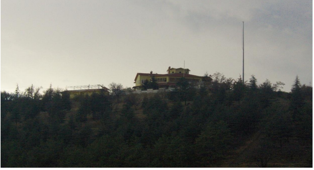
Fotoğraf: 27 Kaplıcaya Sonradan Yapılan Dağ Oteli Görünümü
