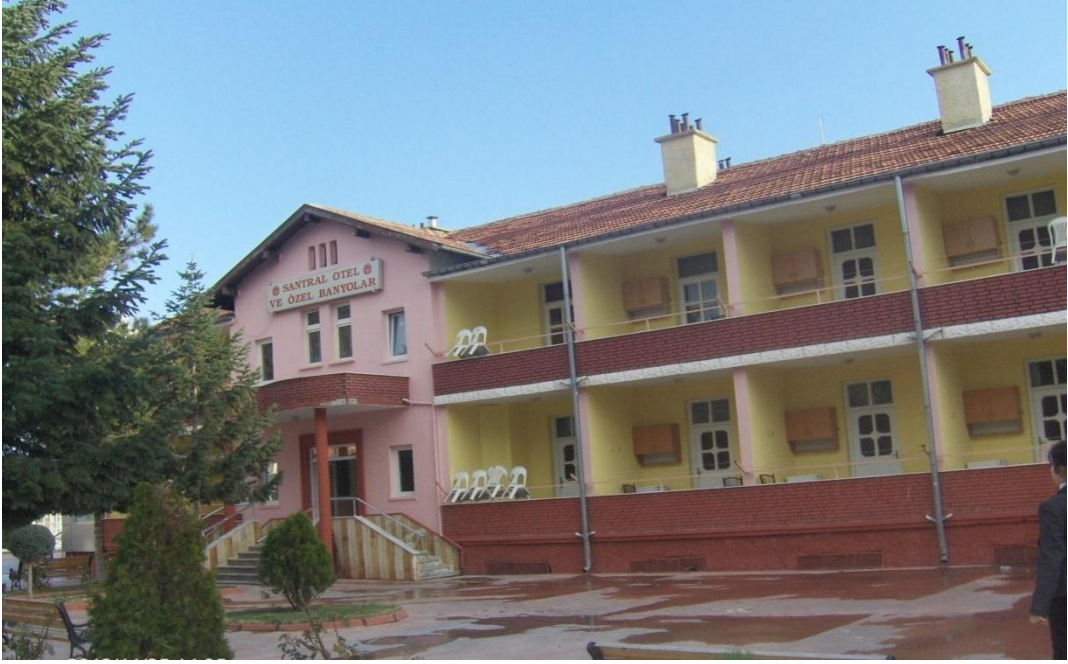
Fotoğraf: 28 Kaplıcaya Sonradan Yapılan Santral Otel'den Görünüm
