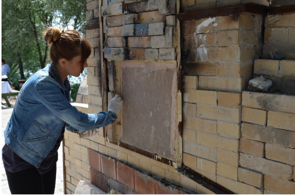
Resim 22; Fırın Kapağının Karşı Koruyucu Karışım İle Kaplanmış Tuğla İle Örülmesi Fotoğraf: Mustafa SİR
