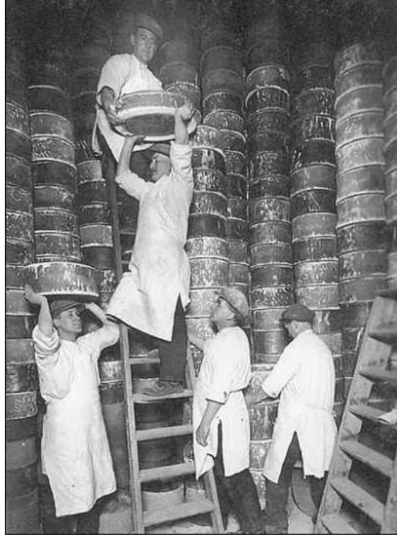
Resim 11; Sagar kutularının fırına yerleştirilmesi http://www.thepotteries.org/bottle_kiln/bottle_kiln_two.htm 29.09.2011
