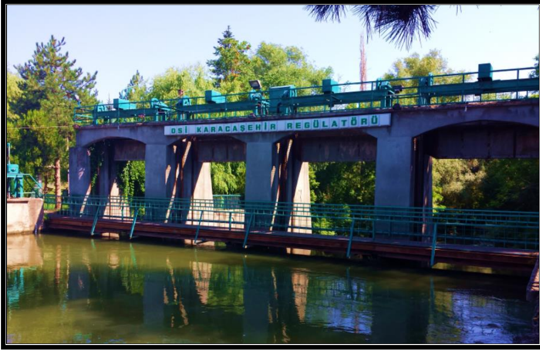
Fotoğraf 5. Porsuk Çayı'nın Sularını Bir Miktar Kabartarak Sağ ve Sol Sahil Sulama Kanallarına Sevk Eden Karacaşehir Regülatörü
