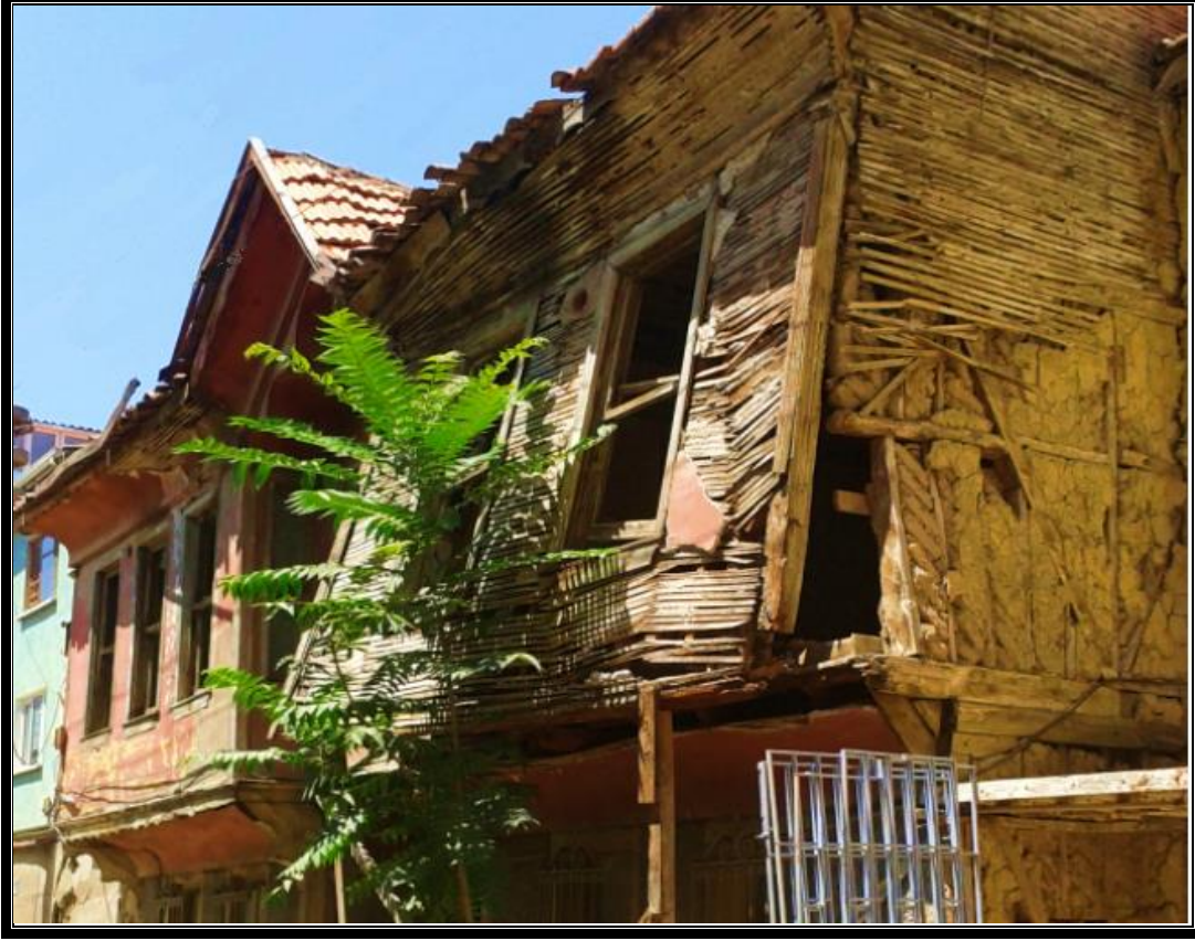
Fotoğraf 23. Hımış ve Bağdadi Yapı Tekniğinin Birlikte Kullanıldığını Gösteren Metruk Haldeki Bir Odunpazarı Evi
