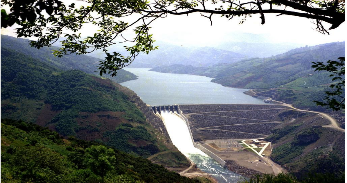
Şekil 4. Kaya dolgu baraj örneği Altinkaya Barajı (URL-5).
