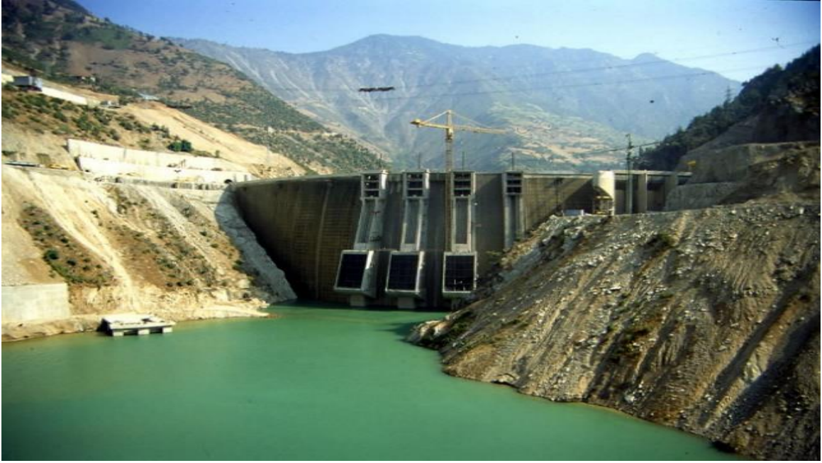
Şekil 7. Sır barajı (URL-5).
