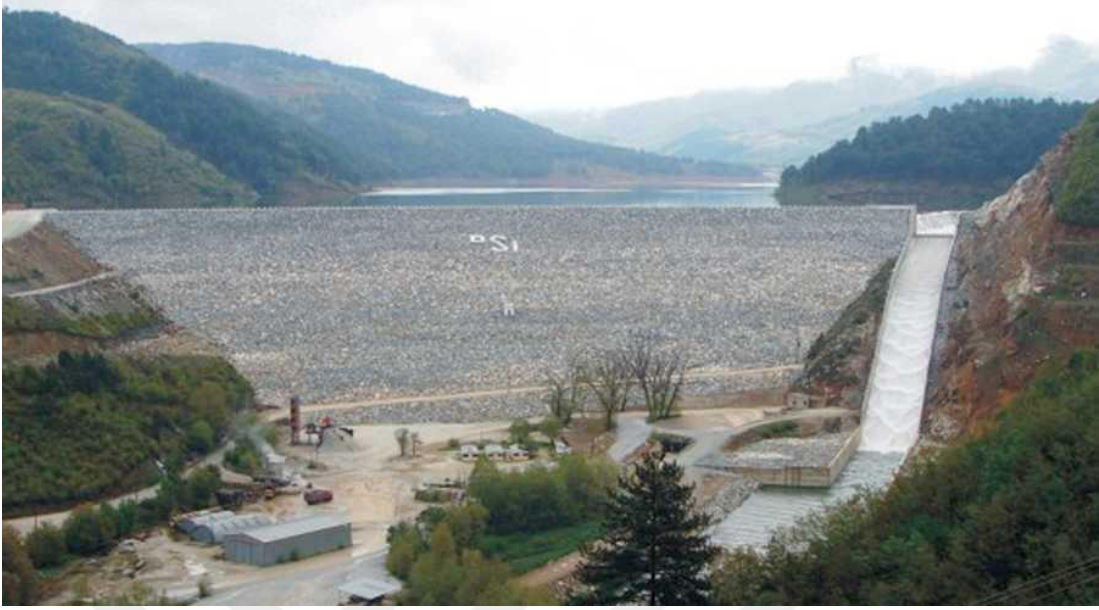
Şekil 5. Toprak dolgu baraj örneği Yapraklı Barajı (URL-6).
