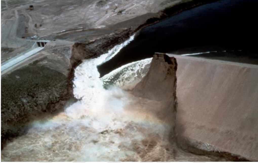
Şekil 14. Borulanma nedeniyle yıkılan Teton Barajı
