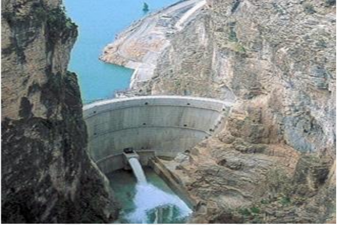
řekil 2. Kemer baraj örneęi Gezende Barajı (URL-2).
