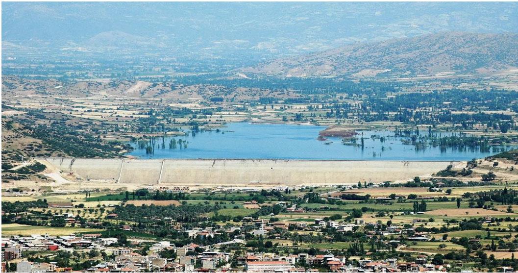
Şekil 8. Beydağ barajı (URL-5).
