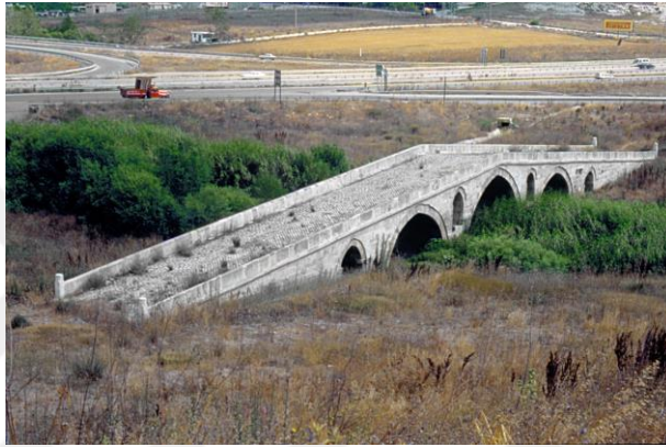
(Resim-107) Harami dere Kapı Ağası köprüsü
