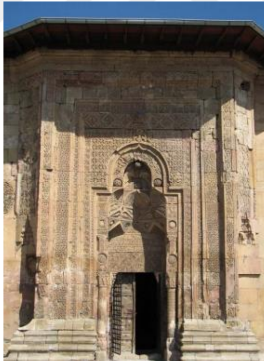
(Resim-48)Sivas Divriği Ulu Camii, Taç Kapı Batı,
