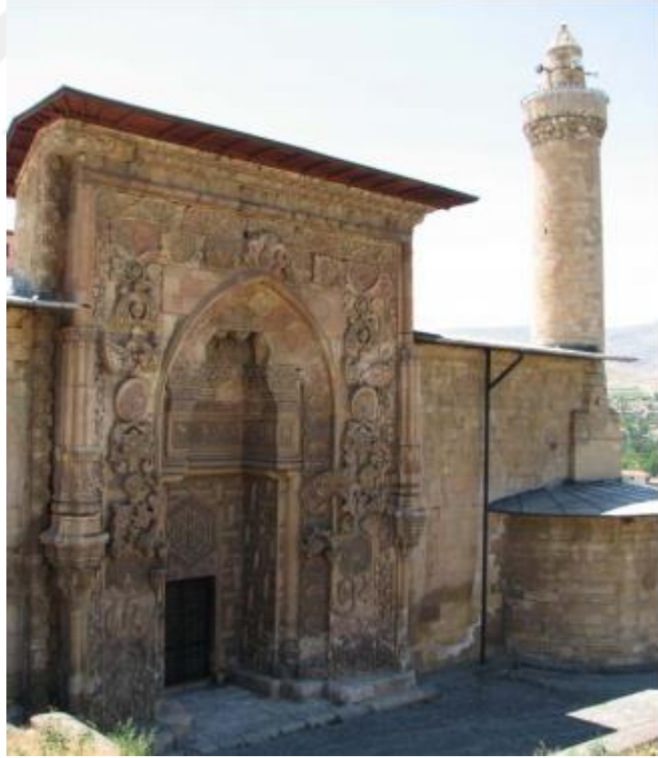
(Resim-50)Sivas Divriği Ulu Camii, Taç Kapı, Kuzey
