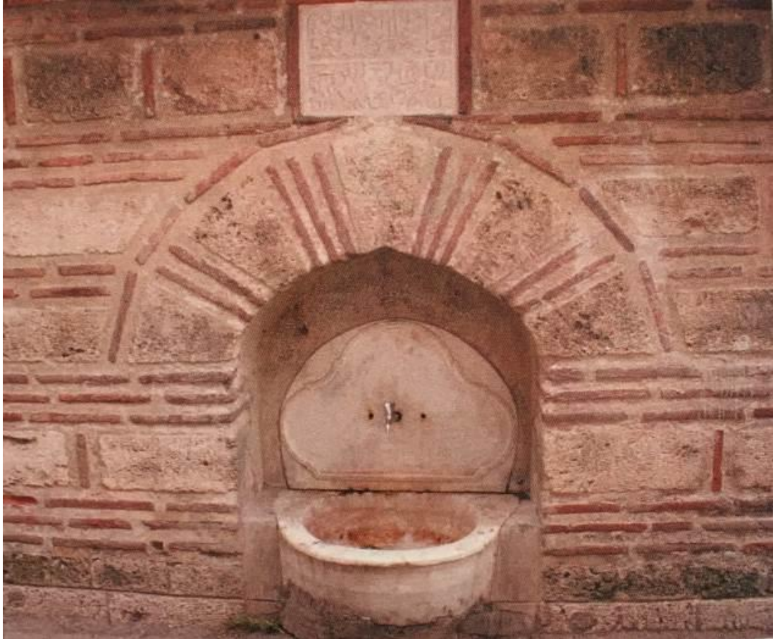
Fotoğraf 143. Umurbey Cami Çeşmesi Genel Görünüm (Bursa Kültür Varlıkları Envanteri Anıtsal Eserler, s.464)
