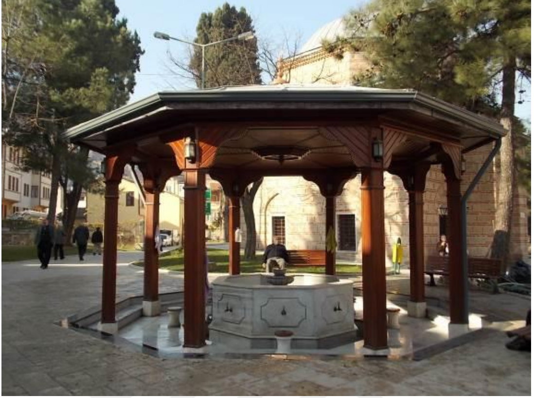
Fotoğraf 106. Hamzabey Cami Şadırvanı Genel Görünüm
