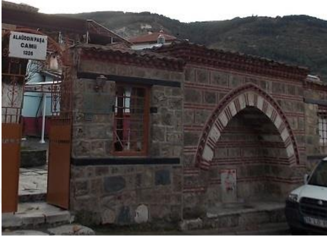
Fotoğraf 35. Alaaddin Paşa Camii Çeşmesi Genel Görünüm
