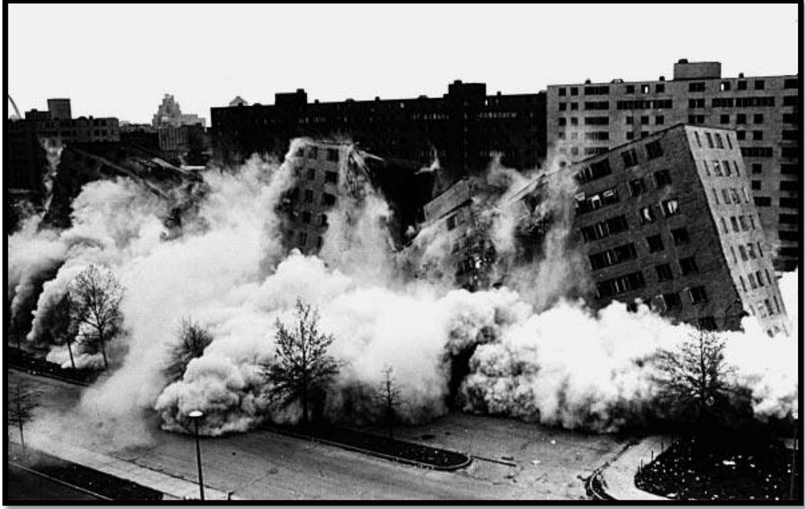
Şekil 4.55 Pruitt Igoe Kompleksi'nin yıkım anı.
