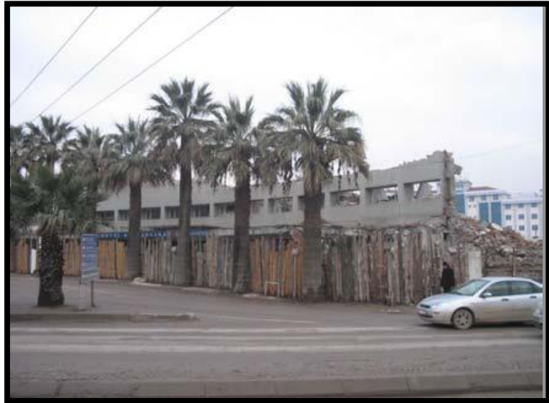
Şekil 4.58 Yıkım sırasındaki durumu.
