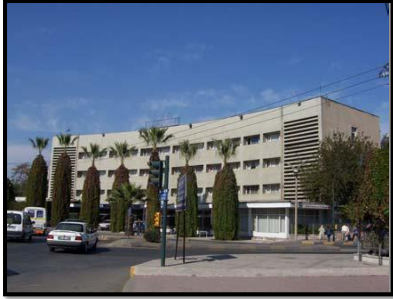
Şekil 4.57 Yıkımdan önceki durumu.
