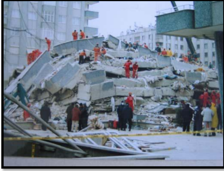
Şekil 4.5 Yıkılan Zümrüt Apartmanı'nın görünüşü.
