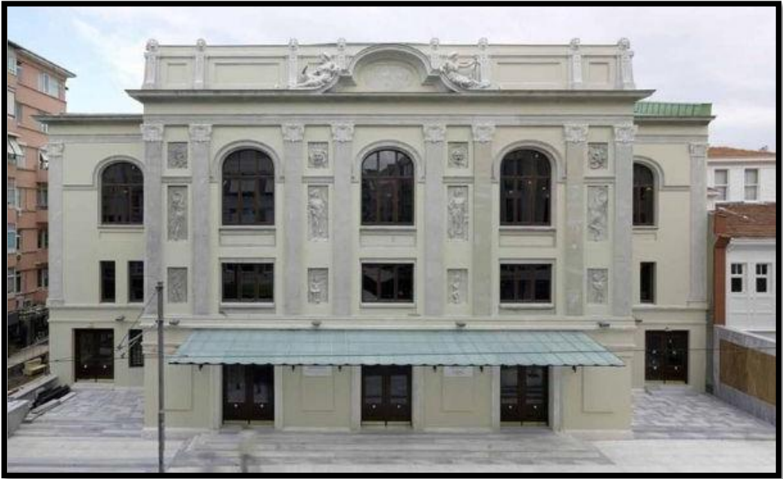
Şekil 4.20 Süreyya Operası Restorasyon Sonrası
