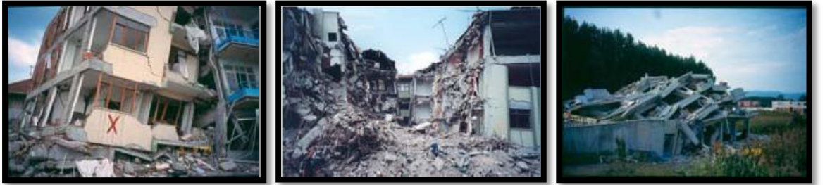
Şekil 4.30 Marmara Depremi Şekil 4.29 Marmara Depremi Şekil 4.28 Marmara Depremi
