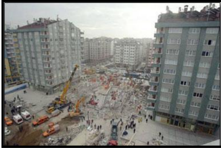
Şekil 4.4 Yıkılan Zümrüt Apartmanı'nın görünüşü.
