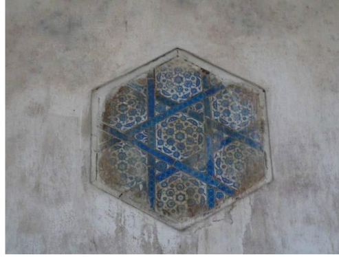
Resim 46: İstanbul – Çinili Hamam Sıcaklık Mekânı Çinileri
