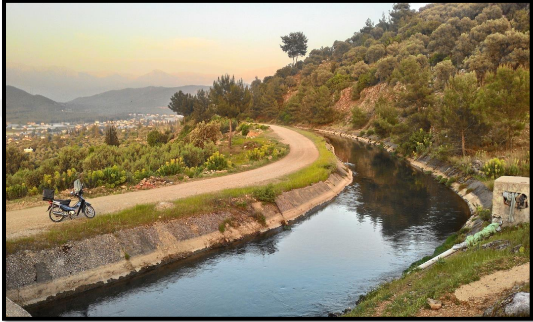
Foto 56. Bademli Mahallesi'ndeki DSİ Tarafından Yapılan Su Kanalındaki Bir Görünüm
